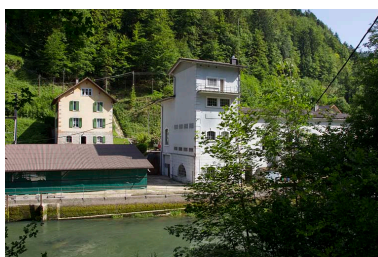
Centrale de la Goule : logement et centrale. Phot. Mathias Papigny IVR43_20130000008NUC2A
