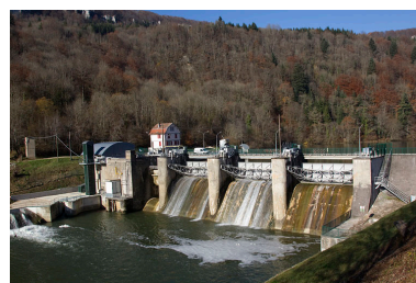
Barrage de Grosbois, vu de la rive gauche en aval. Phot. Yves Sancey IVR43_20122502000NUC2A
