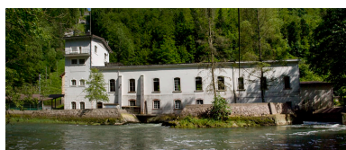
Centrale de la Goule : façade côté Doubs. Phot. Mathias Papigny IVR43_20130000011NUC2A
