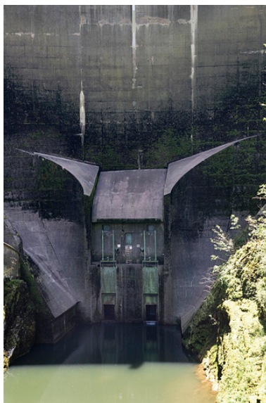
Barrage du Châtelot : vannes de fond. Phot. Laurent Poupard IVR43_20130000021NUC2A
