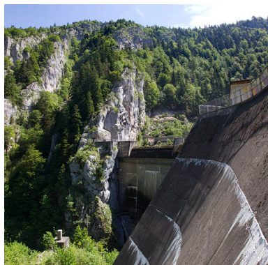
Barrage du Châtelot : ancrage rive droite. Phot. Laurent Poupard IVR43_20130000012NUC2A
