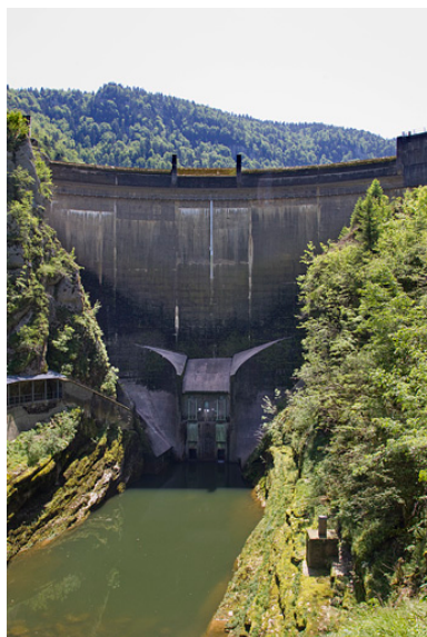
Barrage du Châtelot : face aval. Phot. Laurent Poupard IVR43_20130000020NUC2A
