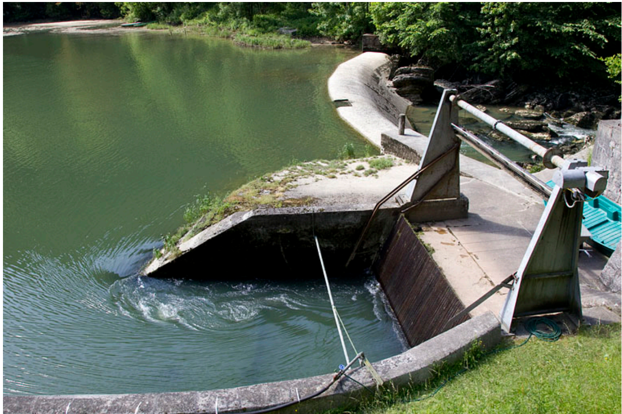
Barrage de la Goule : l'ouvrage de prise d'eau.
