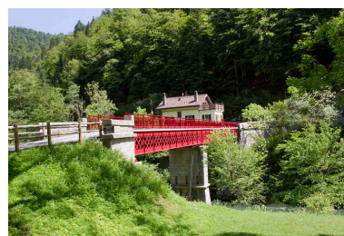
La Rasse : le pont vu depuis la rive gauche. Phot. Yves Sancey IVR43_20132500794NUC2A
