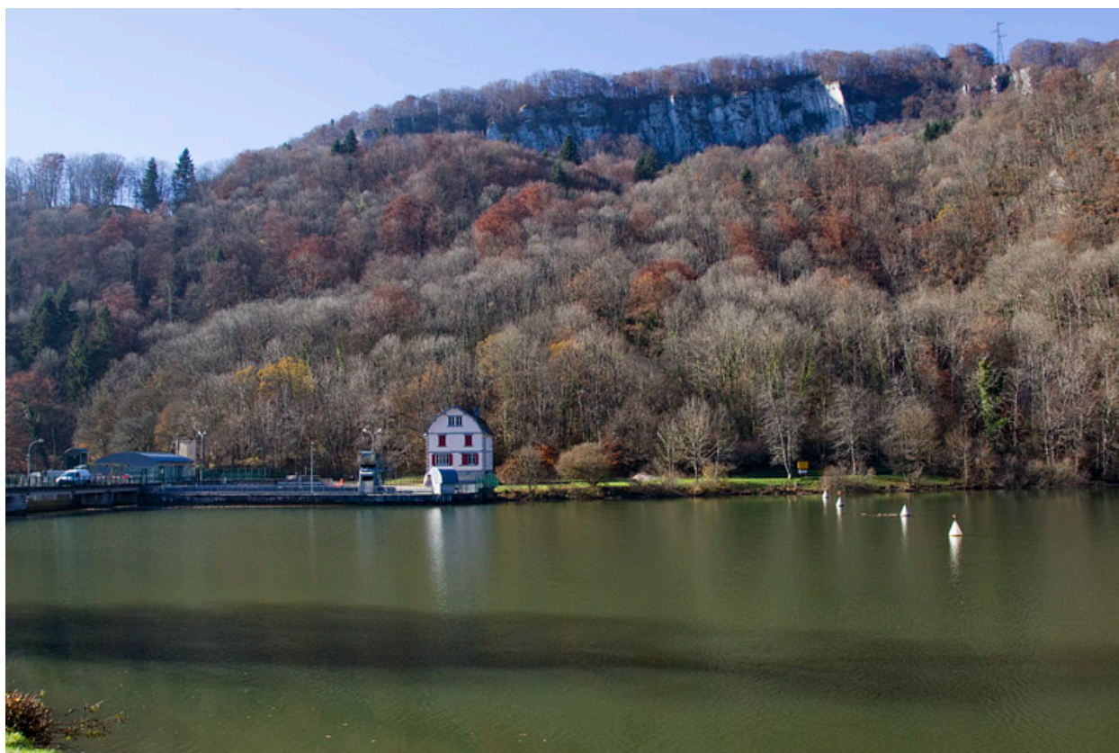
Barrage de Grosbois (commune de Soultz-Cernay) : vue d'ensemble depuis la rive gauche, en amont.
