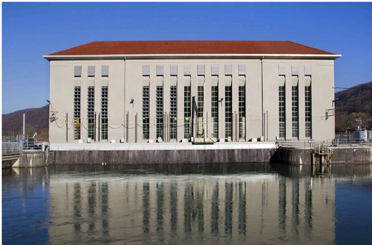
Centrale de Dampjoux : façade amont.
