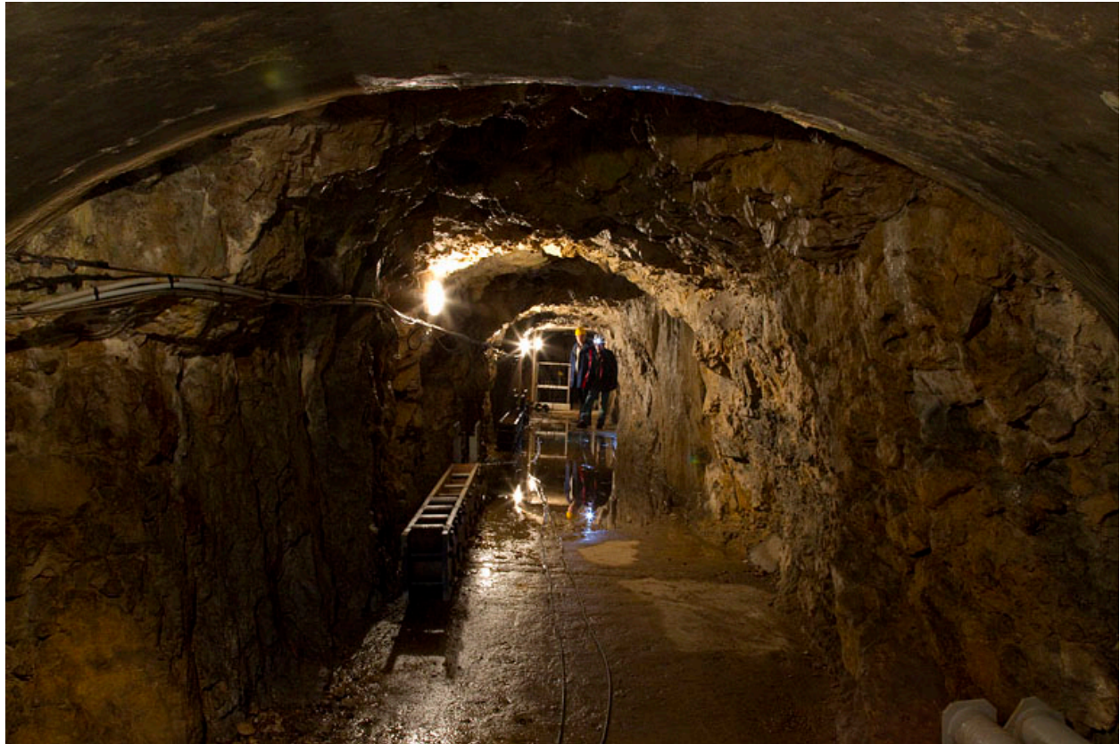
Centrale de Liebvillers : galerie d'accès à la conduite d'amenée souterraine.
