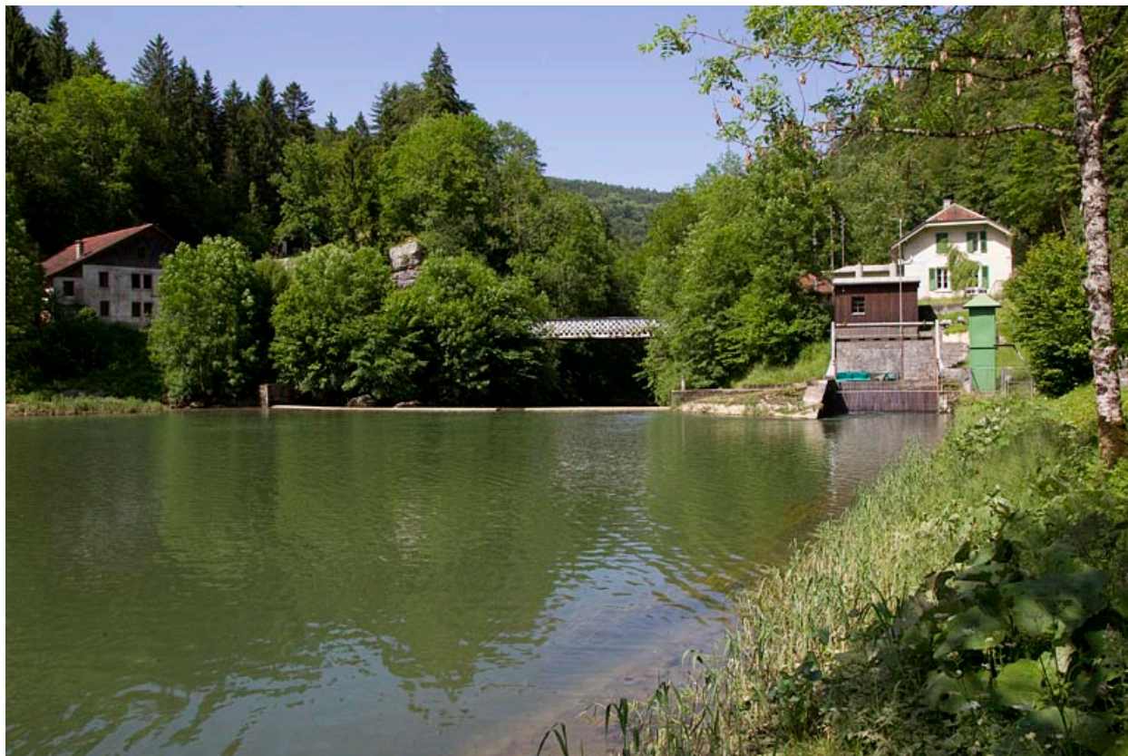
Barrage de la Goule (communes de Charmauvillers, France, et du Noirmont, Suisse), vu de l'amont.
