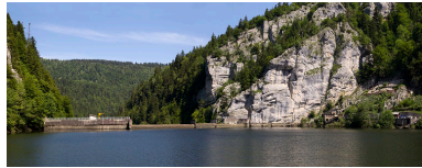
Barrage du Châtelot, vu du plan d'eau en amont. Phot. Laurent Poupard IVR43_20130000016NUC2A
