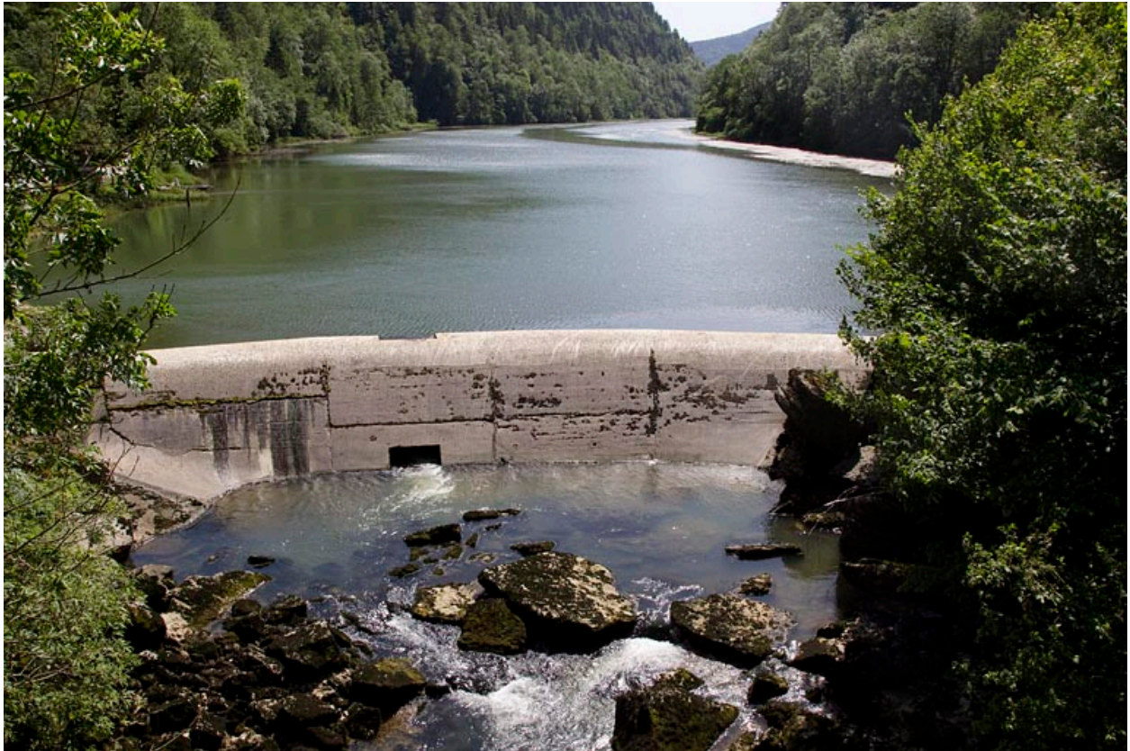
Barrage de la Goule : face aval.
