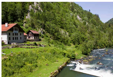
La Rasse : le restaurant et l'emplacement des usines détruites, à l'extrémité du barrage. Phot. Yves Sancey IVR43_20132500795NUC2A
