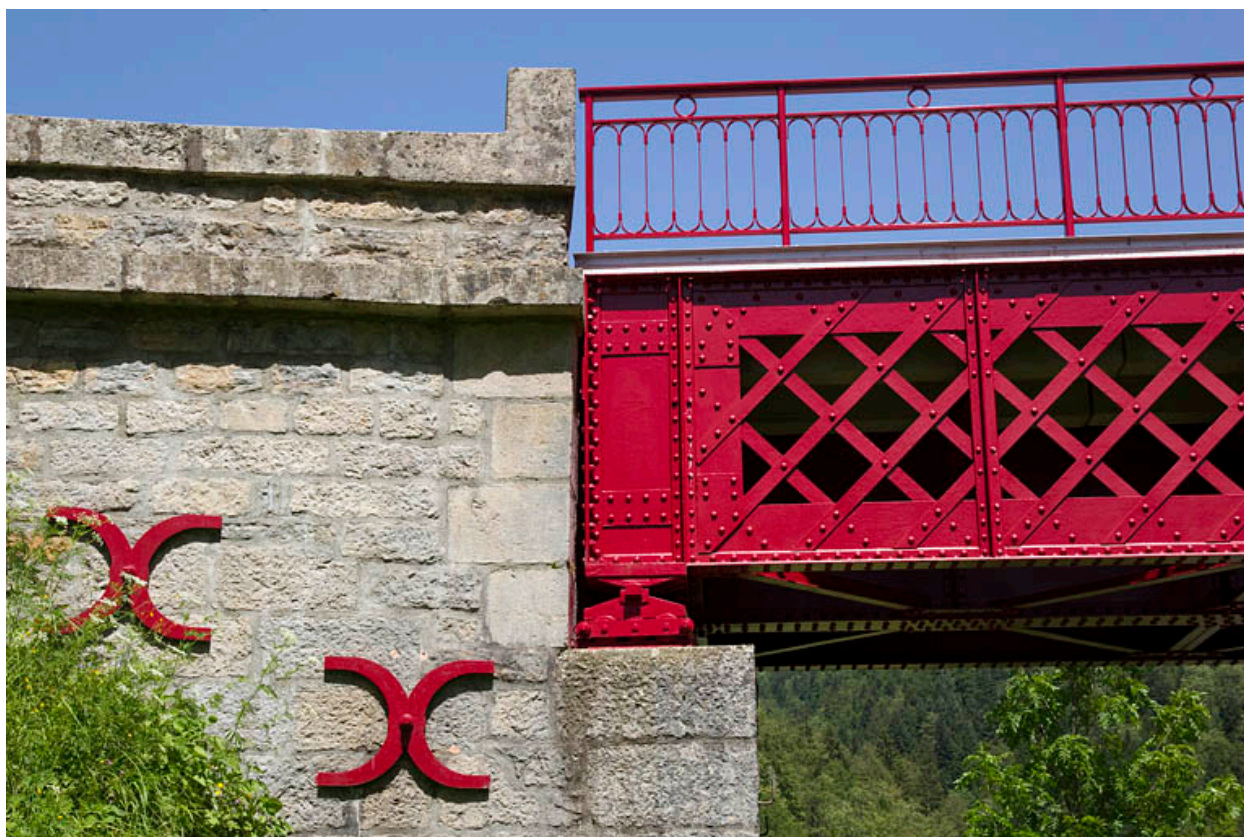
La Rasse : le support du tablier du pont sur la rive gauche.
