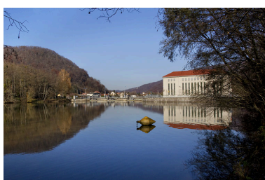
Centrale de Dampjoux (commune de Noirefontaine) : vue d'ensemble depuis l'amont. Phot. Yves Sancey IVR43_20122501969NUC2A
