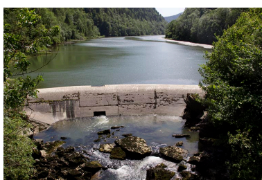
Barrage de la Goule : face aval. Phot. Yves Sancey IVR43_20130000001NUC2A
