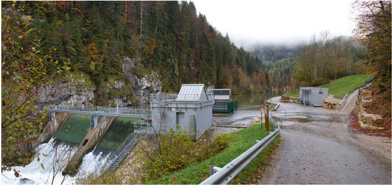
Barrage du Refrain : vue d'ensemble depuis l'aval.
