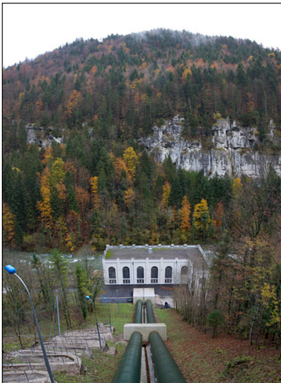
Centrale du Refrain (commune de Charquemont) : vue plongeante depuis le haut de la conduite forcée.
