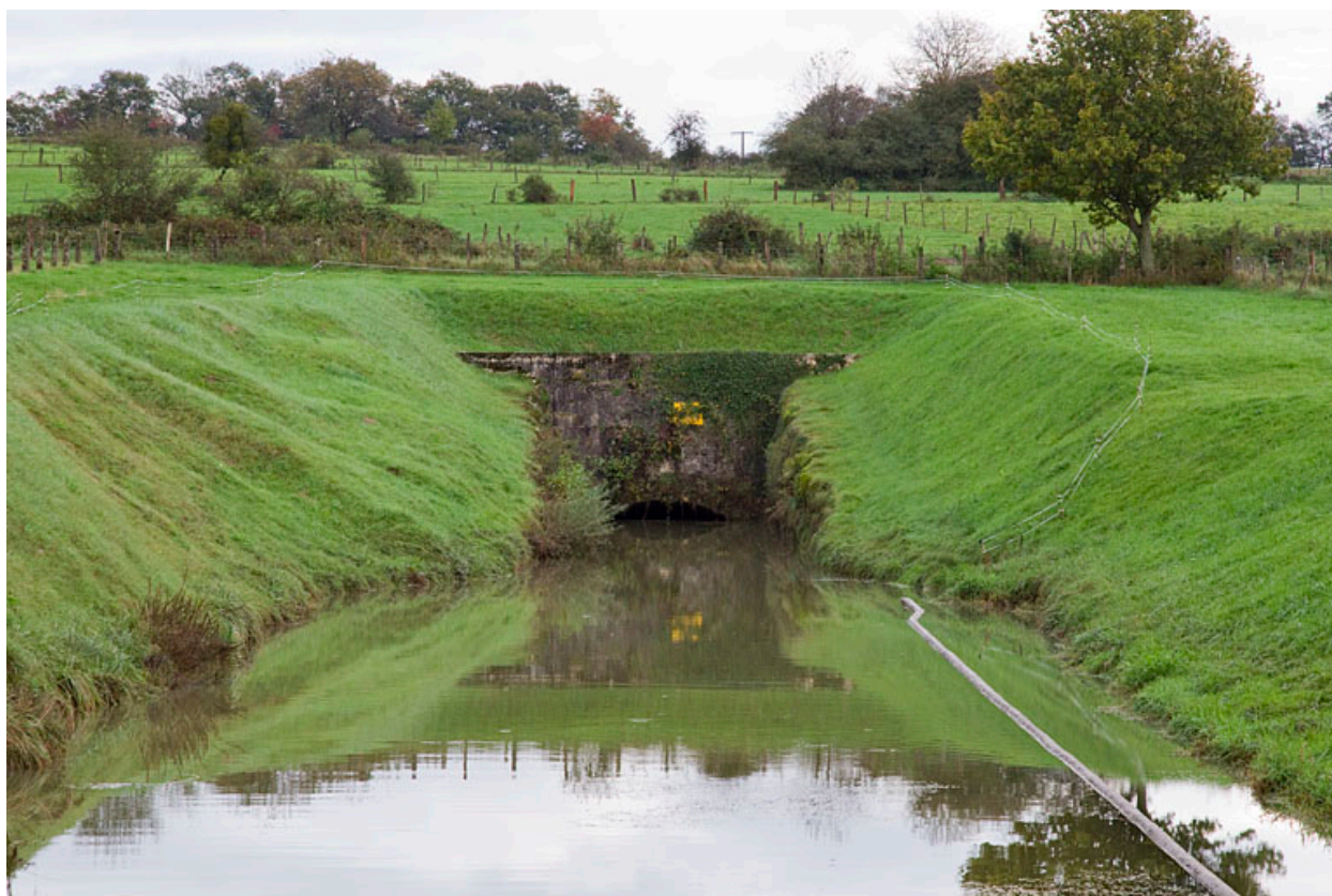
Centrale de la Prétière : extrémité du canal d'amenée souterrain.
