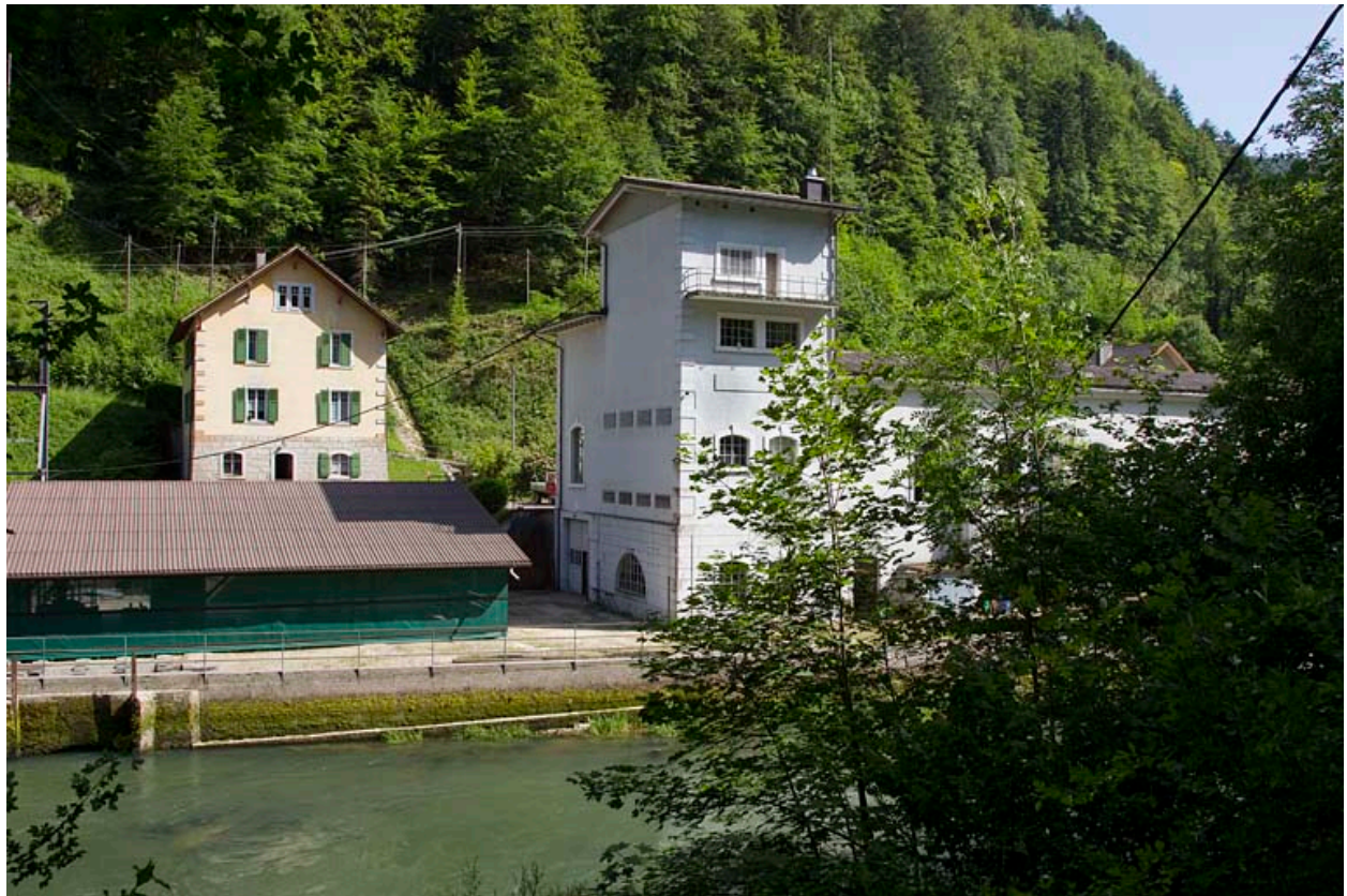
Centrale de la Goule : logement et centrale.
