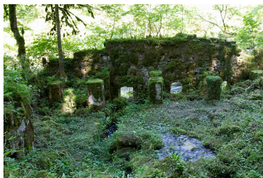
Site du Bief d'Etoz : mur en ruine de la scierie Pierre, donnant sur le Doubs. Phot. Laurent Poupard IVR43_20132500797NUC2A
