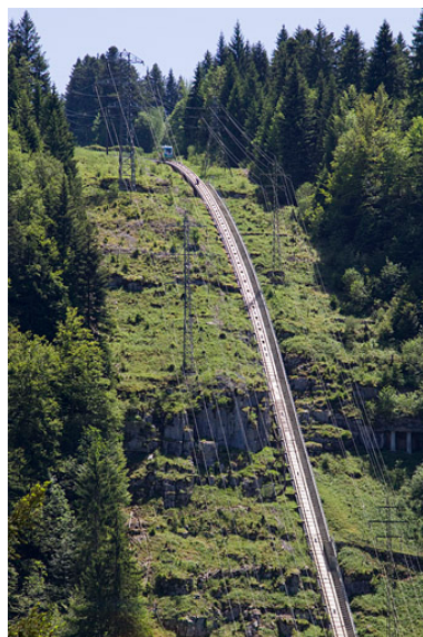
Centrale du Châtelot : vue rapprochée du funiculaire. Phot. Mathias Papigny IVR43_20130000025NUC2A
