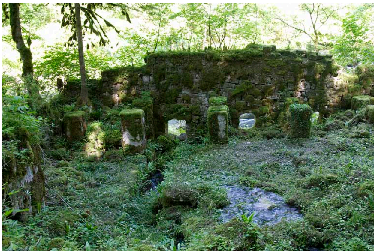
Site du Bief d'Etoz : mur en ruine de la scierie Pierre, donnant sur le Doubs.
