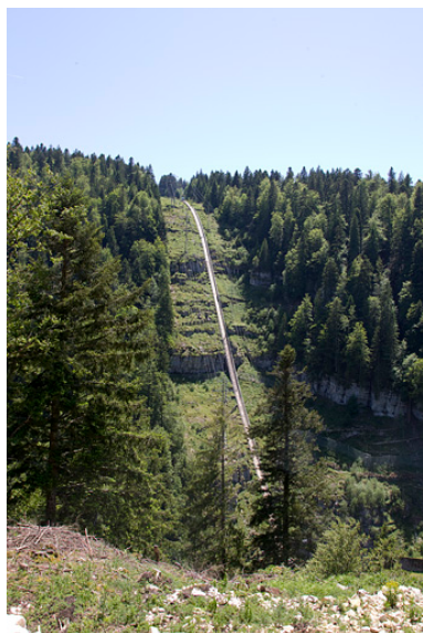
Centrale du Châtelot (commune des Planchettes, Suisse) : le funiculaire utilisé pour accéder au site. Phot. Mathias Papigny IVR43_20130000024NUC2A
