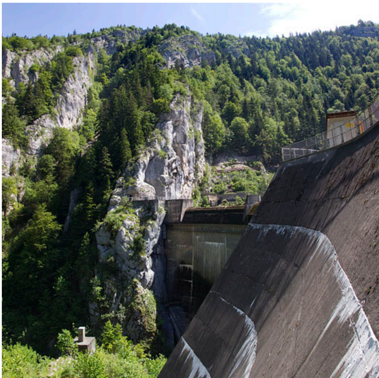
Barrage du Châtelot : ancrage rive droite.
