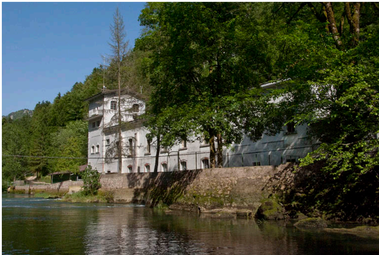
Centrale de la Goule : façade côté Doubs, vue de trois quarts droite.
