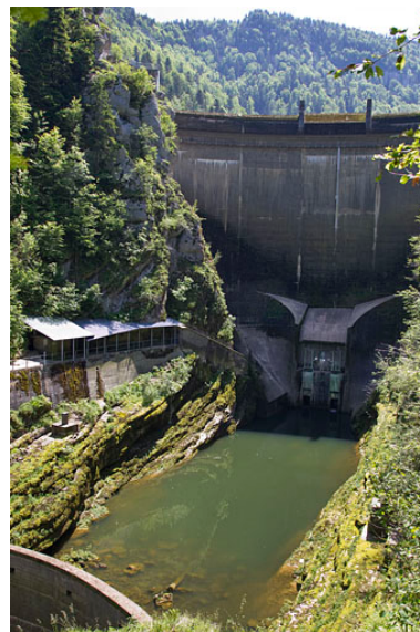
Barrage du Châtelot : le bassin d'amortissement. Phot. Laurent Poupard IVR43_20130000022NUC2A
