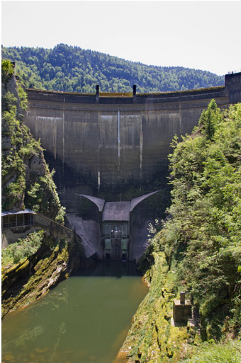
Barrage du Châtelot : face aval.
