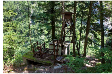
Barrage du Châtelot : support du téléphérique utilisé pour la construction, situé en aval sur la rive gauche. Phot. Laurent Poupard IVR43_20130000023NUC2A
