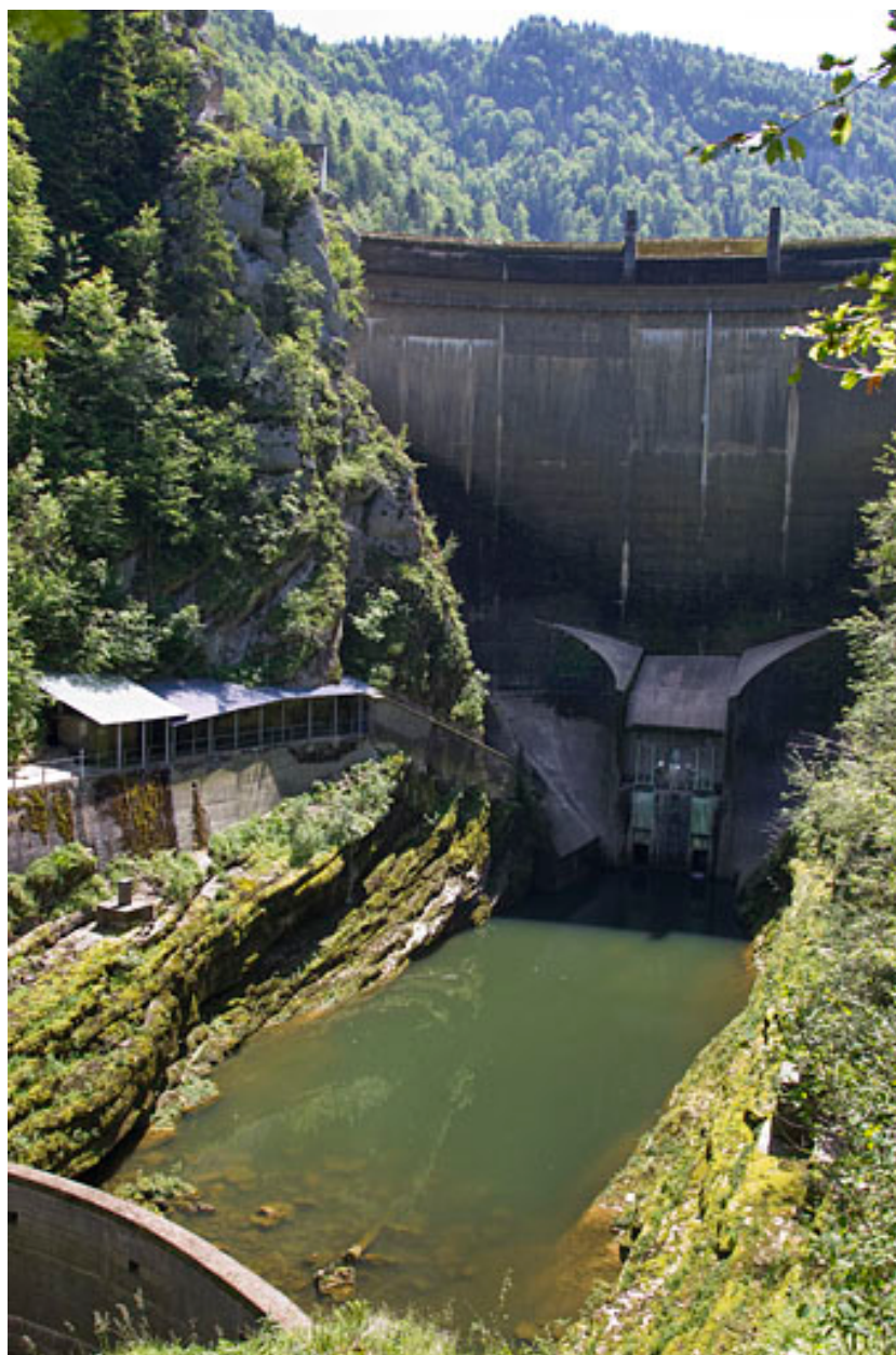
Barrage du Châtelot : le bassin d'amortissement.
