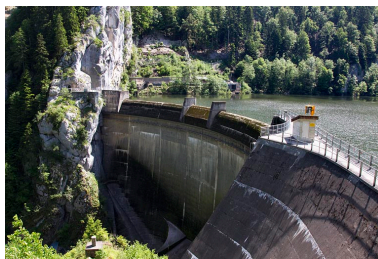
Barrage du Châtelot : la face aval depuis l'ancrage rive gauche. Phot. Laurent Poupard IVR43_20130000015NUC2A
