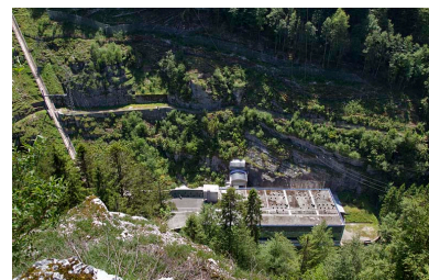
Centrale du Châtelot : vue plongeante sur le funiculaire et la centrale. Phot. Mathias Papigny IVR43_20130000026NUC2A
