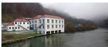
Centrale de Liebvillers : vue d'ensemble des bâtiments de production et du site de transformation. Phot. Yves Sancey IVR43_20122502014NUC2A
