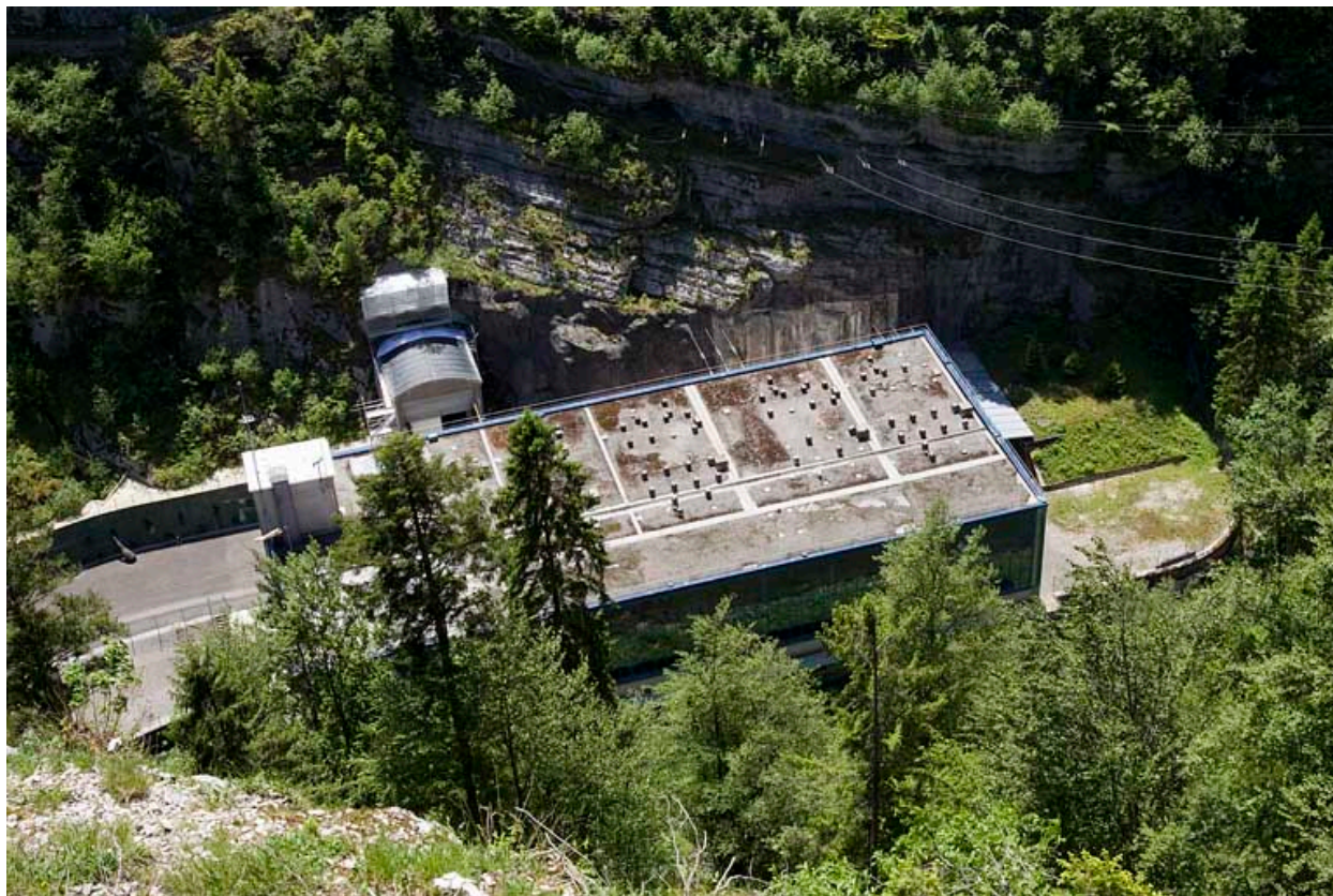
Centrale du Châtelot : vue plongeante sur la centrale.
