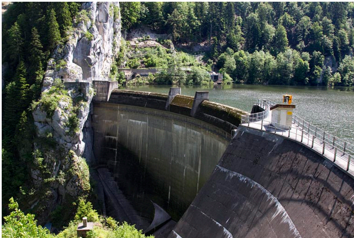
Barrage du Châtelot : la face aval depuis l'ancrage rive gauche.
