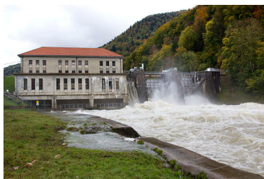
Centrale de Vaufrey : vue d'aval en période de crue. Phot. Yves Sancey IVR43_20122502182NUC2A
