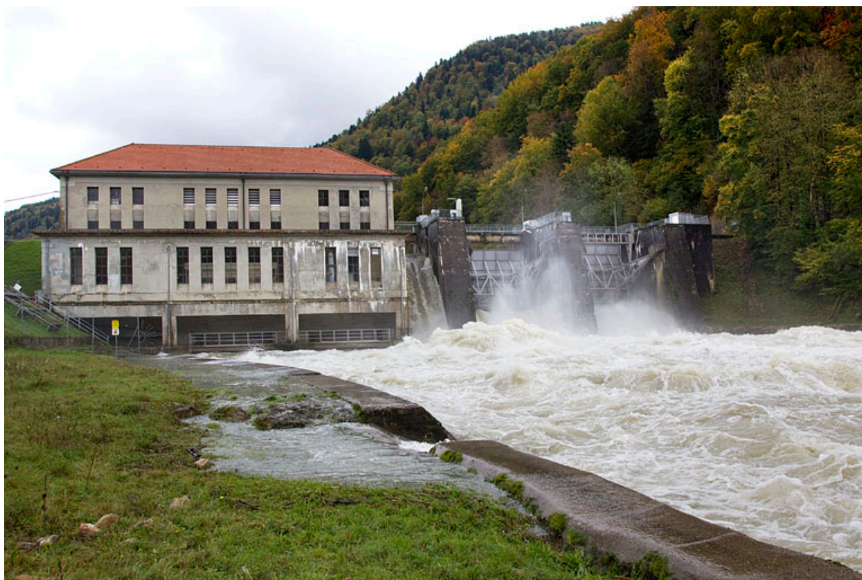
Centrale de Vaufrey : vue d'aval en période de crue.
