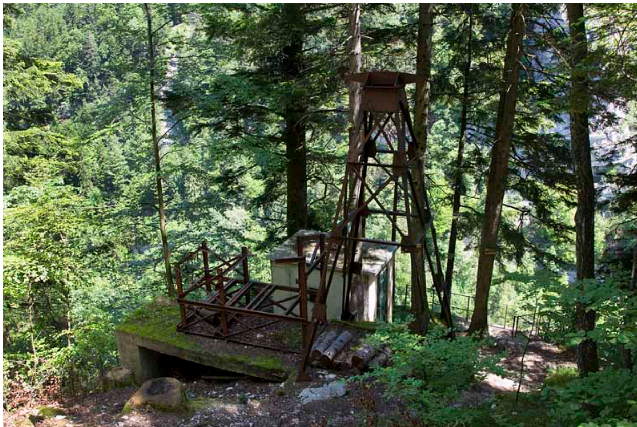
Barrage du Châtelot : support du téléphérique utilisé pour la construction, situé en aval sur la rive gauche.
