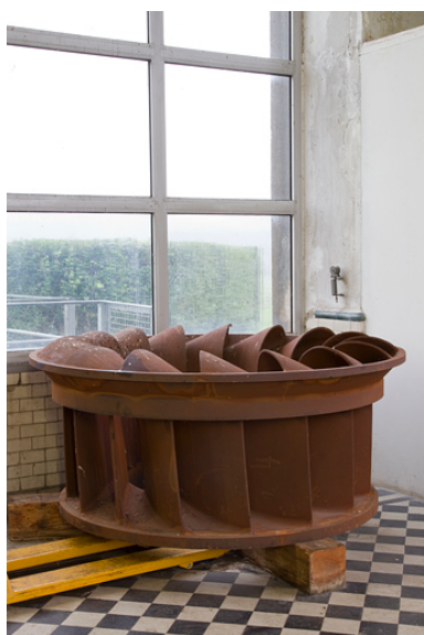
Centrale de la Prétière : turbine Francis déposée.
