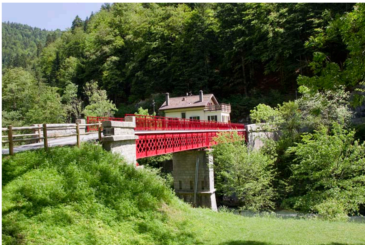
La Rasse : le pont vu depuis la rive gauche.
