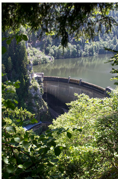
Barrage du Châtelot : vue plongeante depuis la rive gauche. Phot. Laurent Poupard IVR43_20130000014NUC2A
