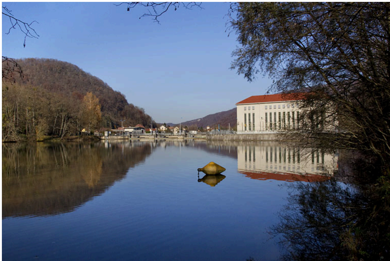
Centrale de Dampjoux (commune de Noirefontaine) : vue d'ensemble depuis l'amont.
