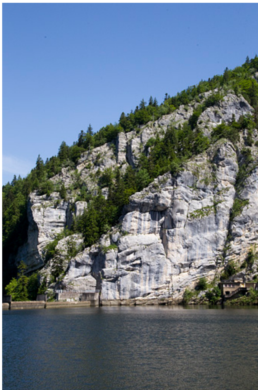
Barrage du châtelot : le rocher rive droite, depuis l'amont.
