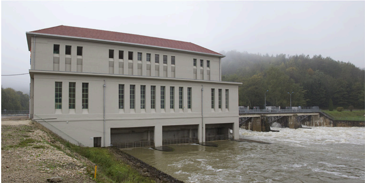
Centrale de Dampjoux : vue d'ensemble depuis l'aval, rive droite.
