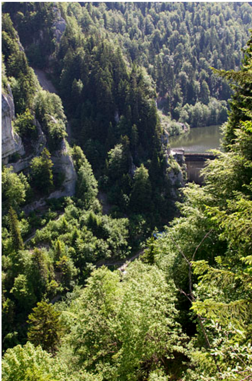
Barrage du Châtelot (communes de Villers-le-Lac, France, et des Planchettes, Suisse) : vue plongeante sur la vallée.
