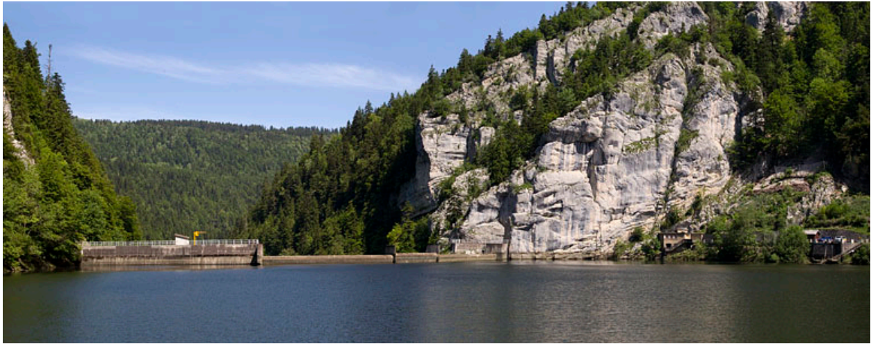
Barrage du Châtelot, vu du plan d'eau en amont.
