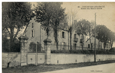
Vue ancienne. Autr. auteur inconnu IVR26_20205800362NUC4A
