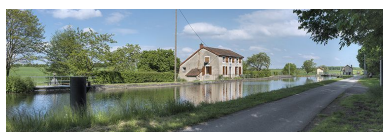
Vue d'ensemble du site de l'écluse dite de la Tranchée à Chagny avec, au centre, la maison éclusière et, à gauche, le déversoir.
