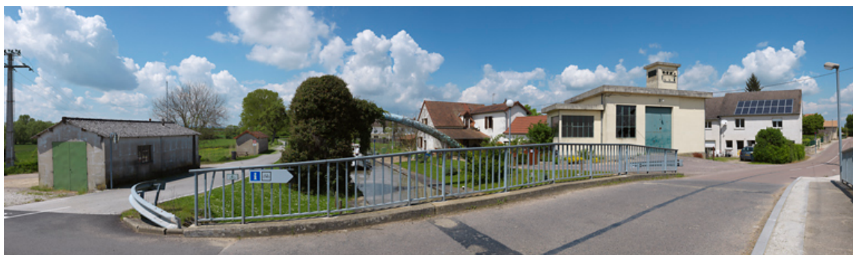
Vue d'ensemble du site de l'écluse 34 du versant Méditerranée à Fragnes, depuis le pont.
