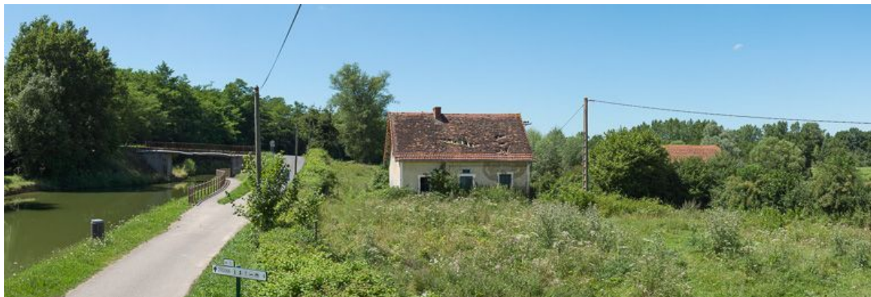
Vue d'ensemble de l'ancien site de l'écluse XXVII, dite du Paradis, à Vitry-en-Charollais.
