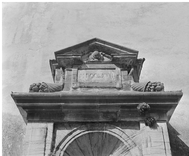
Le couronnement. Phot. Yves Sancey IVR43_19853900333X
