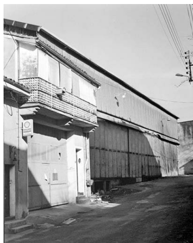
Façades sur la rue du Soujet : logette du garage (I) et atelier de fabrication (L).
