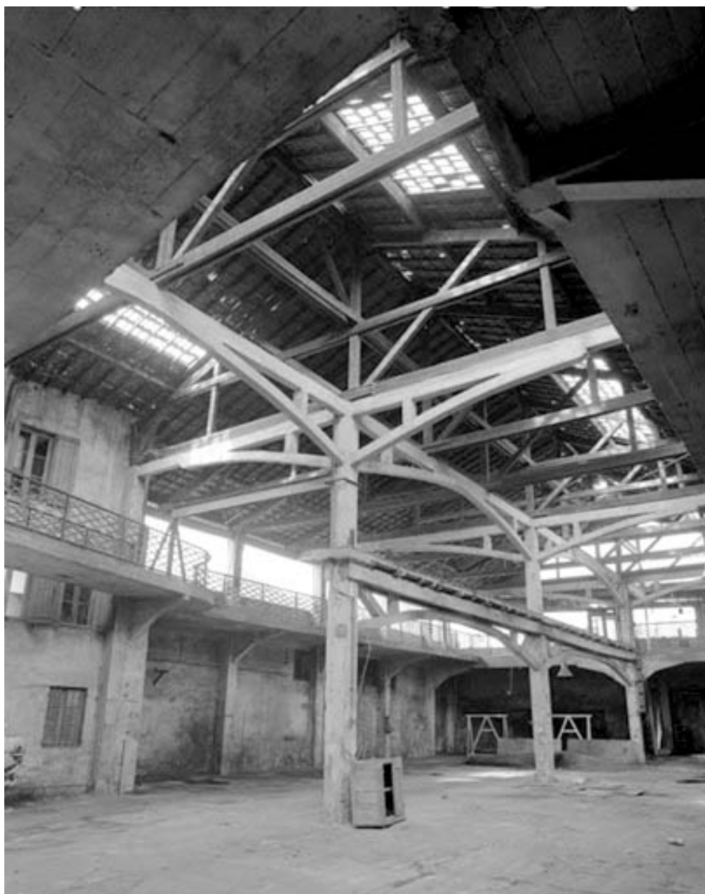
Cour couverte et atelier des presses (B) : poteaux en béton armé.
