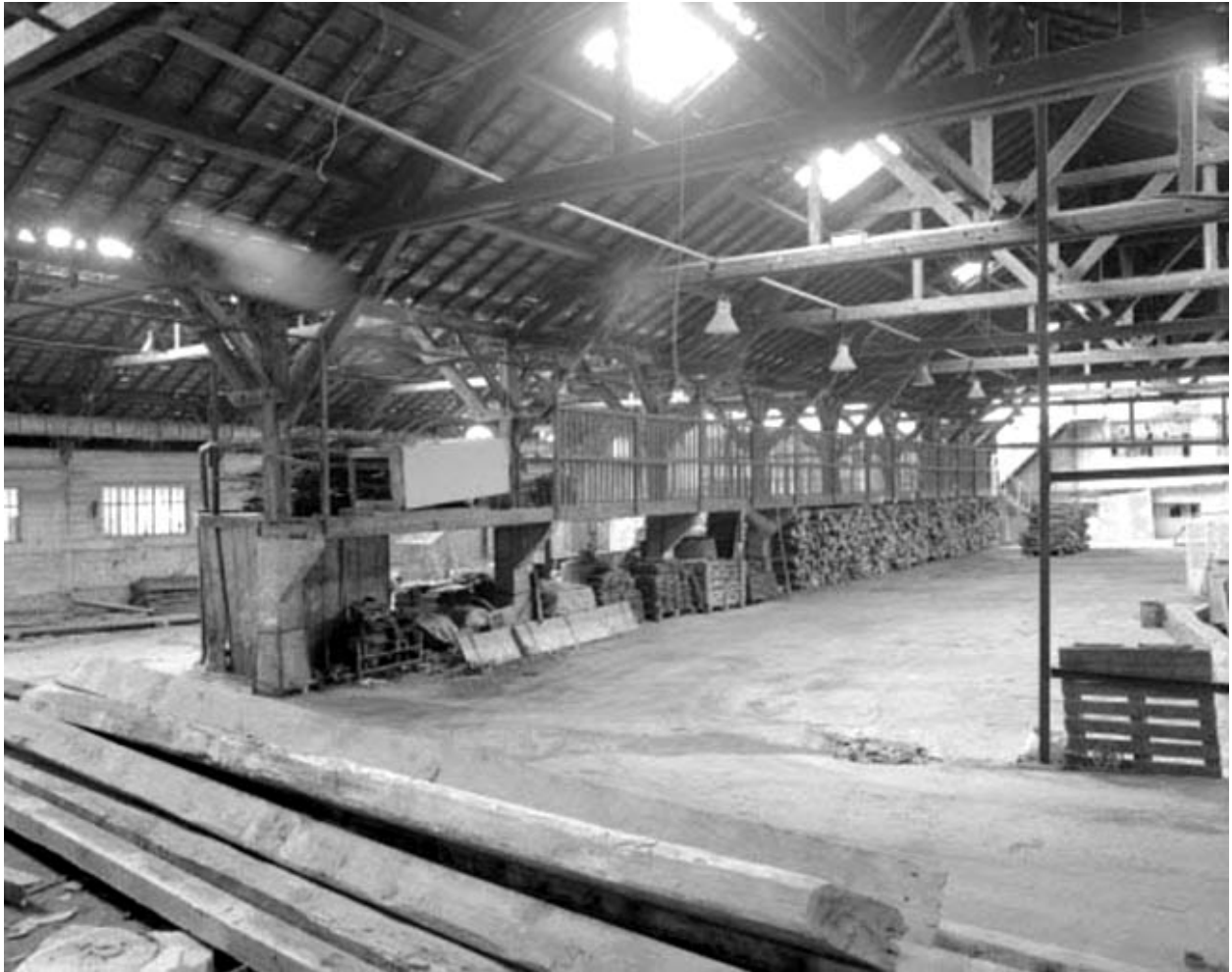
Ateliers de fabrication (J) : intérieur du parc à tôles (J2).Rampe d'accès au premier plan, quai d'expédition dans le vaisseau (J1) à gauche.
