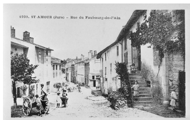
St-Amour (Jura) - Rue du Faubourg-de-l'Ain, 1er quart 20e siècle. Phot. , Phot. Jean Combier IVR43_19933900420X
