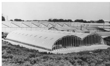
Bâtiment métallique construit dans l'usine de matériel électrique industriel de la S.A. Gec Alsthom à Mâcon, 1965. Détruit en 1984, ce bâtiment servait de hall de montage et de magasin.
