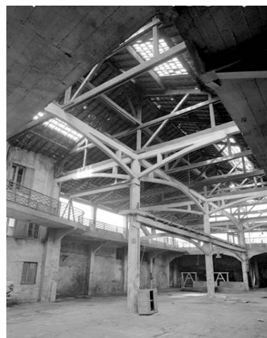
Cour couverte et atelier des presses (B) : poteaux en béton armé. Phot. Yves Sancey IVR43_19943901682X
