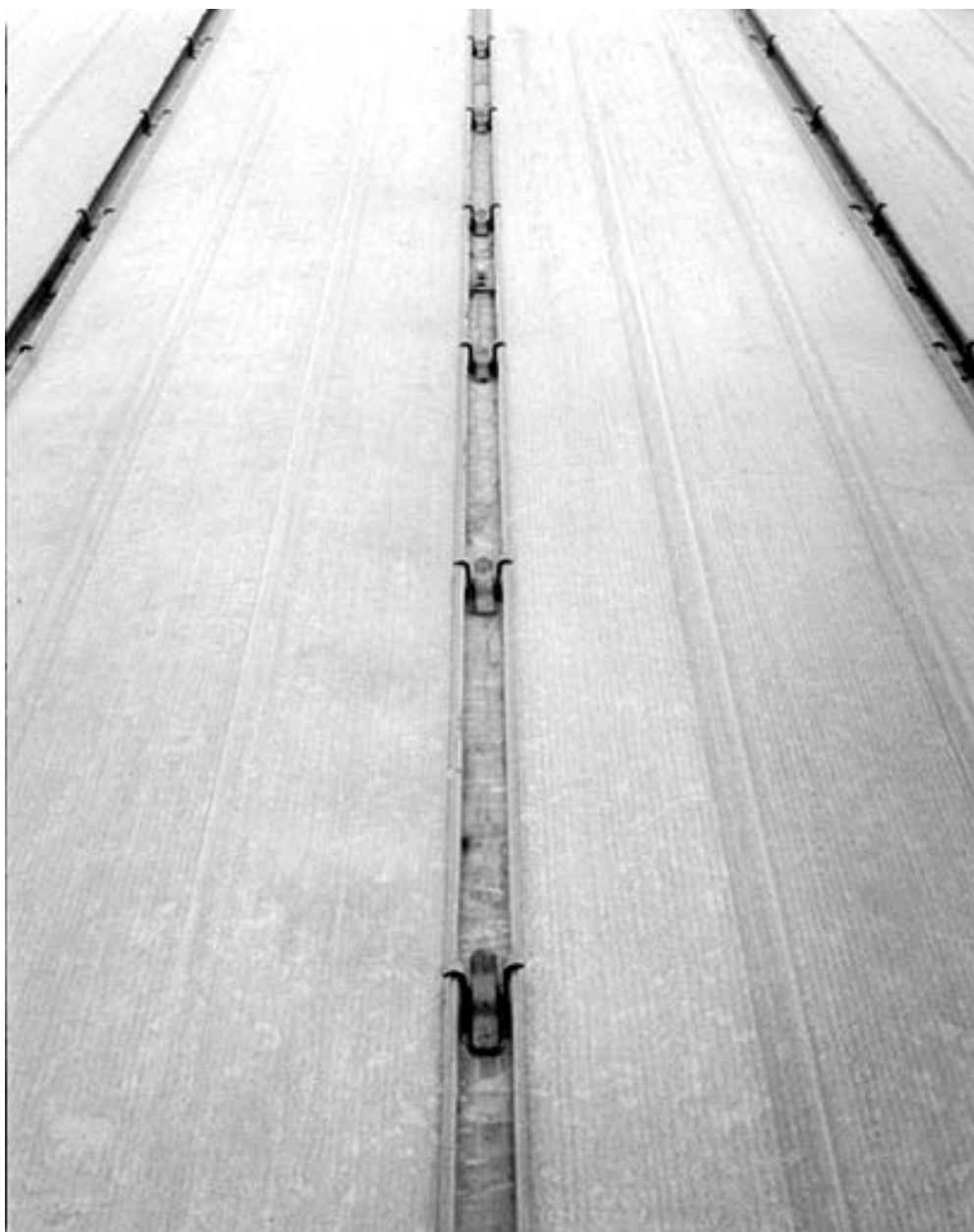
Atelier de fabrication (K) : détail des panneaux métalliques du mur.
