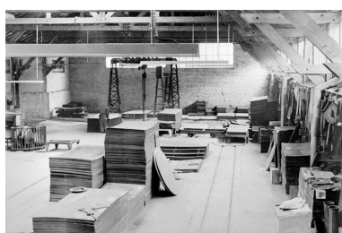
Intérieur de l'entrepôt industriel (J2) avec traçage et découpage, années 1950. Phot. IVR43_19933900220X
