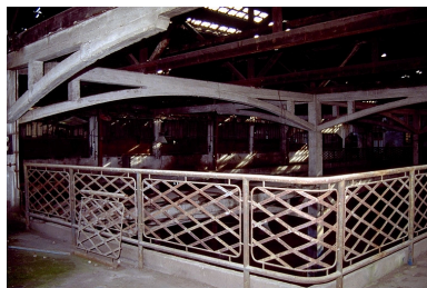
Cour couverte et atelier des presses (B) : galerie à l'étage. Phot. Yves Sancey IVR43_19943901685ZA
