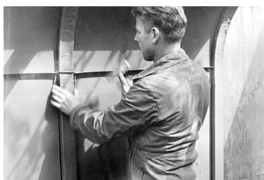
Montage d'un baraquement métallique dans les années 1940 : pose d'une agrafe. Phot. IVR43_19903901219X
