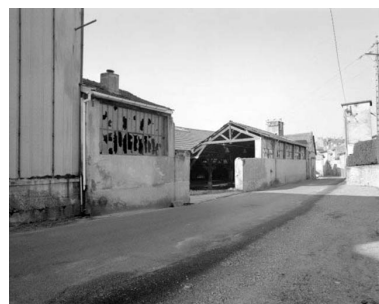
Façades sur la rue d'Allonal et entrée des ateliers (J).
