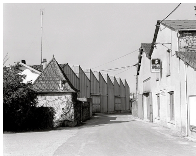
Façades sur la rue d'Allonal : atelier de fabrication (K). Phot. Yves Sancey IVR43_19943901672X
