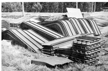
Montage d'un baraquement métallique dans les années 1940 : stockage des tôles. Phot. IVR43_19933900205X
