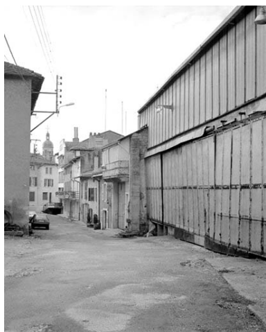
Façades sur la rue du Soujet.
