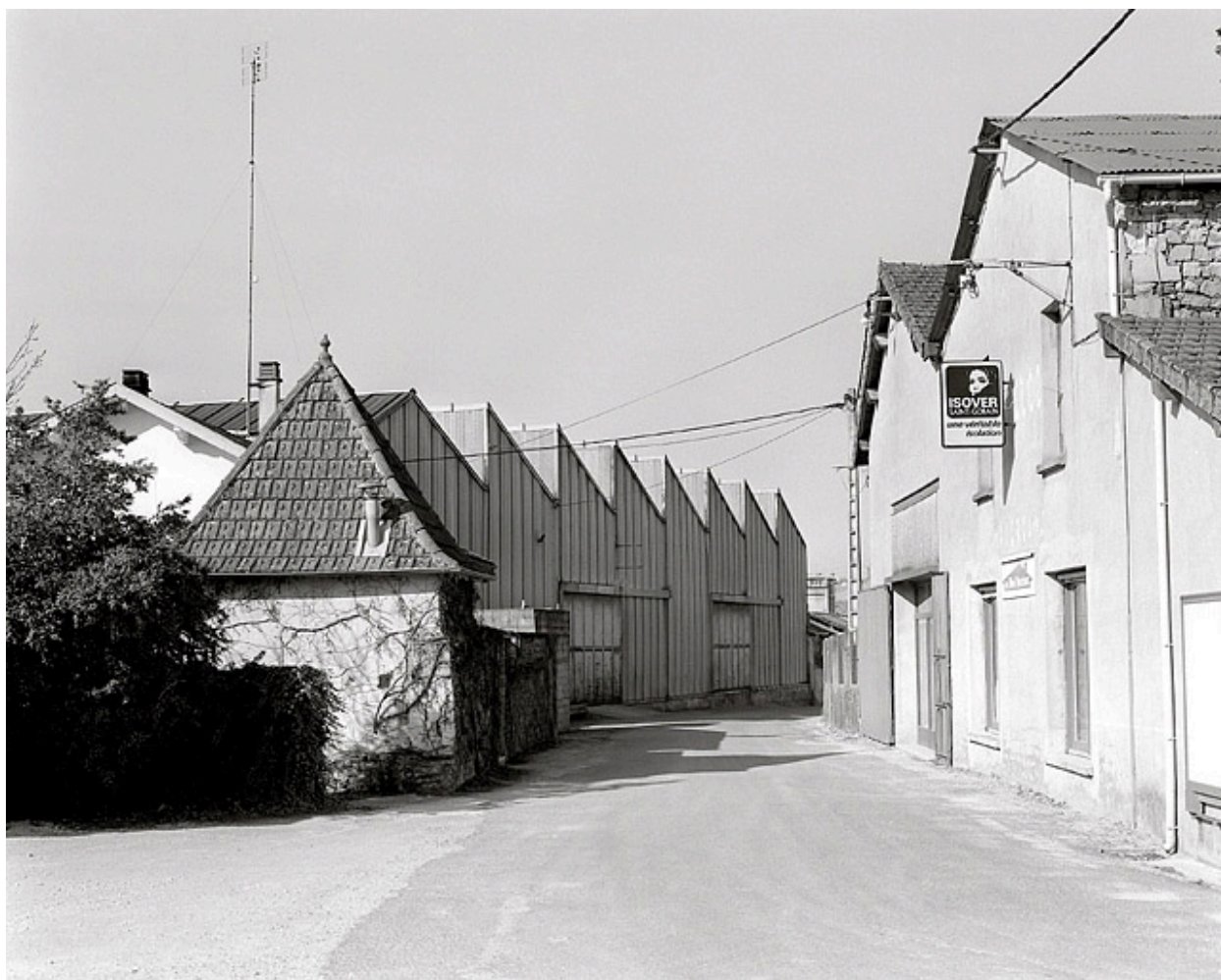
Façades sur la rue d'Allonal : atelier de fabrication (K).
