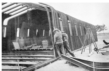
Montage d'un baraquement métallique dans les années 1940 : mise en place d'une tôle du mur. Phot. IVR43_19933900207X
