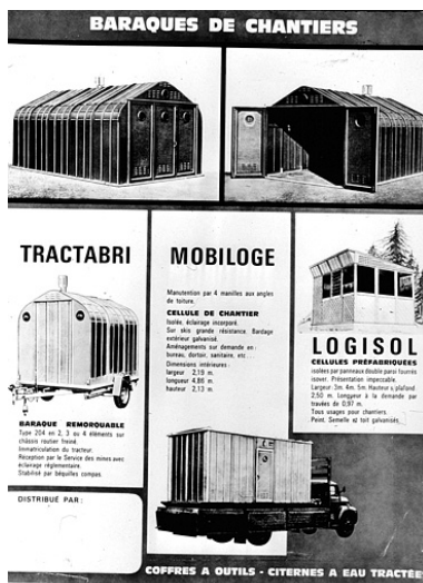
Baraques et cellules de chantier, début des années 1960.
