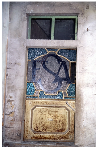
Cour couverte et atelier des presses (B) : porte d'accès à l'ancien hôtel de voyageurs (A). Phot. Yves Sancey IVR43_19943901688ZA
