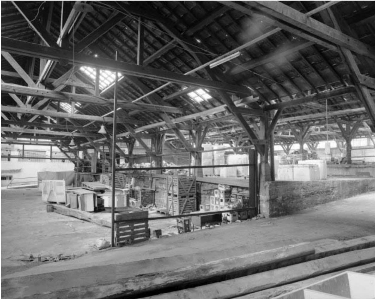
Ateliers de fabrication (J) : intérieur du parc à tôles (J2). Rampe d'accès au premier plan, atelier des presses dans le vaisseau (J3) à droite.
