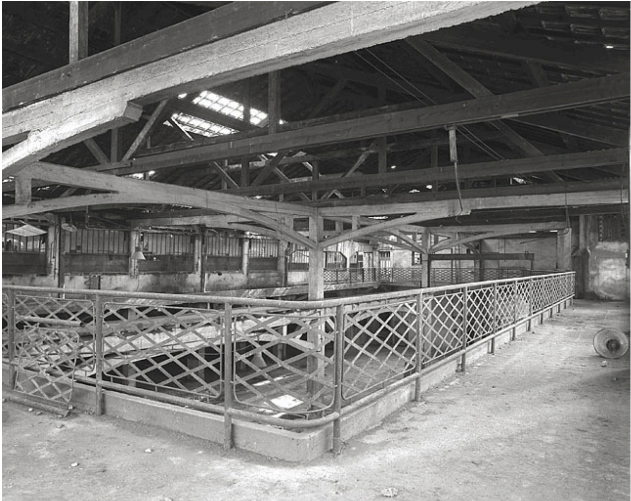
Cour couverte et atelier des presses (B) : galerie à l'étage.
