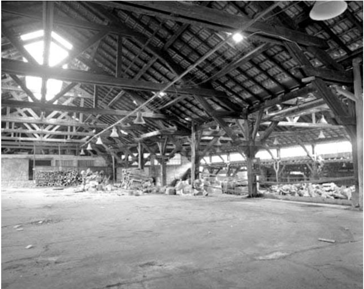
Ateliers de fabrication (J) : intérieur de l'atelier de soudure (J4). Rampe d'accès au fond, atelier des presses dans le vaisseau (J3) à droite.
