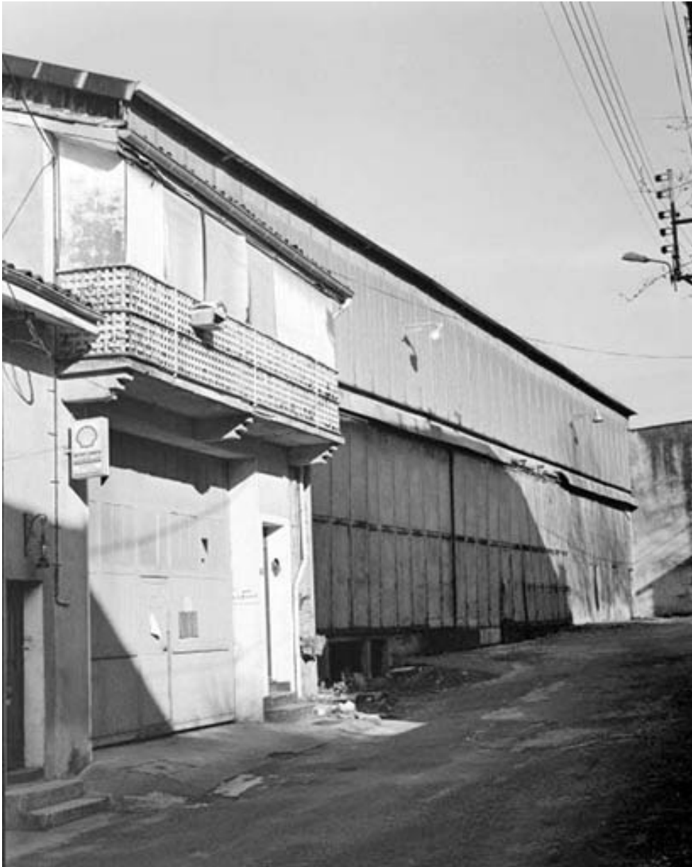
Façades sur la rue du Soujet : logette du garage (I) et atelier de fabrication (L).
