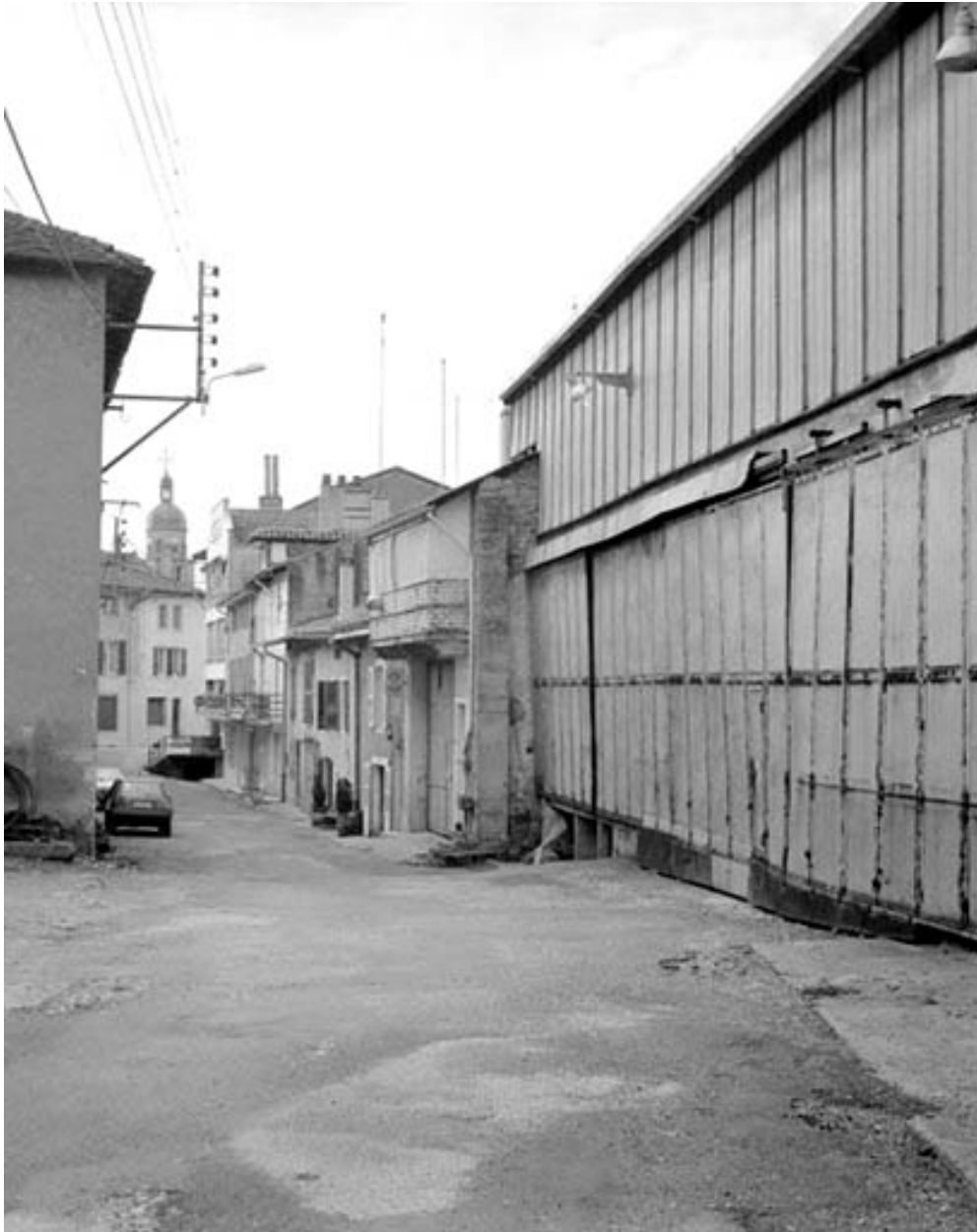
Façades sur la rue du Soujet.
