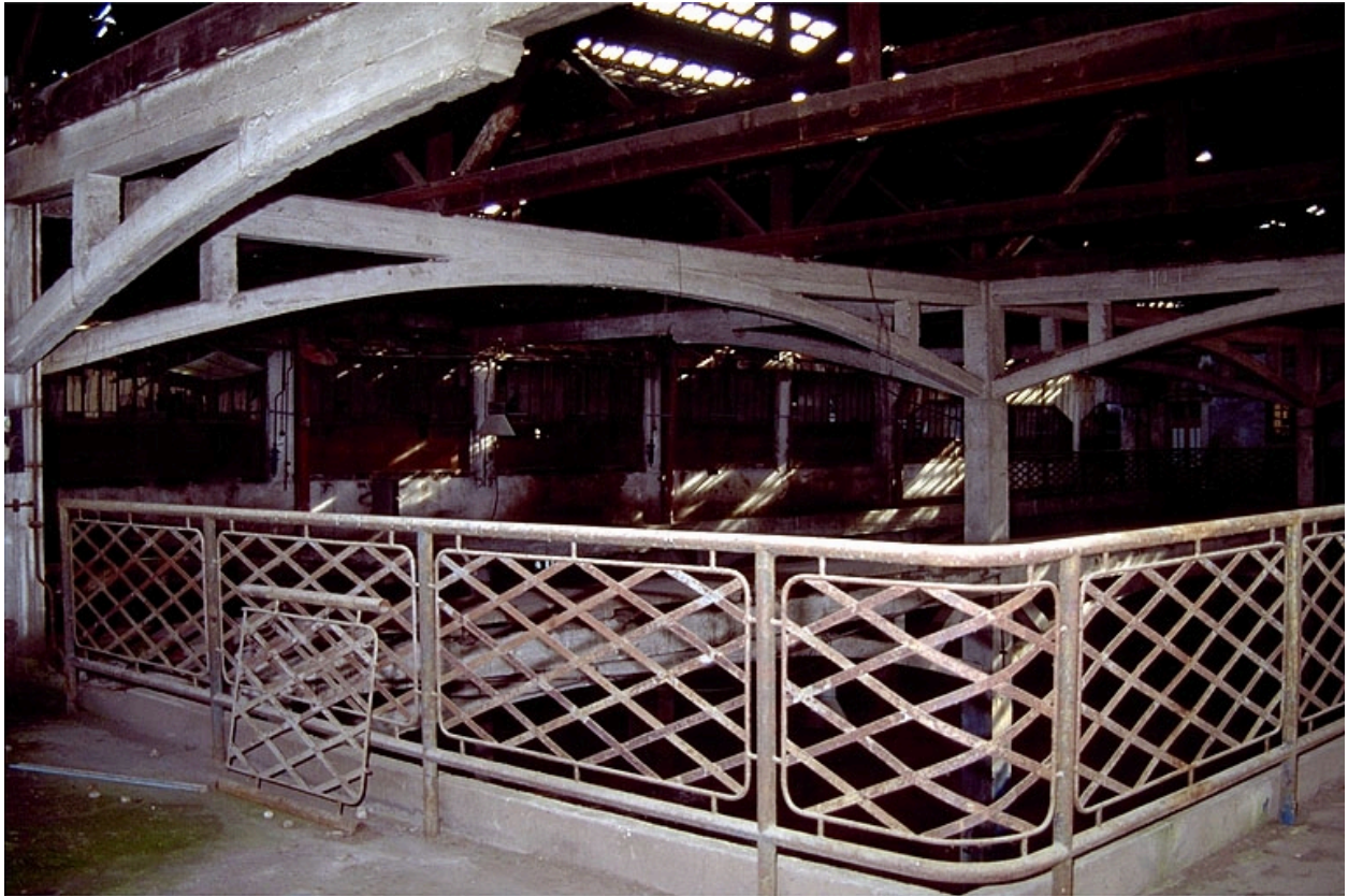
Cour couverte et atelier des presses (B) : galerie à l'étage.
