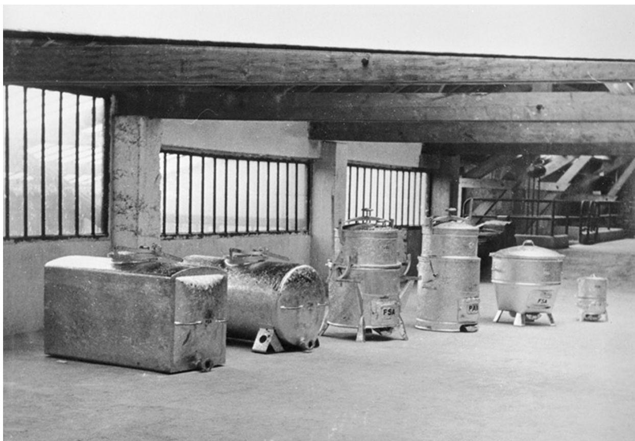
Réservoirs et chaudières à marmite F.S.A. dans l'atelier (D), années 1950.
