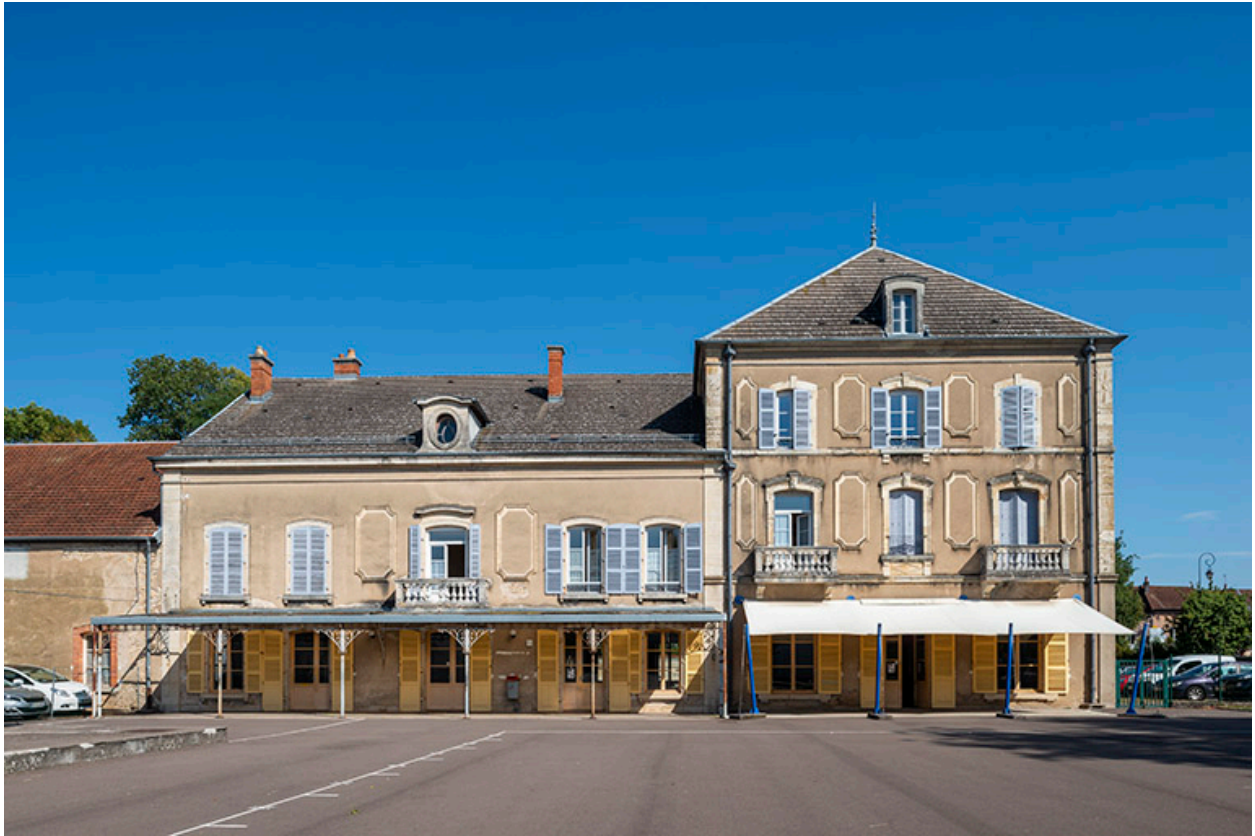
Façade sur l'ancien jardin, vue de face.
