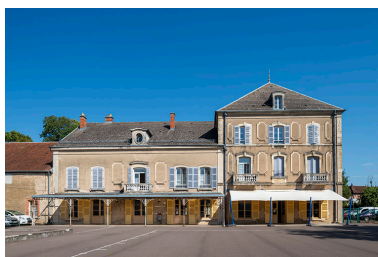
Façade sur l'ancien jardin, vue de face. Phot. Jérôme Mongreville IVR43_20187000620NUC4A
