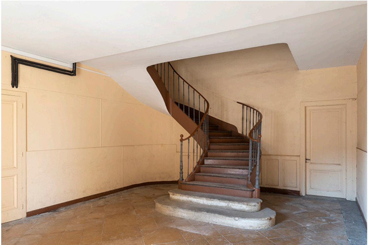
Escalier du corps central, vue de trois-quarts gauche.
