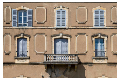
Corps de bâtiment sud, premier étage et second étage, vue de face. Phot. Jérôme Mongreville IVR43_20187000611NUC4A
