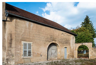
Corps de bâtiment nord, vue de trois-quarts droit, et arcade. Phot. Jérôme Mongreville IVR43_20187000618NUC4A
