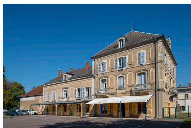
Façade sur l'ancien jardin, vue de trois-quarts gauche. Phot. Jérôme Mongreville IVR43_20187000621NUC4A
