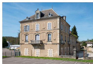
Corps de bâtiment sud, vue de trois-quarts gauche. Phot. Jérôme Mongreville IVR43_20187000610NUC4A
