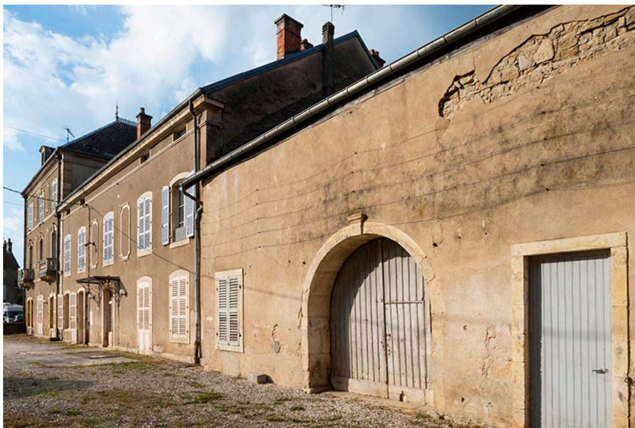
Corps de bâtiment nord, vue de trois-quarts gauche.
