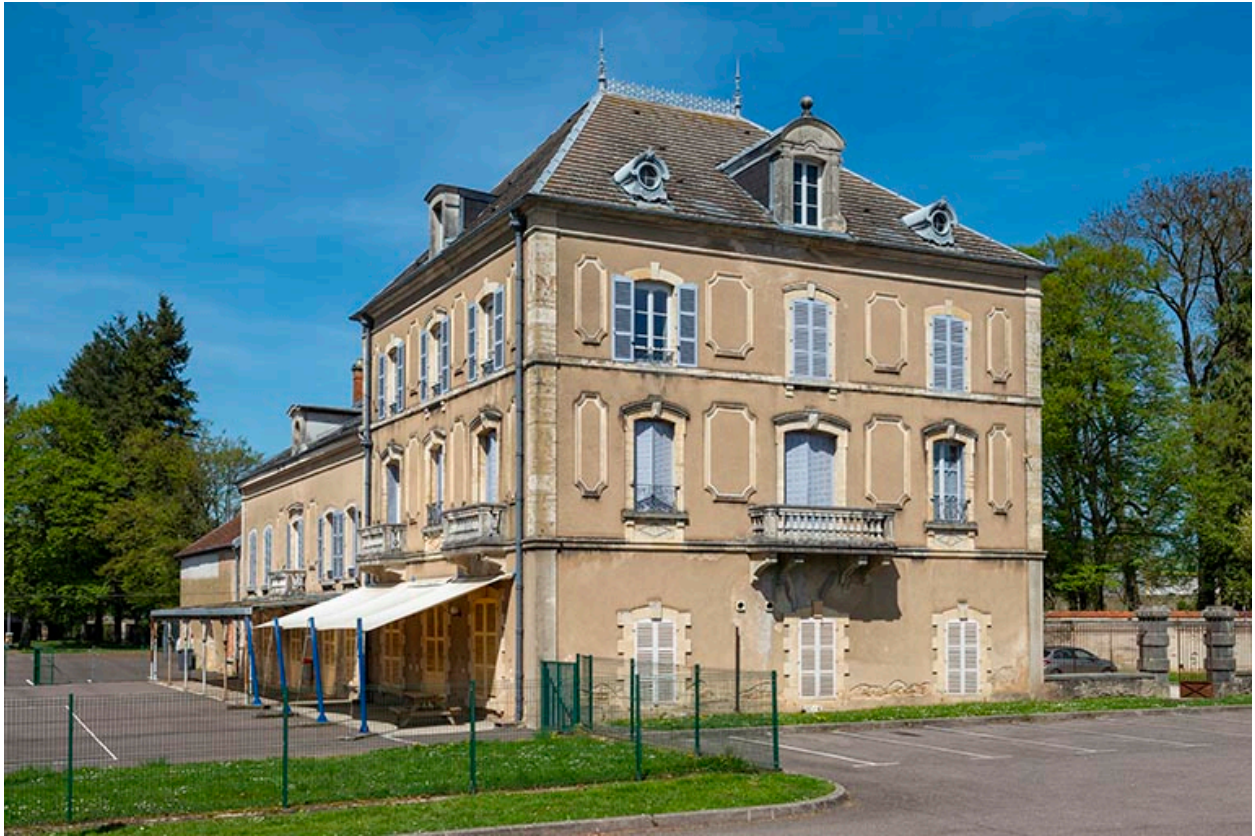
Corps de bâtiment sud, vue de trois-quarts droit.
