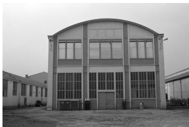
Atelier de réparation (5). Phot. Laurent Poupard IVR43_19893901127Z
