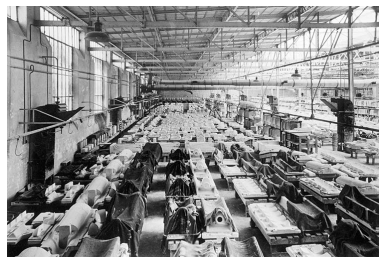
Atelier de coulage. Phot. Laurent Poupard, Autr. A. Bignon IVR43_19893900290Z
