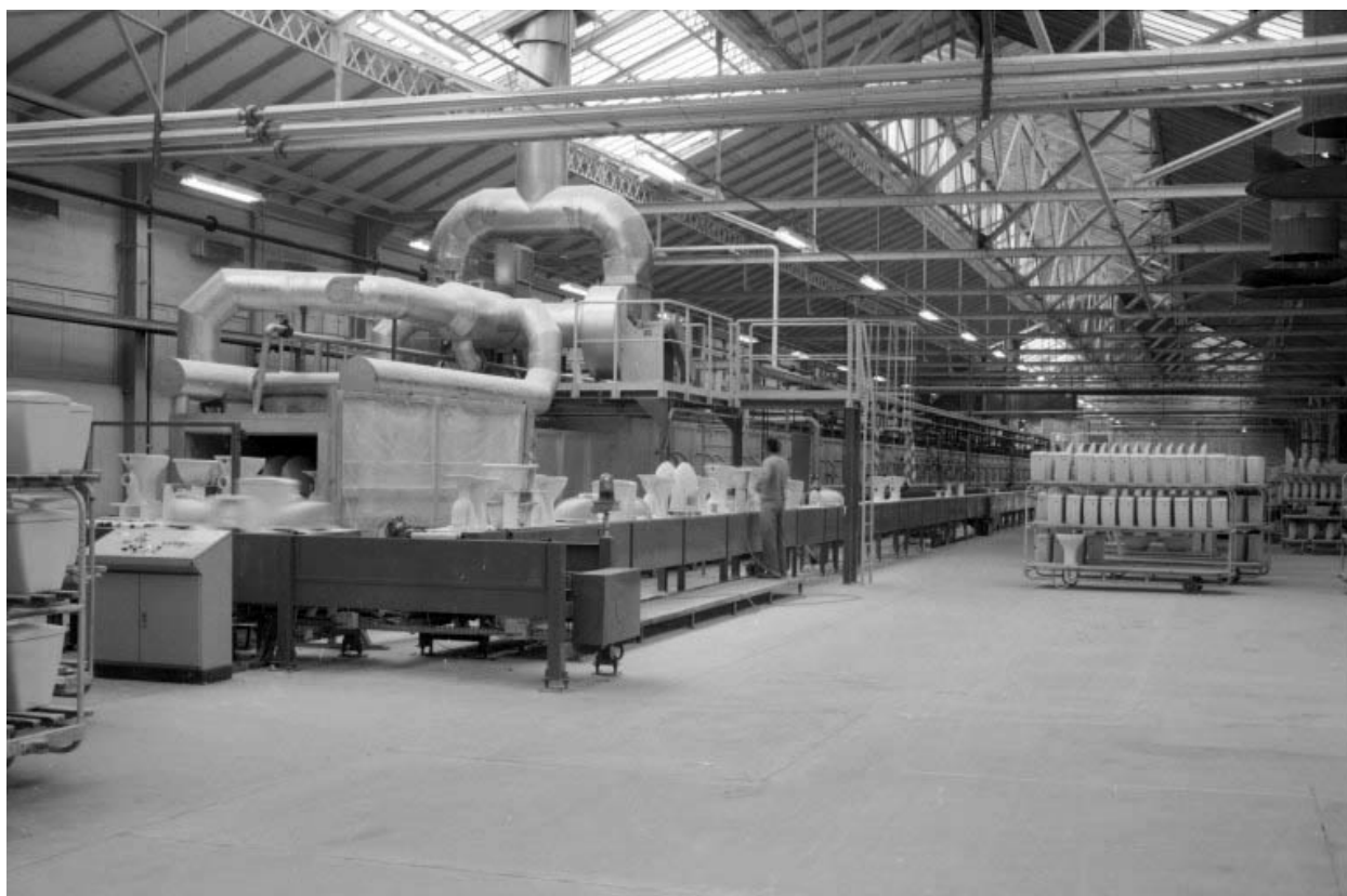
Atelier (9) : avant du four Riedhammer.
