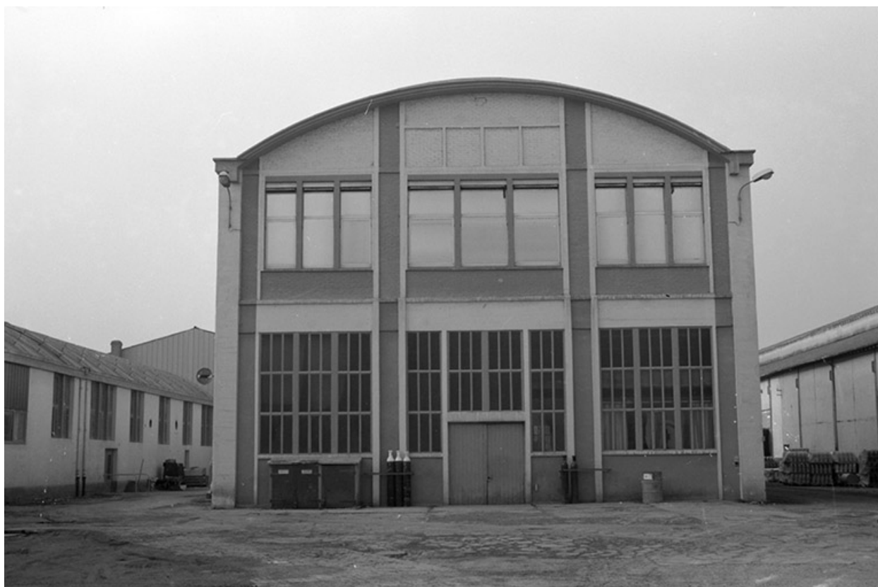
Atelier de réparation (5).
