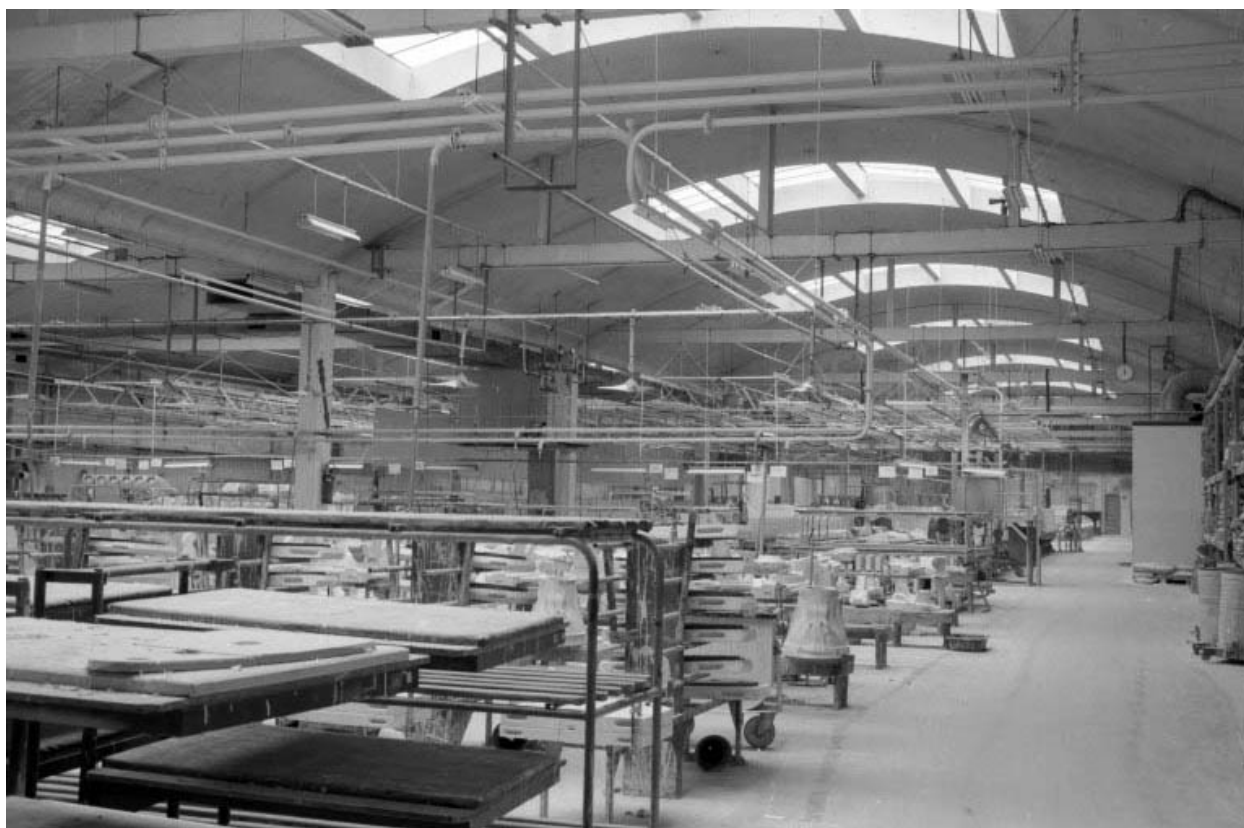
Atelier de coulage C (9), intérieur.
