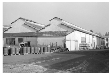
Arrière du magasin industriel (3). Phot. Laurent Poupard IVR43_19893901128Z
