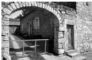
Façade antérieure entrée de la cour. Phot. Bernard Lardière IVR43_19817000645Z
