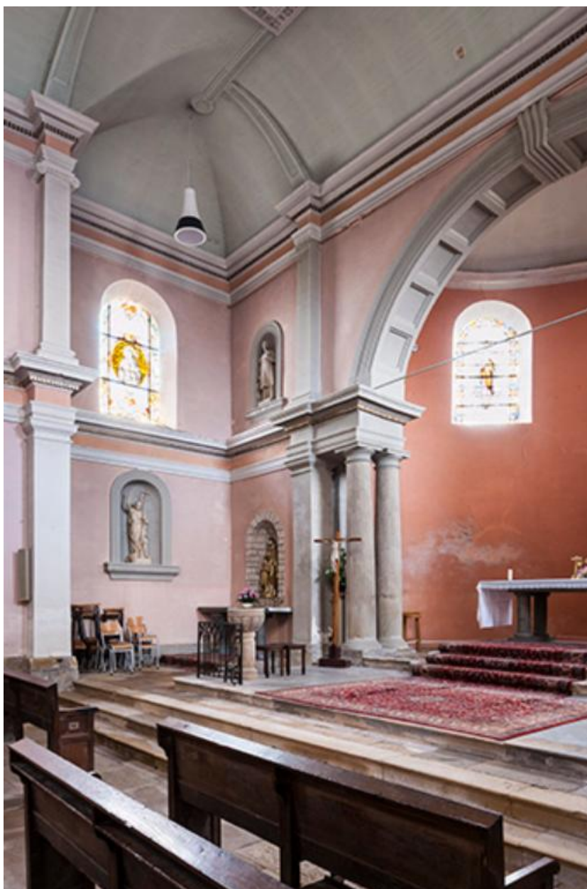
Jonction entre le mur collatéral Ouest et le choeur: retombée de voute sur deux colonnes doubles.
