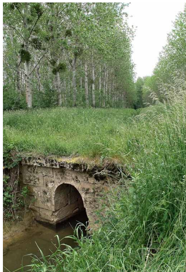
Ponceau, vue rapprochée. Phot. Jean-Luc Duthu IVR26_20107100323NUC2A
