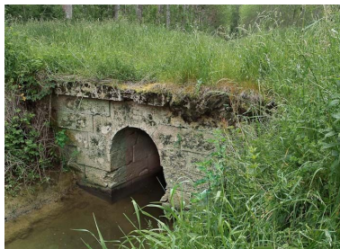
Ponceau, vue rapprochée. Phot. Jean-Luc Duthu IVR26_20107100324NUC2A
