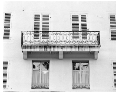
Façade postérieure : balcon. Phot. Yves Sancey IVR43_20330900872X
