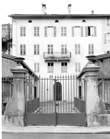
Façade postérieure. Phot. Yves Sancey IVR43_20033900866X
