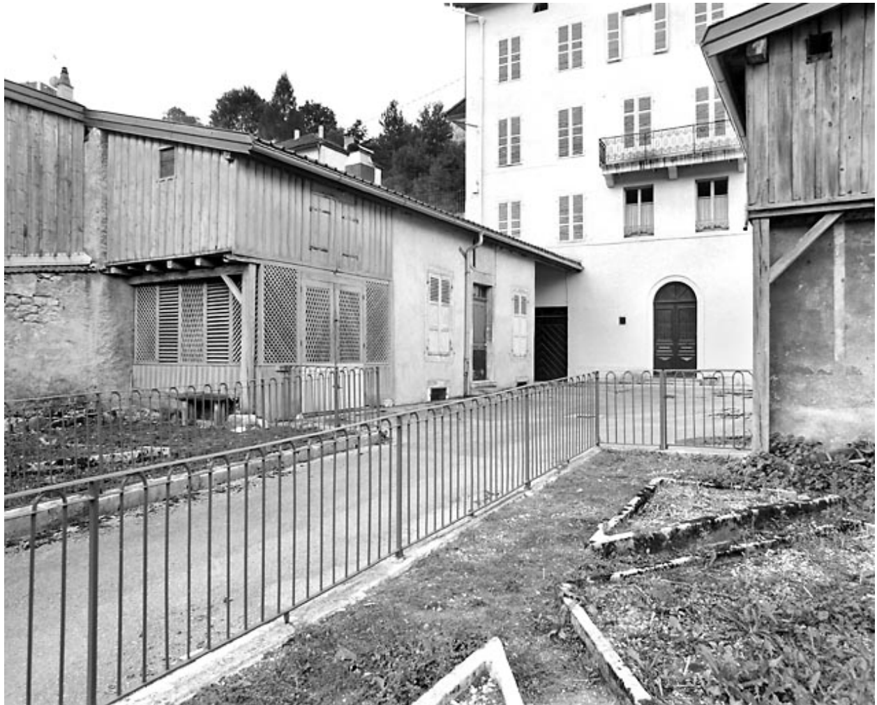
Jardin, cour et bâtiment sud.
