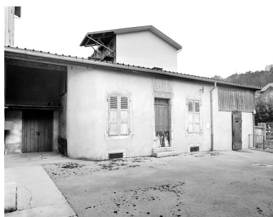
Bâtiment nord. Phot. Yves Sancey IVR43_20330900869X
