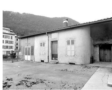
Bâtiment sud. Phot. Yves Sancey IVR43_20330900871X
