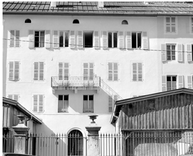
Façade postérieure. Phot. Yves Sancey IVR43_20033900867X
