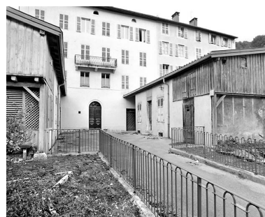
Jardin, cour et bâtiment nord. Phot. Yves Sancey IVR43_20330900868X
