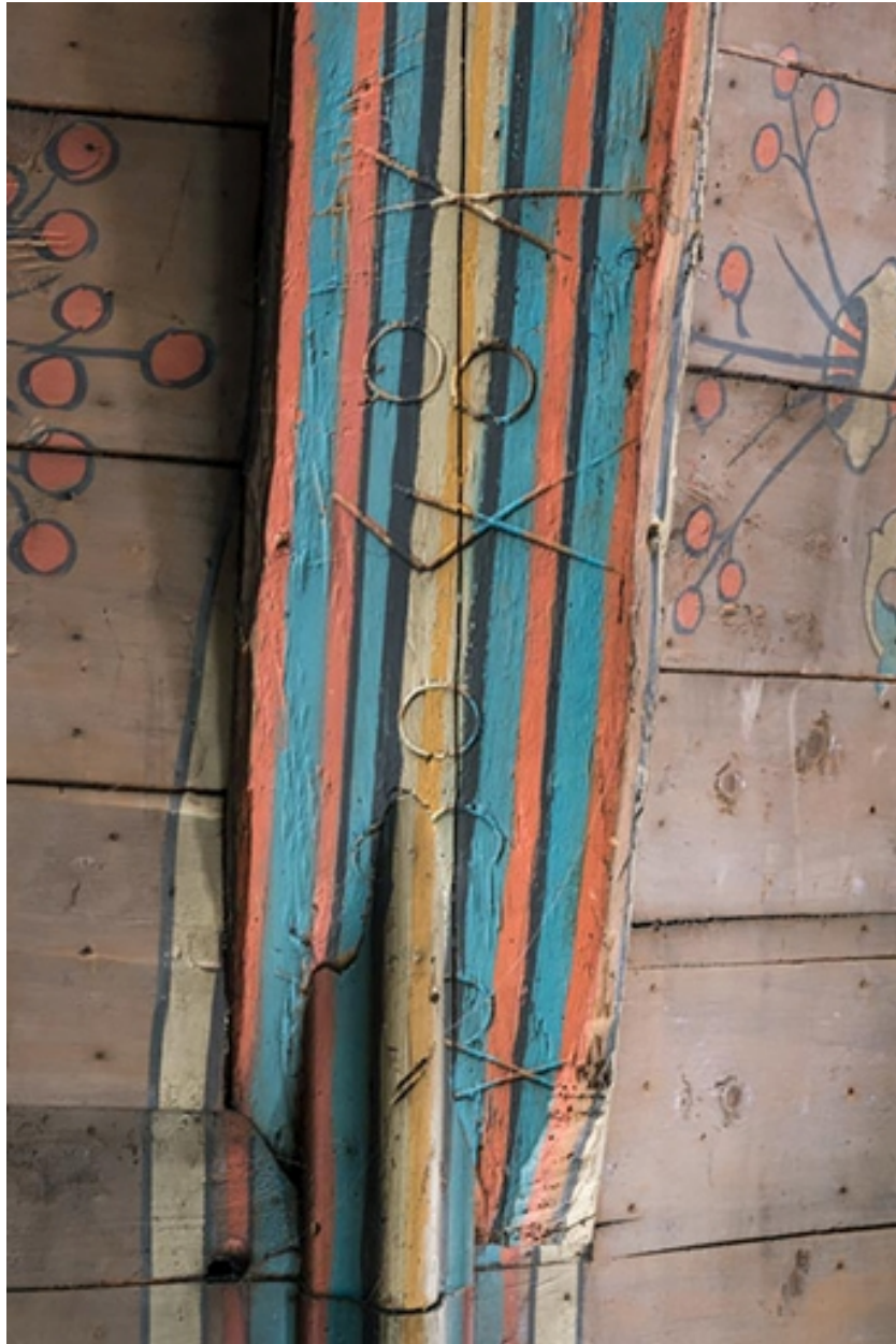
Nef, charpente lambrissée : marques de charpentier à la retombée, vers la croisée du transept.
