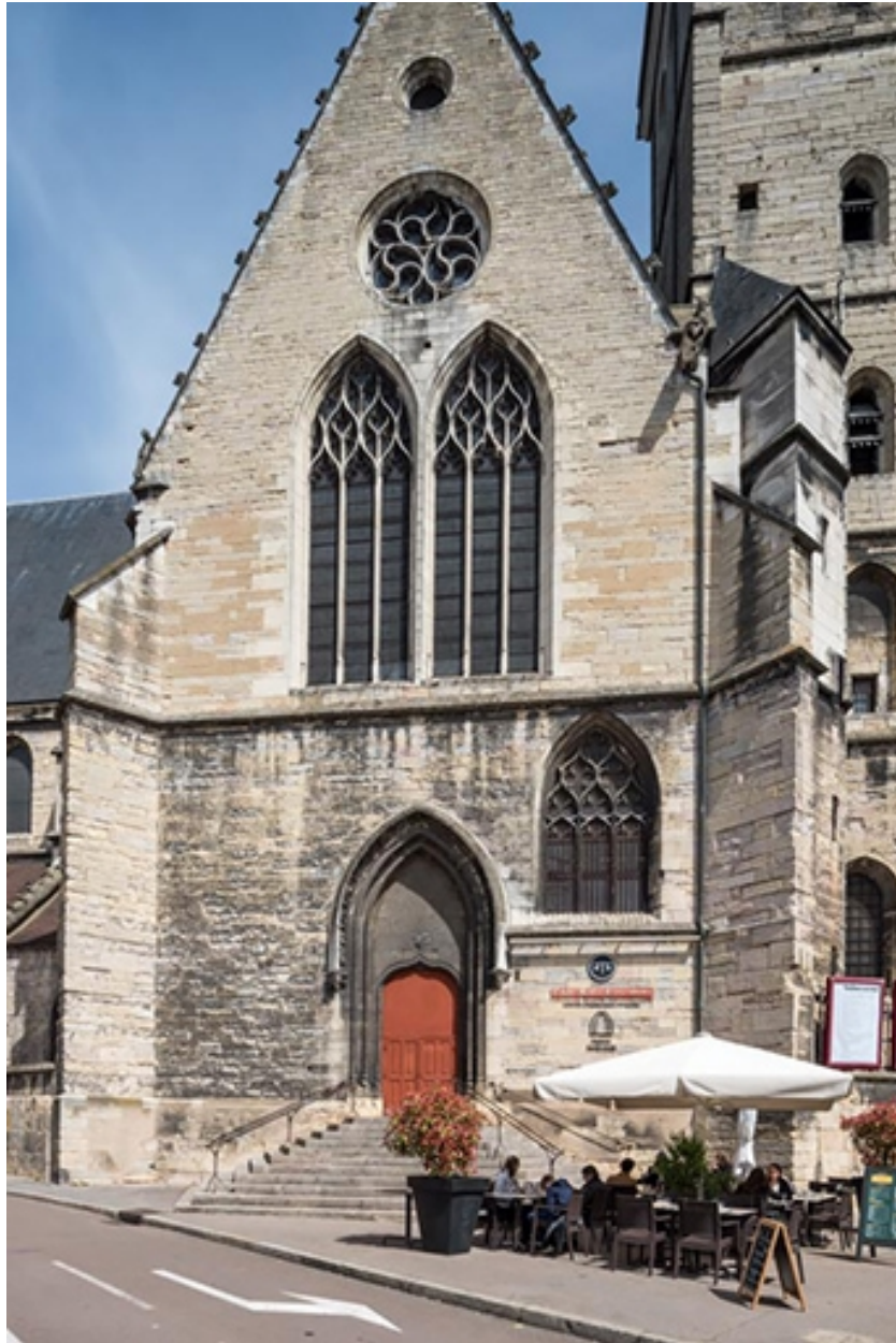
Façade sud : extrémité du transept.
