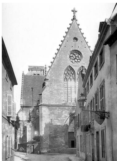
Ensemble ouest [façade antérieure, depuis la rue Danton]. 1905. Autr. Jean-Eugène Durand IVR26_20222100291NUC2
