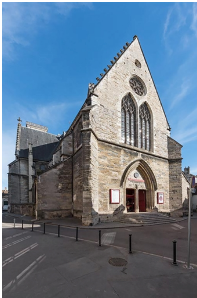
Façade occidentale, de trois quarts gauche, vue du sol.
