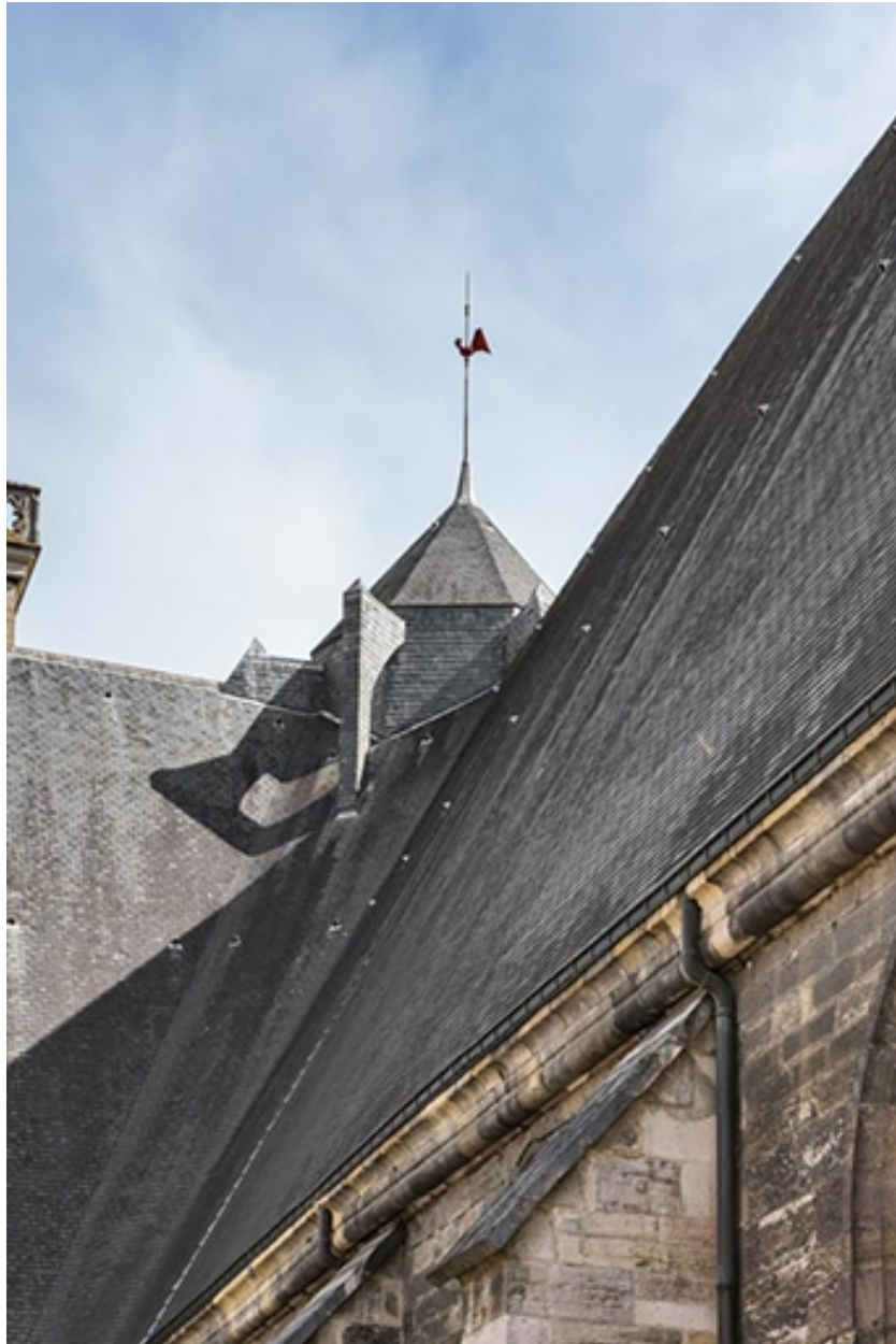
Toit polygonal marquant l'emplacement de la flèche à la croisée du transept, vu du nord-ouest.
