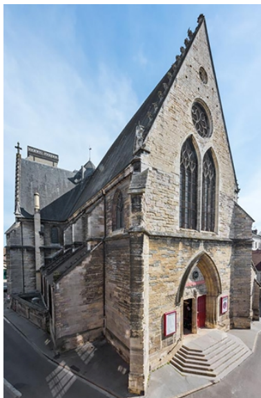
Façade occidentale, de trois quarts gauche. Phot. Pierre-Marie Barbe-Richaud IVR26_20222100495NUC4A
