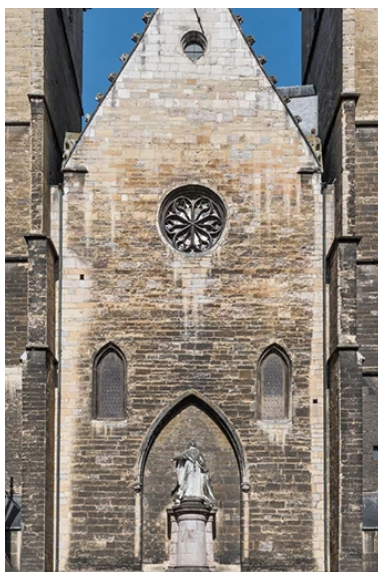
Façade orientale : mur fermant la travée droite du chœur disparu. Au centre, le monument à Bossuet. Phot. Pierre-Marie Barbe-Richaud IVR26_20222100445NUC4A
