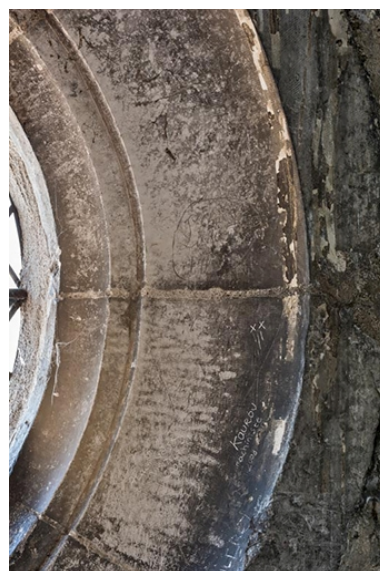
Comble : graffitis gravés sur un encadrement d'oculus. Phot. Pierre-Marie Barbe-Richaud IVR26_20222100449NUC4A
