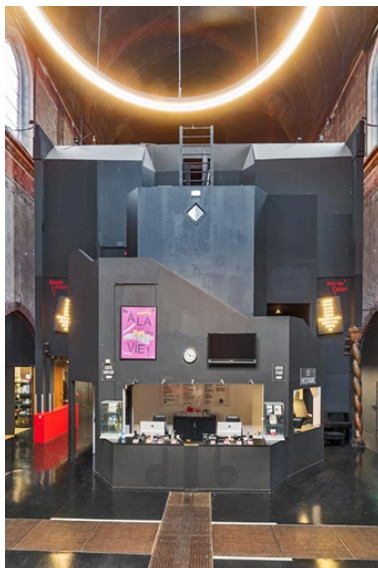
Entrée de la nef, avec la billetterie du théâtre. Le concept de "boîte dans la boîte" est clairement lisible. Phot. Pierre-Marie Barbe-Richaud IVR26_20222100472NUC4A
