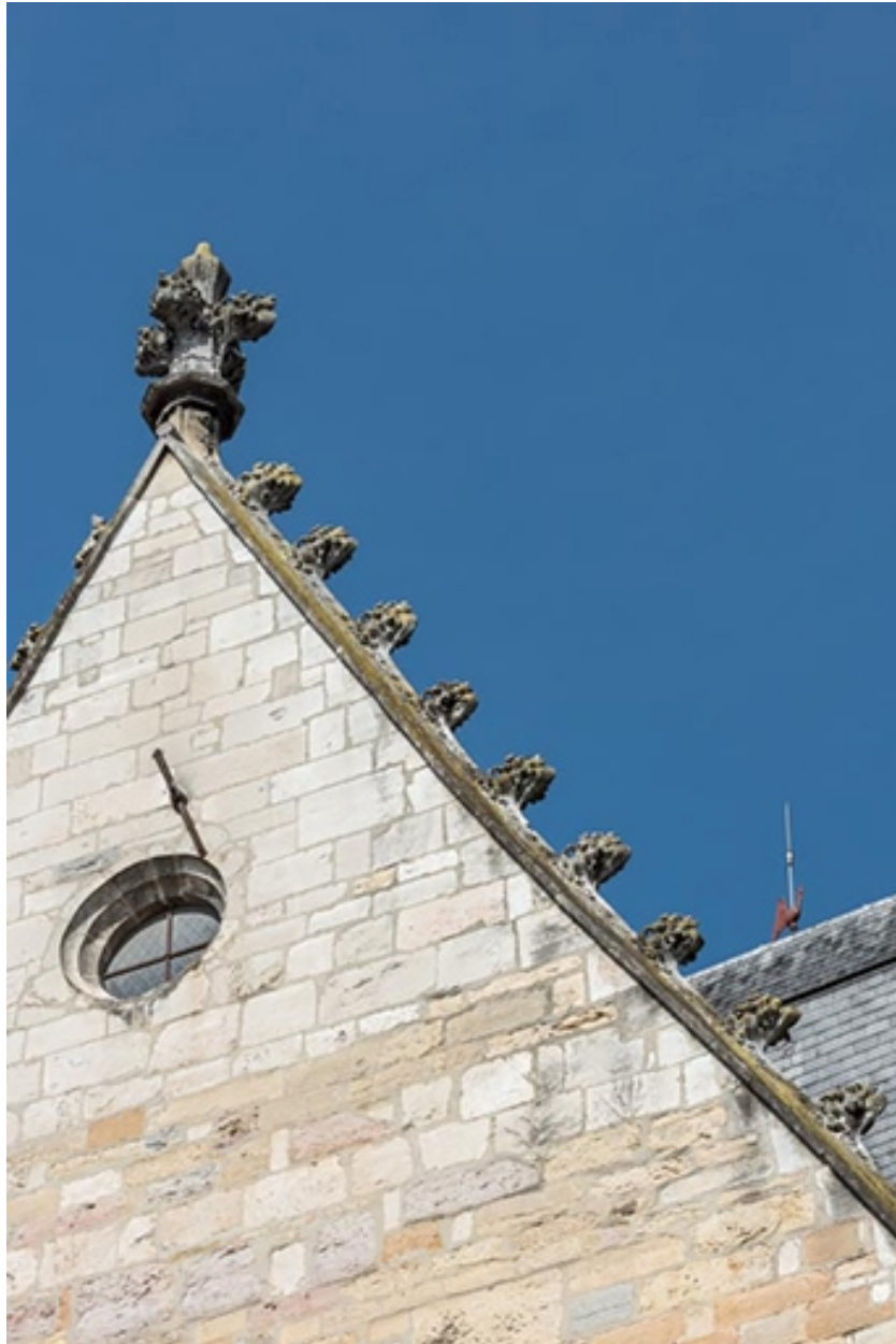
Façade orientale : pignon avec amortissement et crochets.
