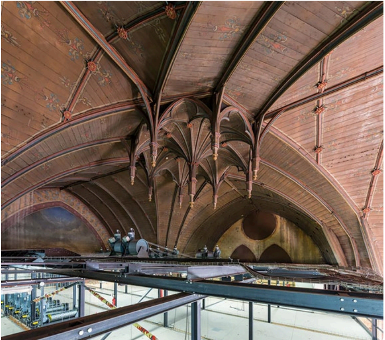
Croisée du transept : charpente lambrissée.
