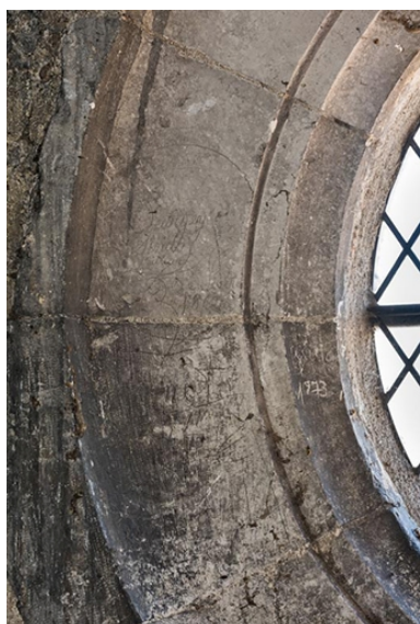
Comble : graffitis gravés sur un encadrement d'oculus. Phot. Pierre-Marie Barbe-Richaud IVR26_20222100450NUC4A
