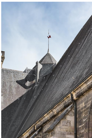
Toit polygonal marquant l'emplacement de la flèche à la croisée du transept, vu du nord-ouest. Phot. Pierre-Marie Barbe-Richaud IVR26_20222100496NUC4A
