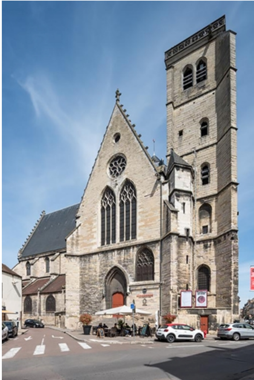
Façade sud, de trois quarts droite : extrémité du transept et tour.
