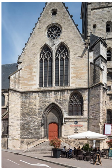
Façade sud : extrémité du transept. Phot. Pierre-Marie Barbe-Richaud IVR26_20222100413NUC4A
