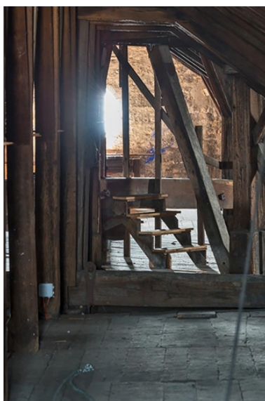
Comble : croisée du transept, avec le chevet oriental au fond. Phot. Pierre-Marie Barbe-Richaud IVR26_20222100448NUC4A
