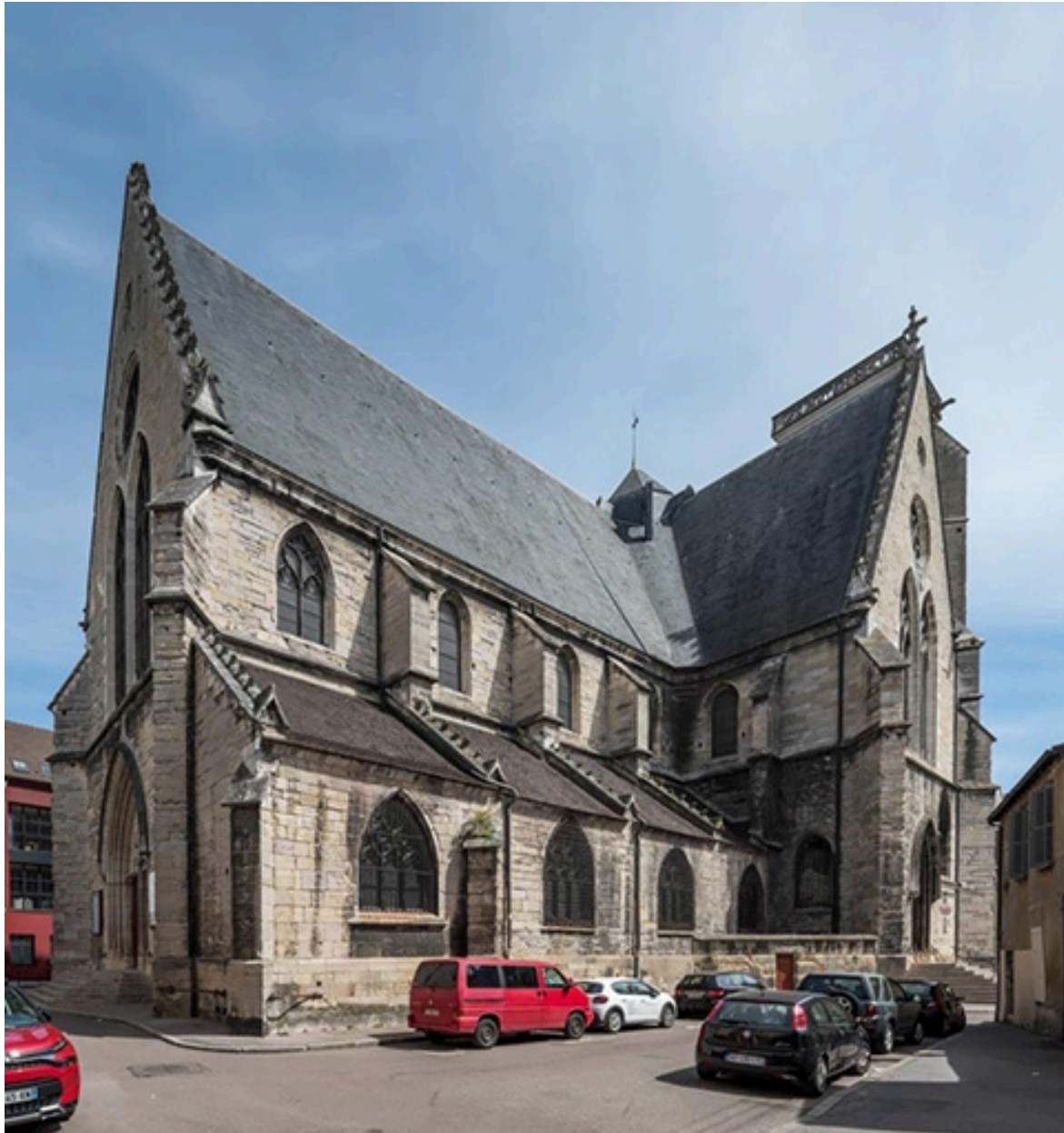
Façade sud, de trois quarts gauche.
