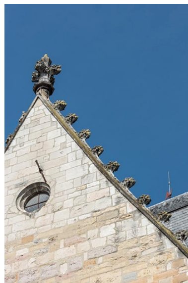
Façade orientale : pignon avec amortissement et crochets. Phot. Pierre-Marie Barbe-Richaud IVR26_20222100444NUC4A
