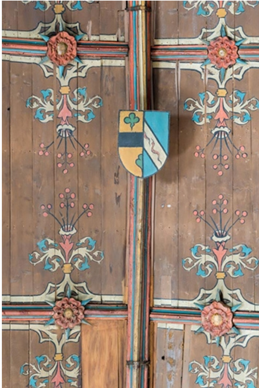
Nef, charpente lambrissée : peinture et armoiries d'Antoine 1er du Prat, baron de Vitteaux, Formeries et Thiers, et de son épouse Chrétienne de Sayve.
