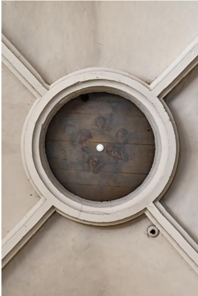
Tour sud, rez-de-chaussée (loge d'acteur côté cour) : ouverture zénithale, avec couvercle peint.
