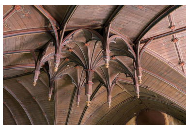
Croisée du transept, charpente lambrissée : décor de clés pendantes. Phot. Pierre-Marie Barbe-Richaud
