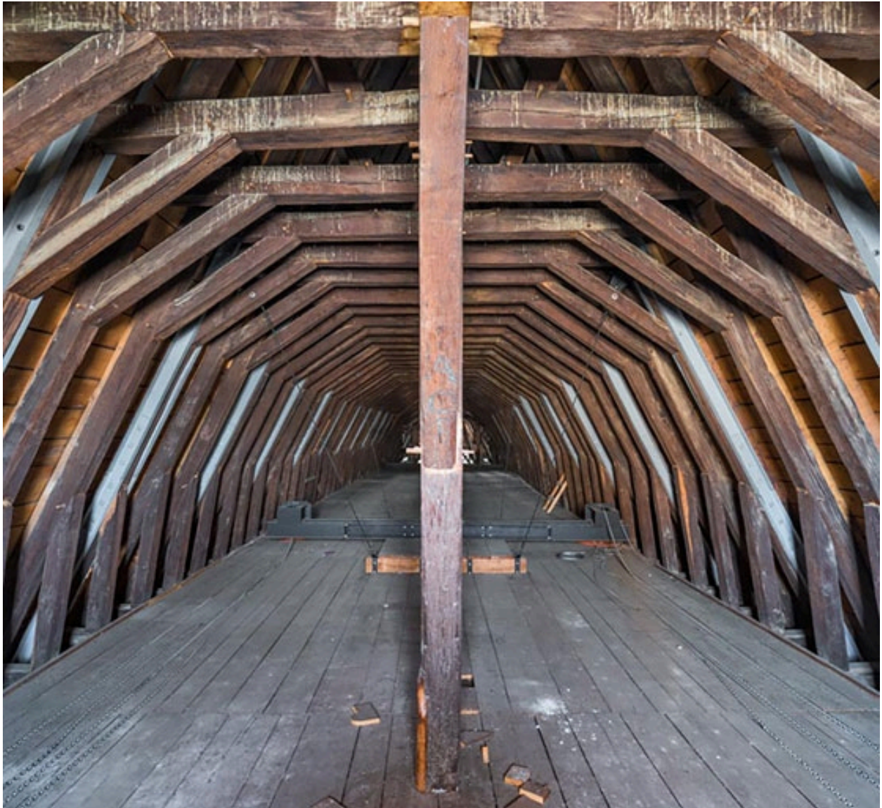
Comble : vue prise en direction du chevet oriental.
