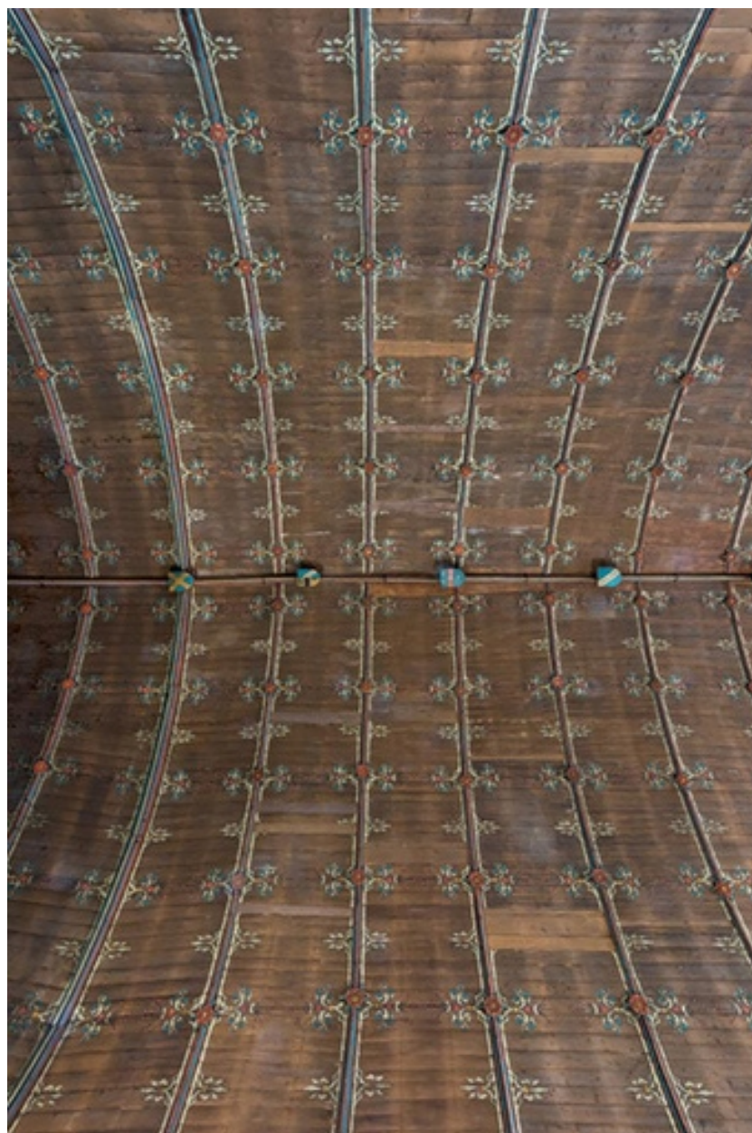
Nef, charpente lambrissée : vue d'ensemble.
