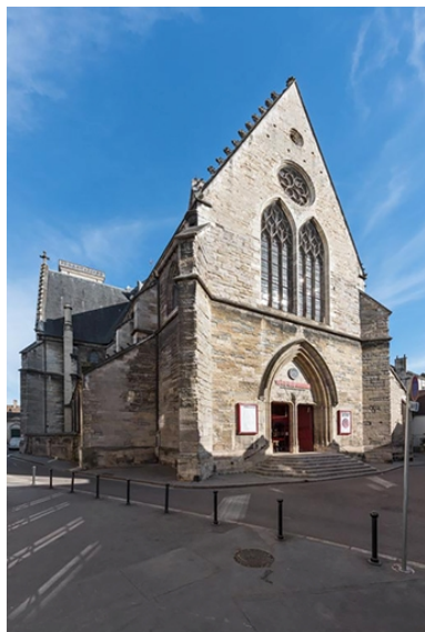
Façade occidentale, de trois quarts gauche, vue du sol. Phot. Pierre-Marie Barbe-Richaud IVR26_20222100438NUC4A
