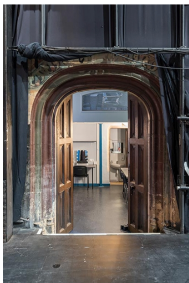
Tour nord, rez-de-chaussée : accès à la loge d'acteur côté jardin. Phot. Pierre-Marie Barbe-Richaud IVR26_20222100407NUC4A
