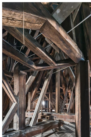
Comble : croisée du transept depuis le bras nord. Phot. Pierre-Marie Barbe-Richaud IVR26_20222100454NUC4A
