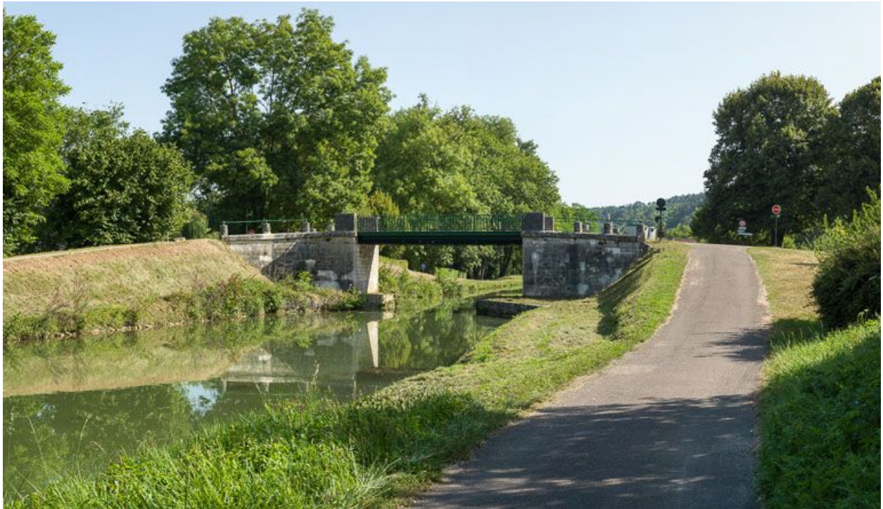
Vue d'aval du pont.
