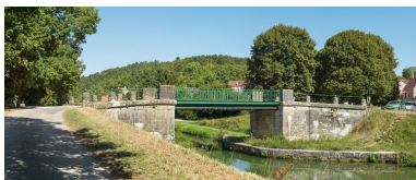
Vue d'amont du pont. Phot. Pierre-Marie Barbe-Richaud IVR26_20138900141NUC4AQ
