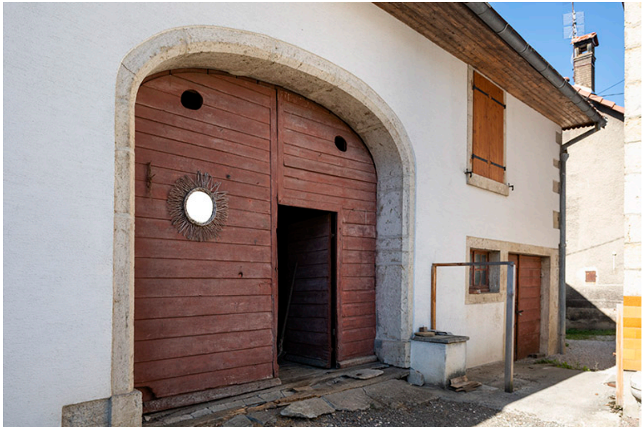
Grange : façade antérieure, de trois quarts gauche.
