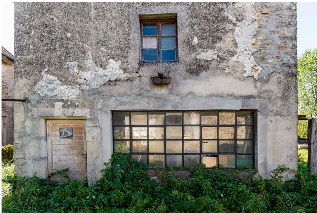
Forge, façade antérieure : porte et fenêtres.
