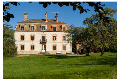
La demeure, vue depuis le parc. Phot. Sonia Dourlot IVR43_20157000682NUC2A
