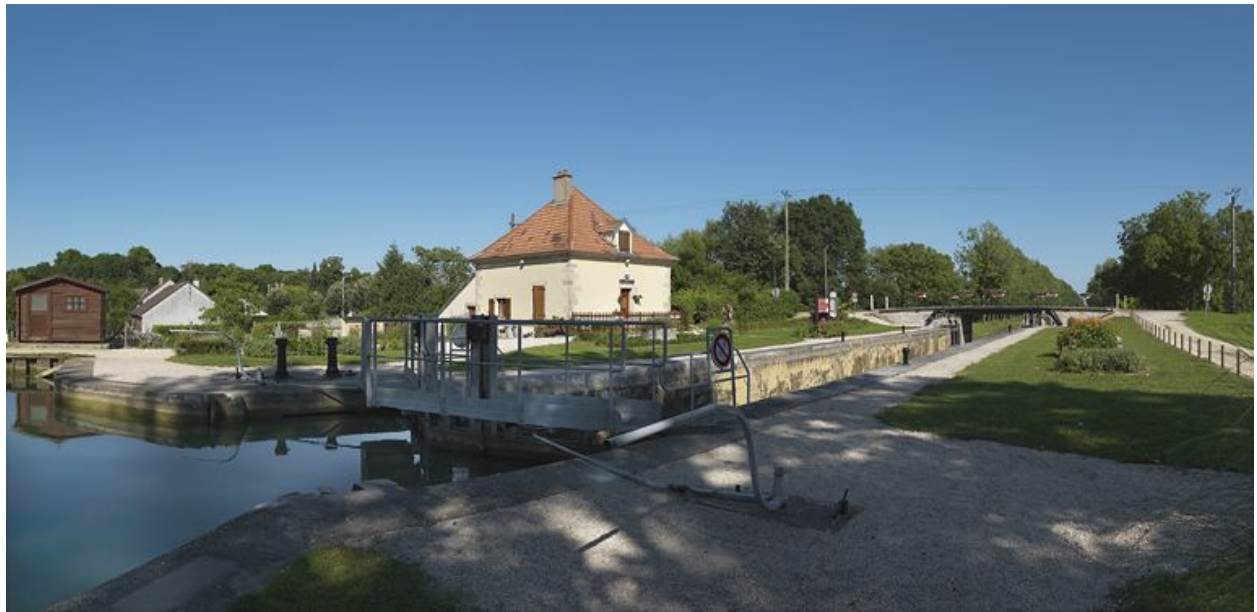
Vue d'ensemble prise d'amont.
