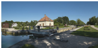
Vue d'ensemble prise d'amont. Phot. Thierry Kuntz IVR26_20112103094NUC4A
