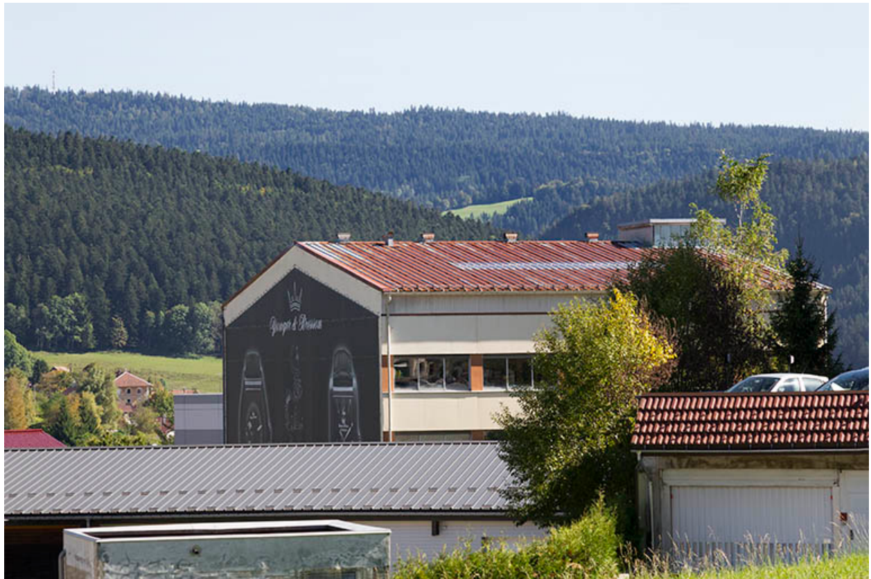
Corps nord : façades postérieure et latérale droite.
