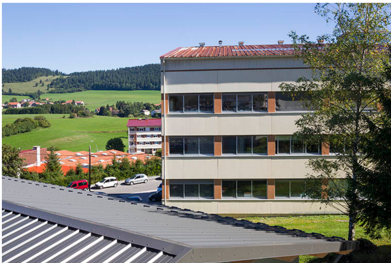
Corps nord : façade postérieure.
