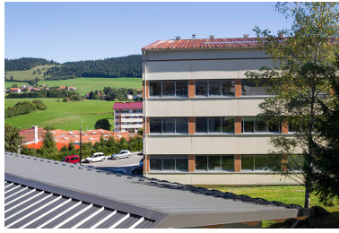
Corps nord : façade postérieure. Phot. Yves Sancey IVR43_20132502170NUC2A
