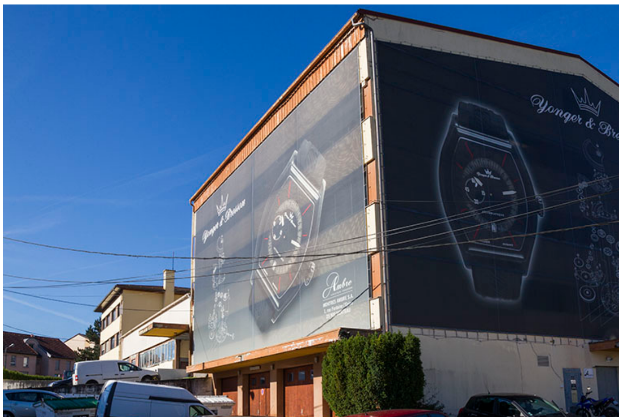
Corps nord : façades antérieure et latérale droite.
