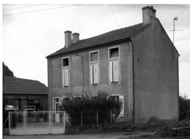
Vue d'ensemble d'une maison (cada. 1969, sect. D, parc. 344). Phot. Michel Rosso
