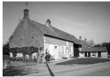
Vue d'ensemble d'une ferme (cada. 1969, sect. D, parc. 519). Phot. Michel Rosso IVR26_19852101337V
