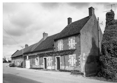
Vue d'ensemble d'une maison (cada. 1969, sect. D, parc. 273). Phot. Michel Rosso
