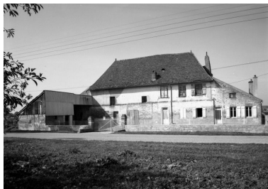
Vue d'ensemble d'une ferme (cada. 1969, sect. D, parc. 81). Phot. Michel Rosso IVR26_19852101339V
