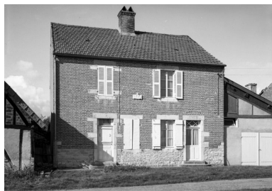
Vue d'ensemble d'une ferme (cada. 1969, sect. F, parc. 193). Phot. Michel Rosso IVR26_19852101362V
