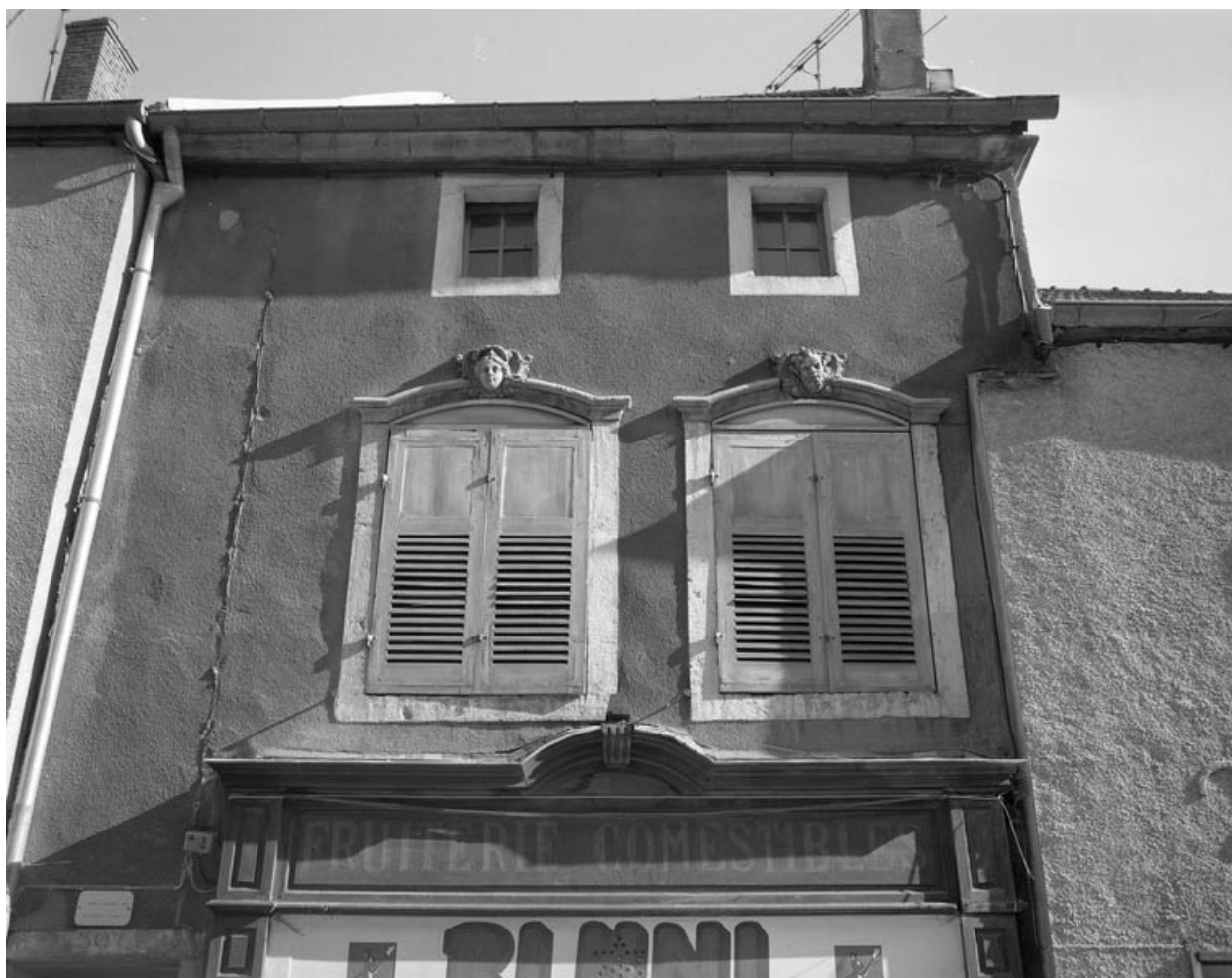
Façade antérieure : détail de la partie supérieure.
