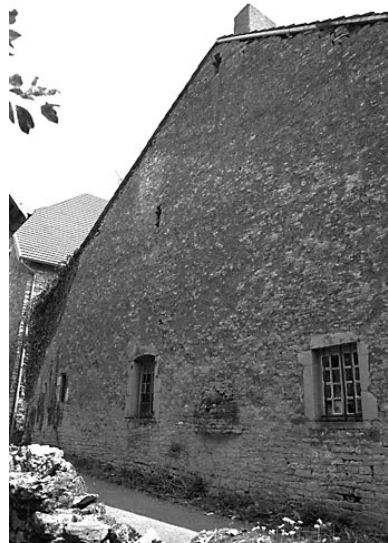
Façade latérale gauche. Phot. Dominique Humbert IVR43_19767000478X
