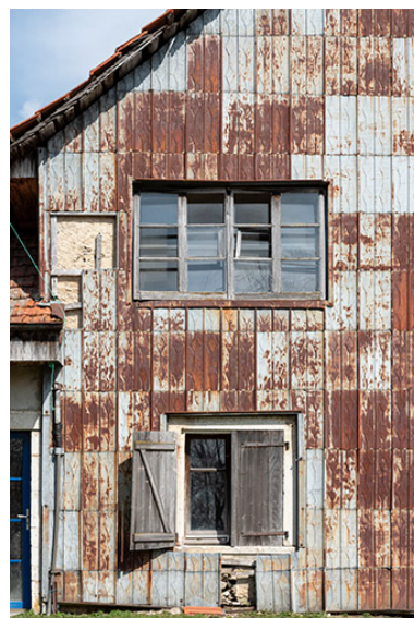
Façade ouest : essentage de tôle et fenêtre d'atelier. Phot. Sonia Dourlot IVR43_20192500327NUC4A
