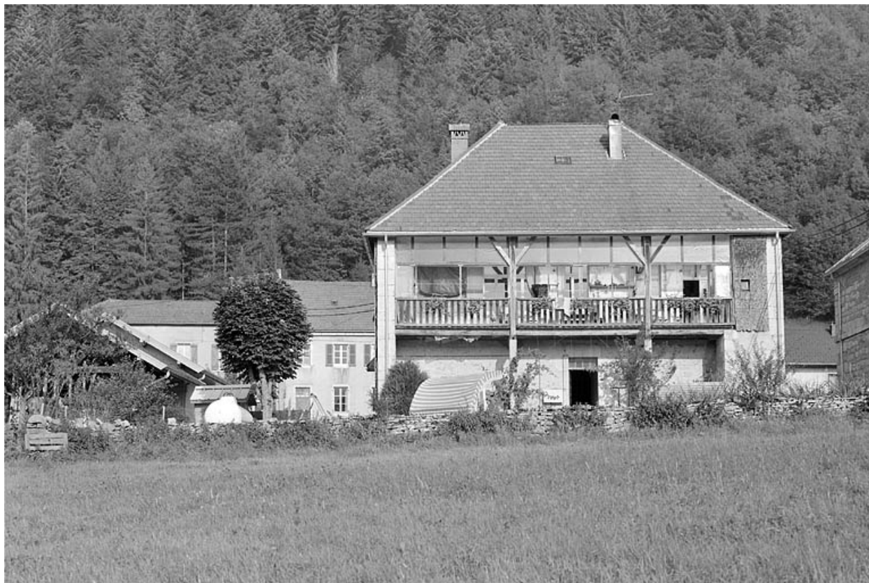
Vue générale de la façade postérieure.
