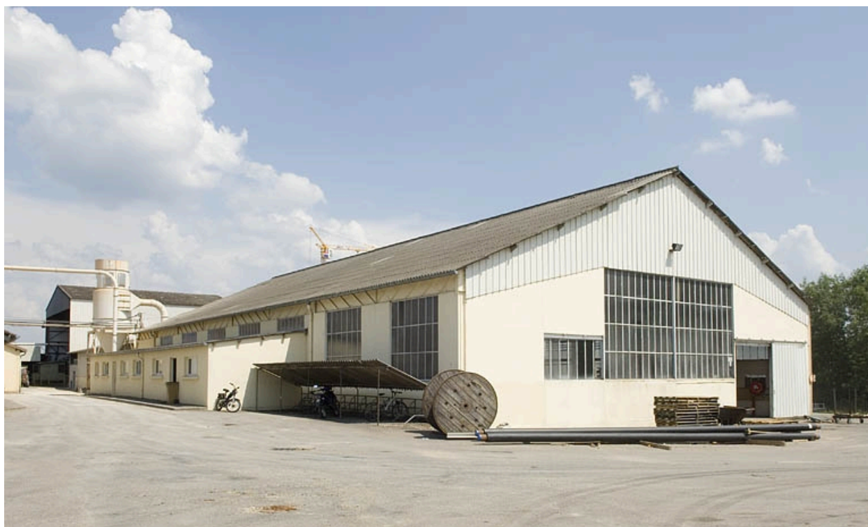
Atelier de fabrication (moulures).
