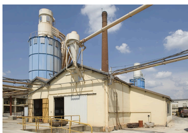
Salle des machines et chaufferie. Phot. Jérôme Mongreville
