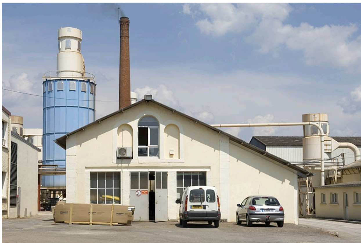
Pignon de l'atelier de réparation.
