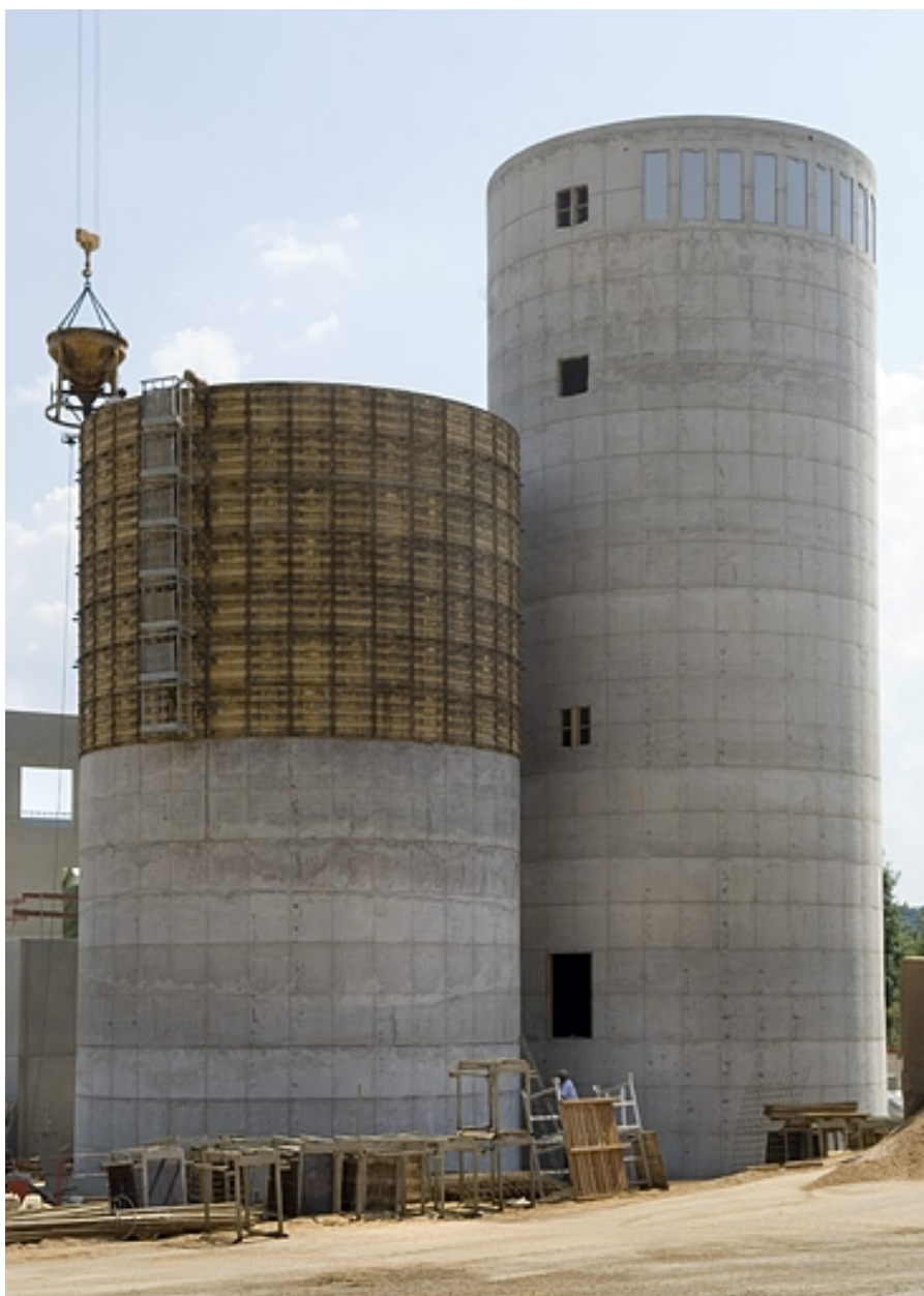
Chaufferie et silos à sciure en construction.
