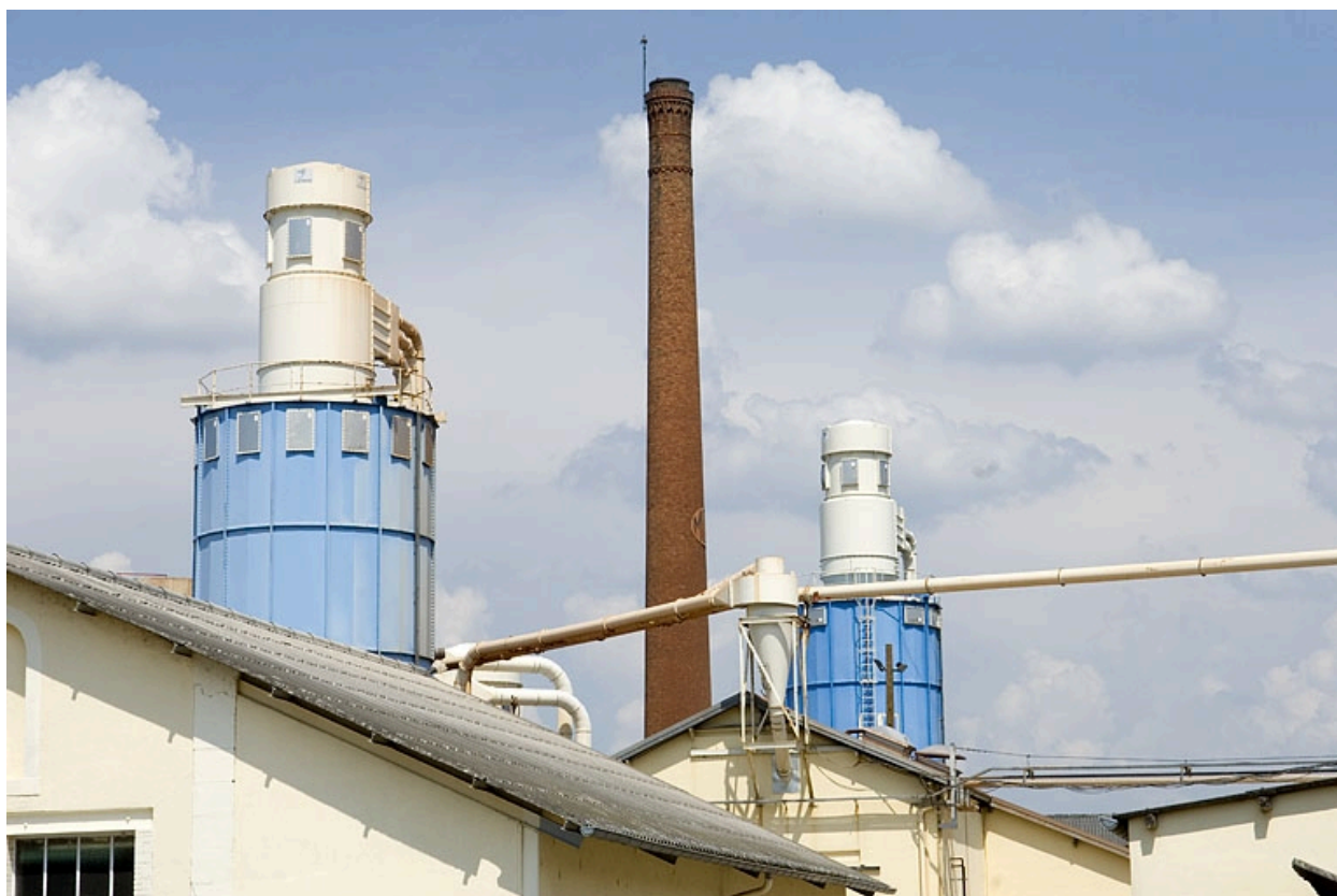
Silos et cheminée depuis le sud-ouest.
