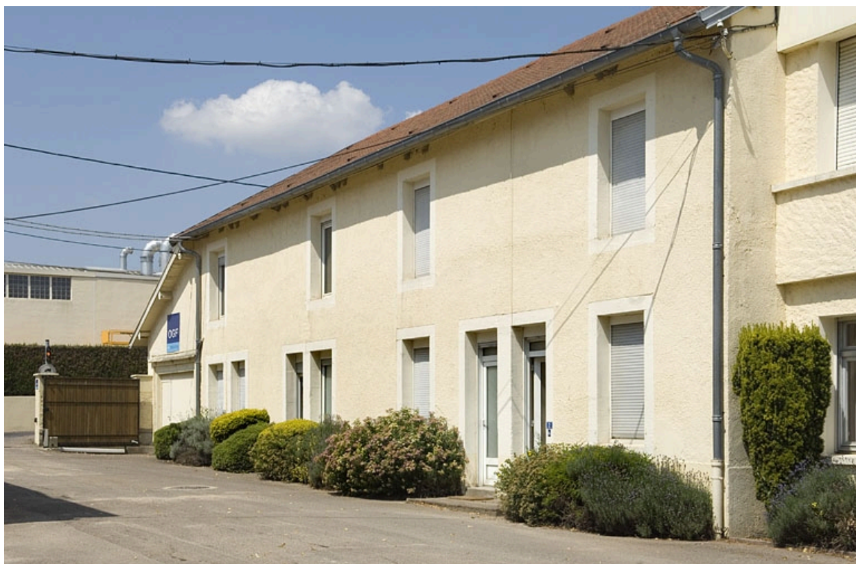
Façade ouest des logements.
