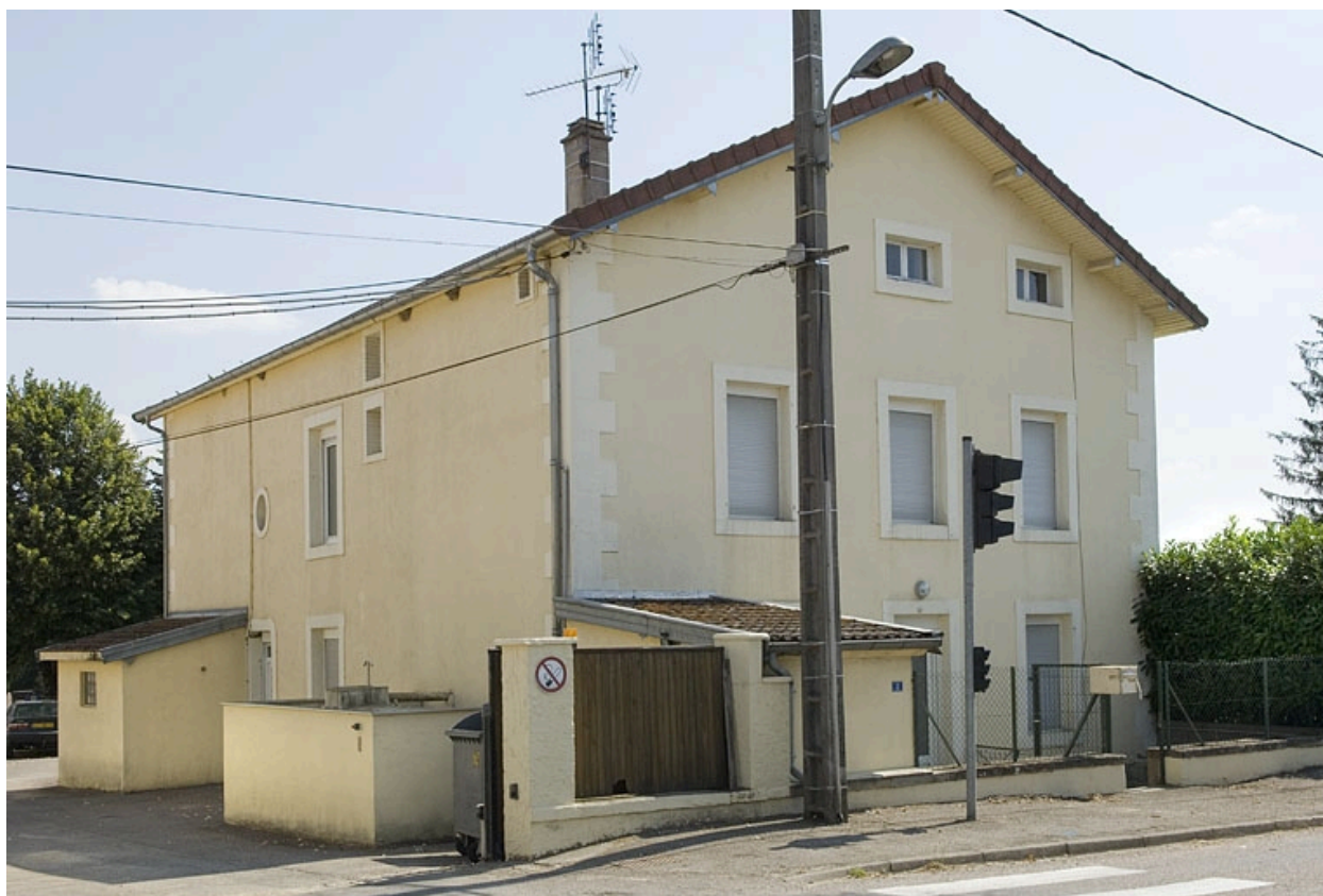
Logement (ancien bureau).
