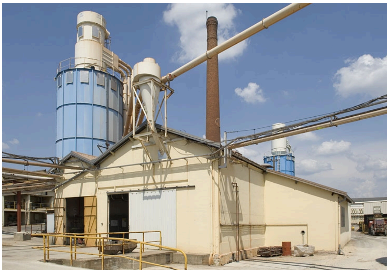
Salle des machines et chaufferie.
