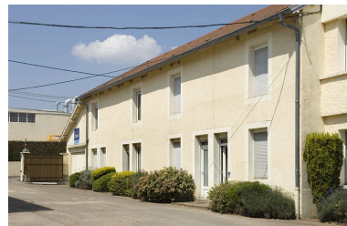
Façade ouest des logements. Phot. Jérôme Mongreville
