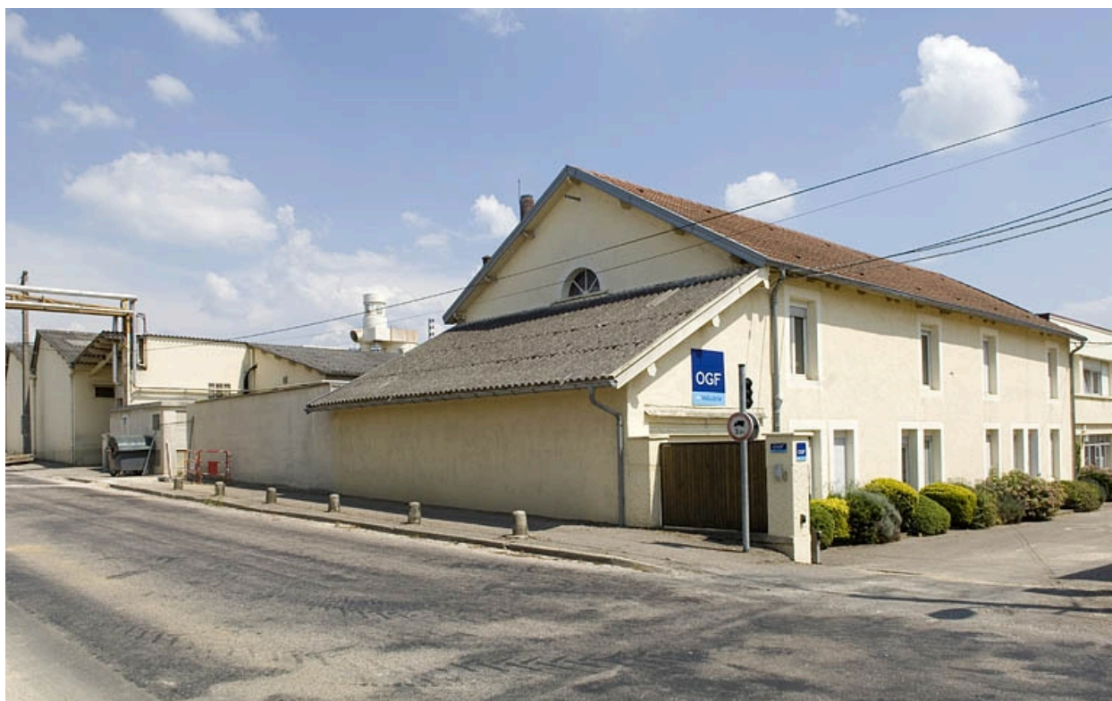
Logements depuis la rue.
