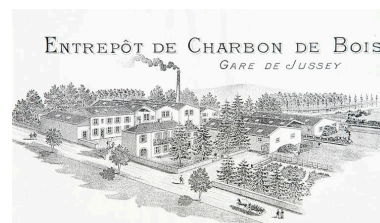
Entrepôt de charbon de bois [vue cavalière]. Phot. Jérôme Mongreville IVR43_20097000747NUC2A
