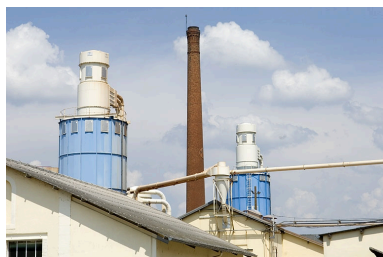
Silos et cheminée depuis le sud-ouest. Phot. Jérôme Mongreville
