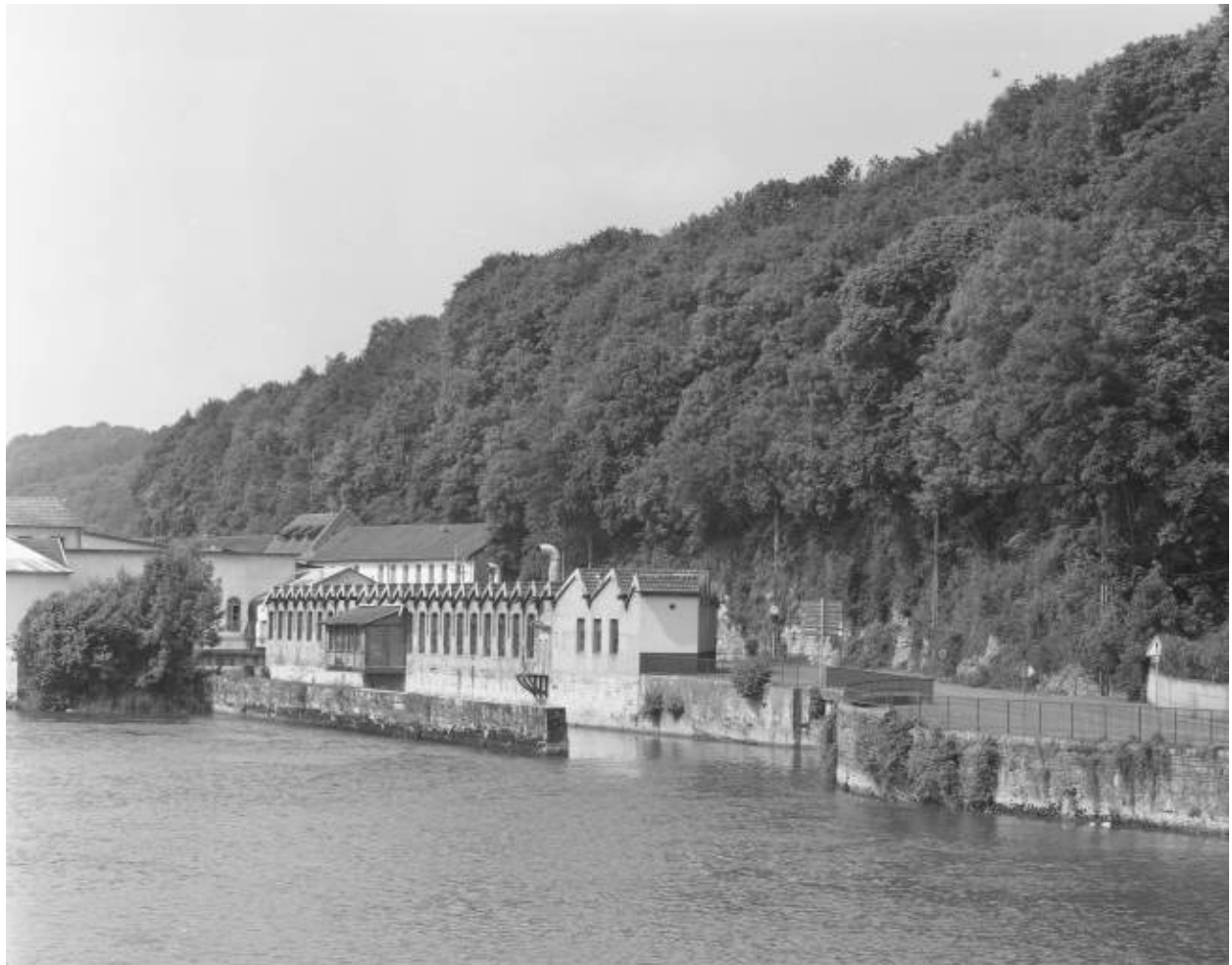
Vue d'ensemble depuis le pont. Vue rapprochée.
