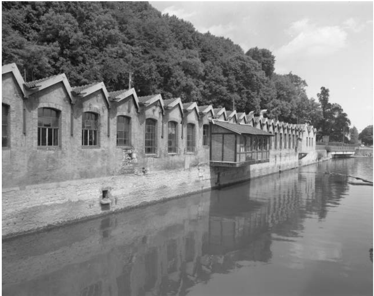
Atelier des fins de séries. Façade est.
