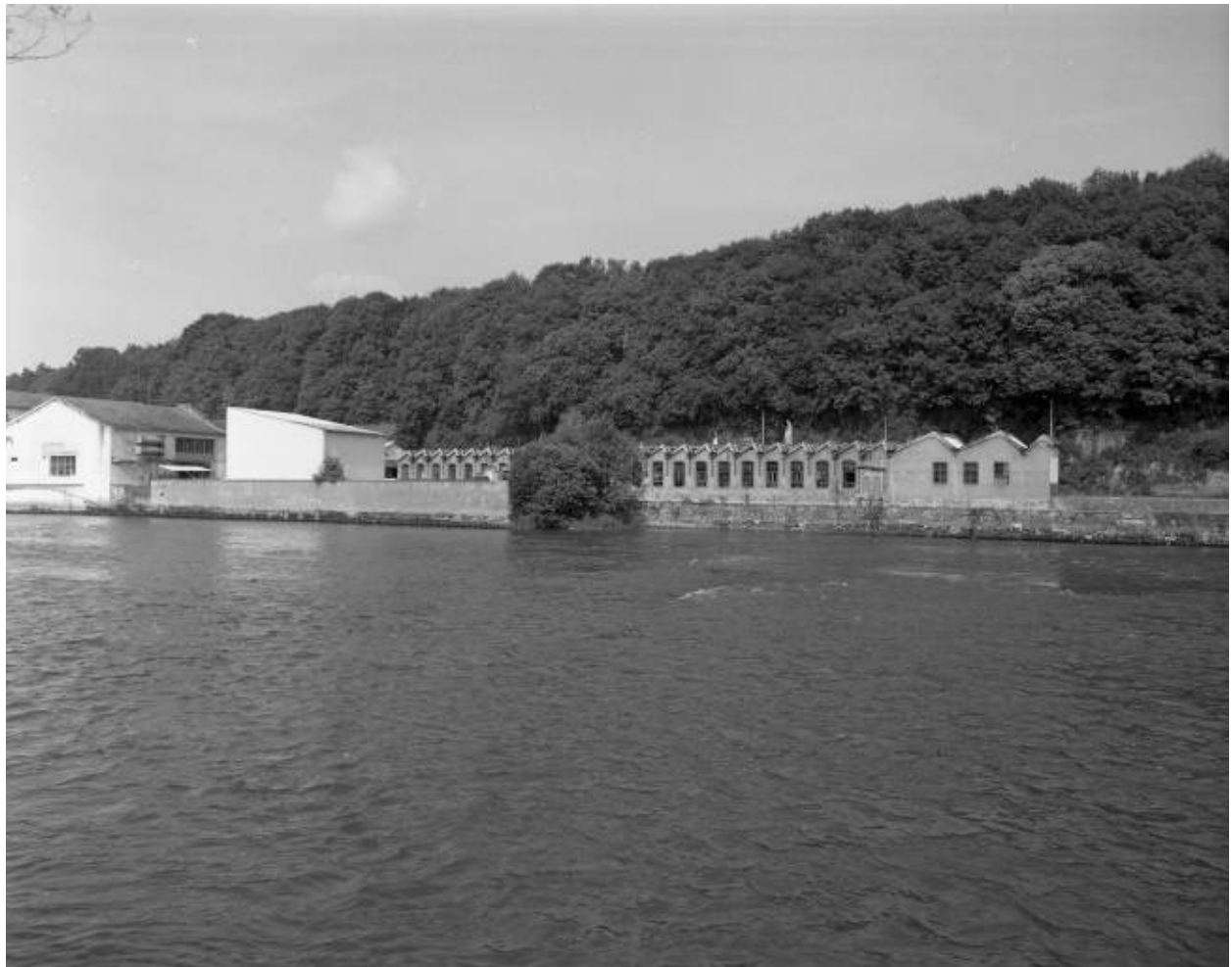
Vue générale depuis la rive droite.
