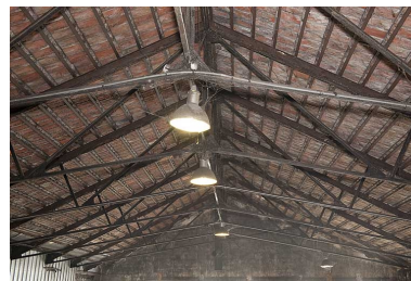
Charpente métallique d'un magasin industriel. Phot. Jérôme Mongreville IVR43_20112501600NUC4A
