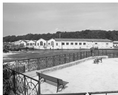
Bâtiments sud depuis la rive droite. Phot. Jérôme Mongreville IVR43_20022500402X
