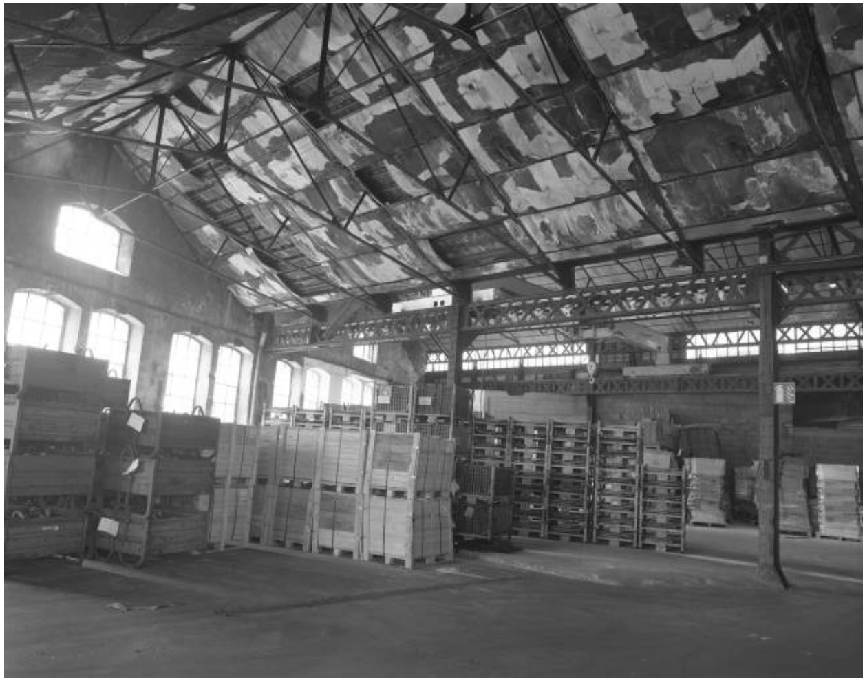
Ancienne fonderie. Vue intérieure générale.
