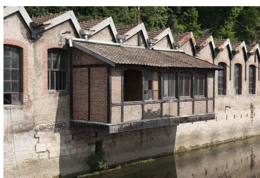
Atelier de fabrication nord. Construction en surplomb sur le canal de fuite.
