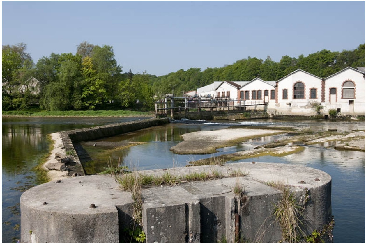
Le barrage depuis la rive droite.
