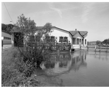
Ancienne fonderie vue du sud.
