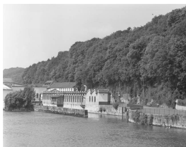
Vue d'ensemble depuis le pont. Vue rapprochée.
