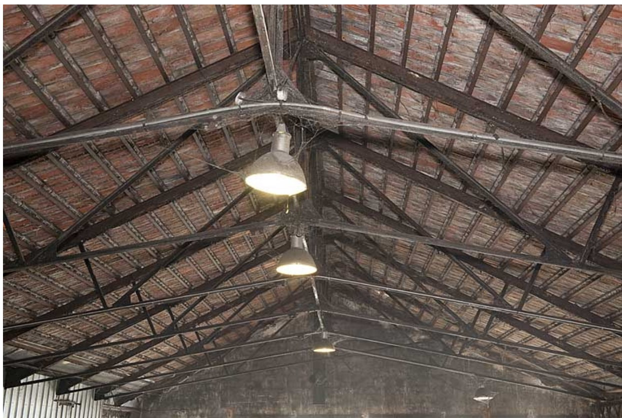
Charpente métallique d'un magasin industriel.
