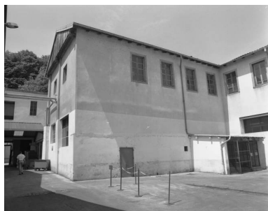
Atelier de fabrication (outillage- entretien mécanique). Vue de trois quarts gauche. Phot. Jérôme Mongreville IVR43_20022500376X
