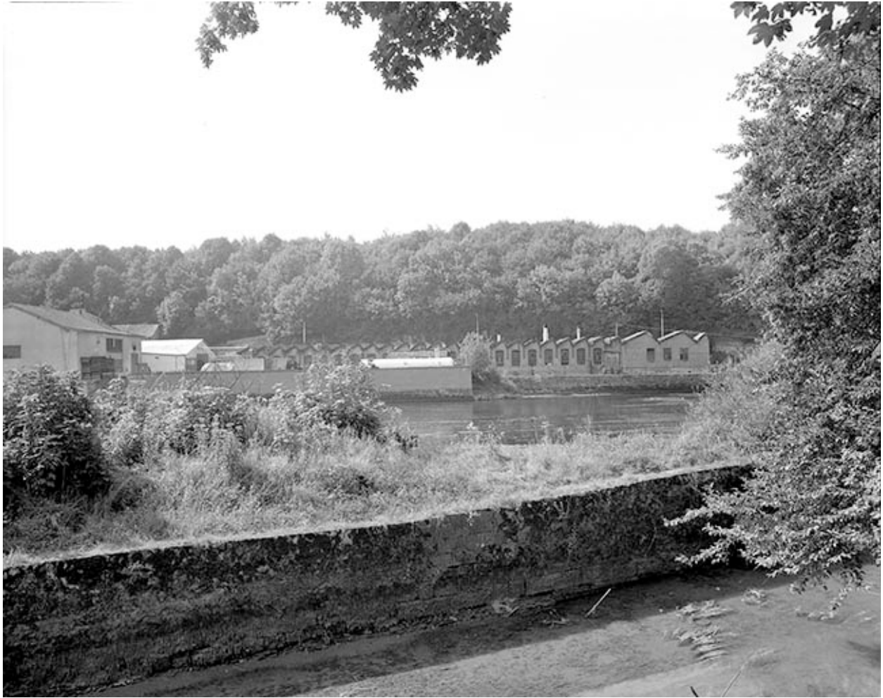
Les bâtiments industriels vus depuis l'ancienne filature Japy d'Audincourt (rive droite du Doubs).
