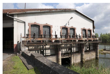
Vannage de prise d'eau devant le pignon d'un magasin industriel. Phot. Jérôme Mongreville IVR43_20112501601NUC4A
