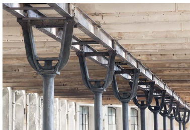
Atelier de fabrication nord. Détail des parties supérieures des colonnes en lyre. Phot. Jérôme Mongreville IVR43_20112501595NUC4A
