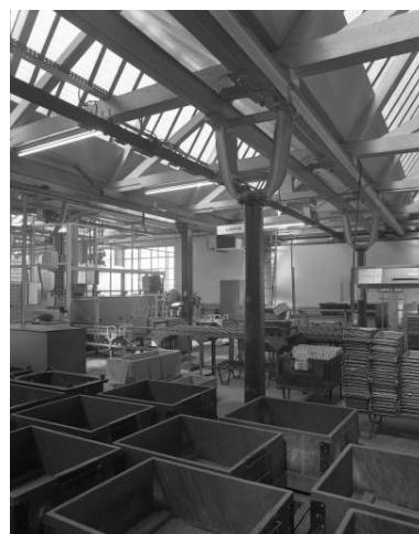
Atelier des culbuteurs. Charpente en bois. Phot. Jérôme Mongreville IVR43_20022500391X
