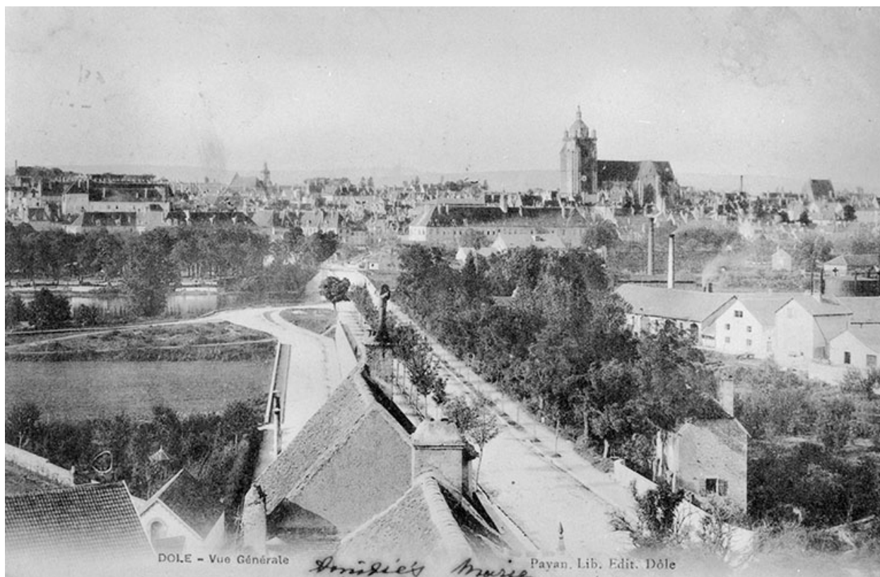
Dole - Vue Générale.
