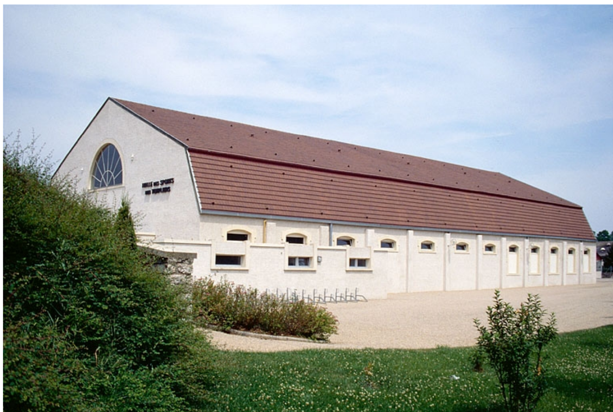
Façade latérale gauche du gymnase.
