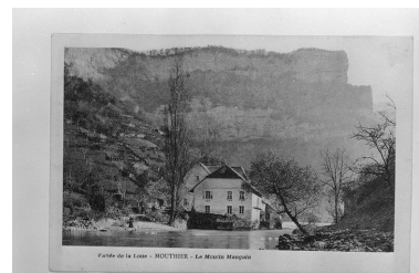
Vallée de la Loue - Mouthier - Le Moulin Maugain, s.d. [1er quart 20e siècle]. Phot. Dominique Dominguez IVR43_19812500302V
