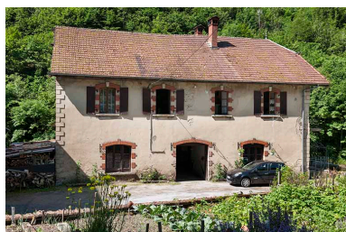
Atelier ouest (magasin et atelier de finissage) Phot. Jérôme Mongreville IVR43_20152501518NUC4A
