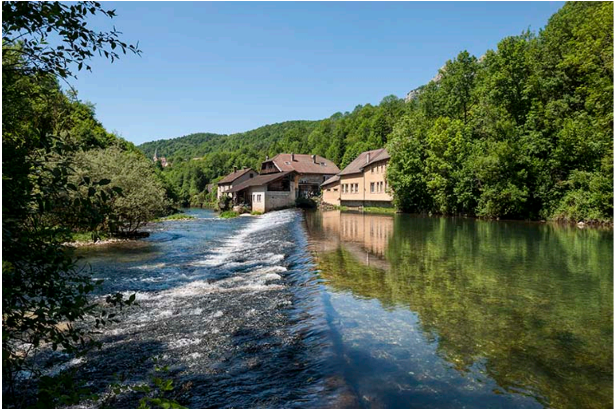
Vue d'ensemble depuis le barrage, en amont.
