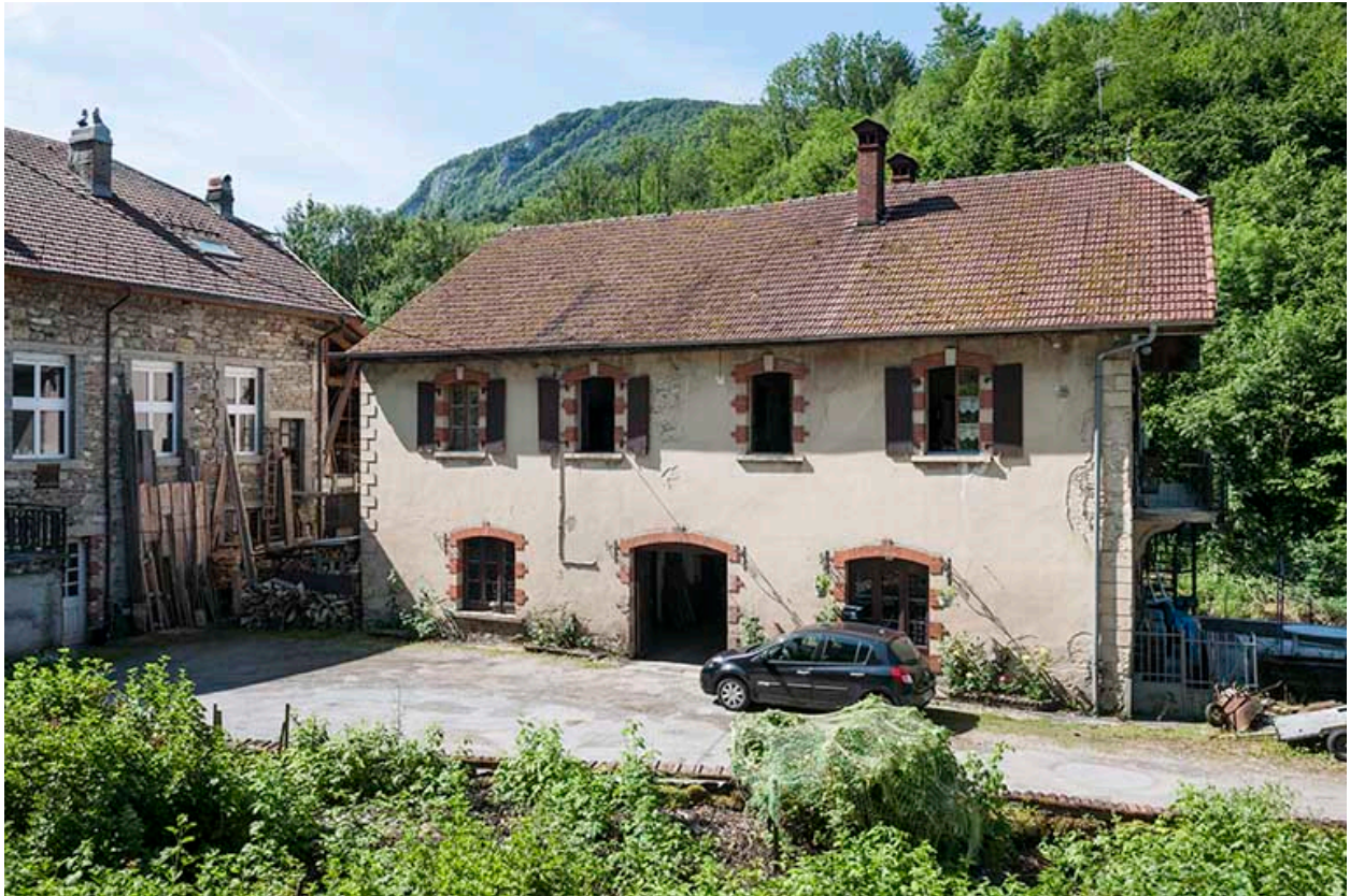
Vue depuis le nord.
