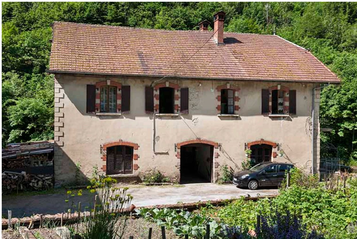
Atelier ouest (magasin et atelier de finissage)
