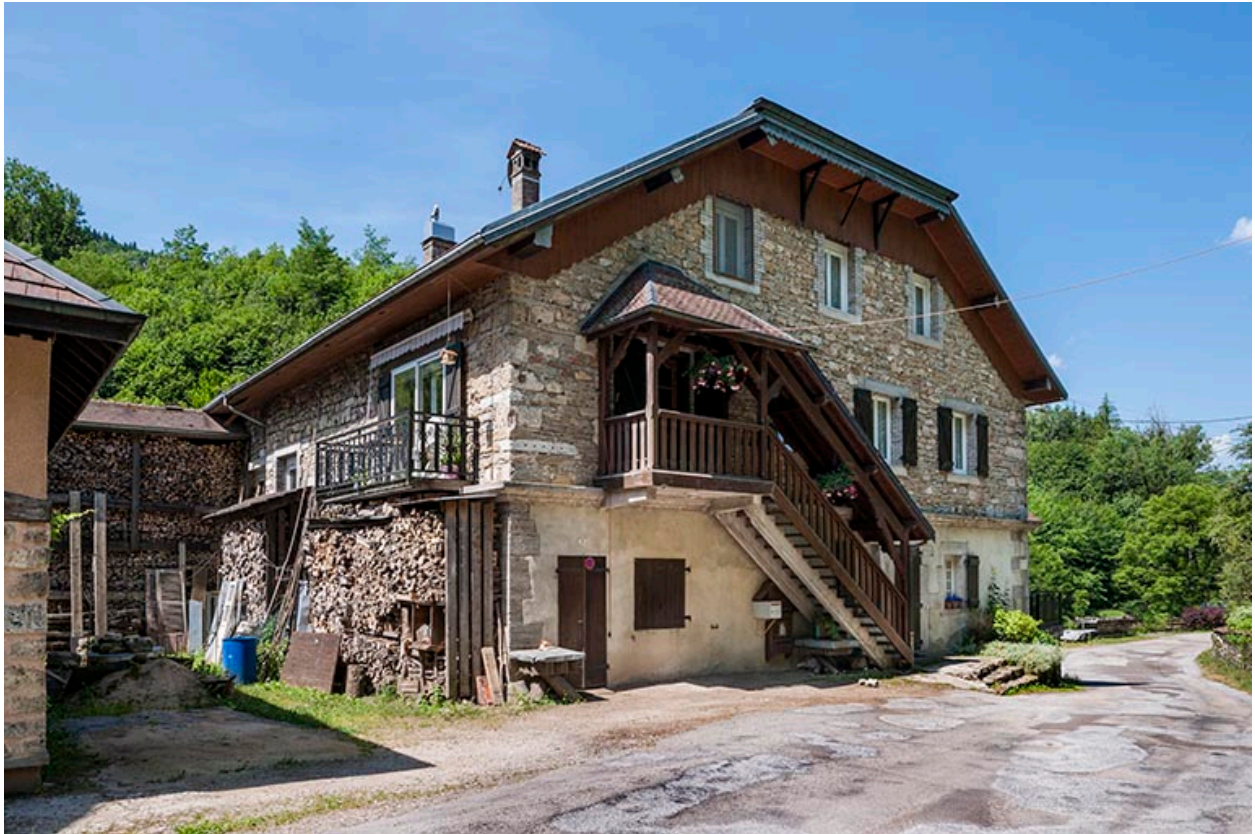
Atelier de fabrication vu de trois quarts arrière.
