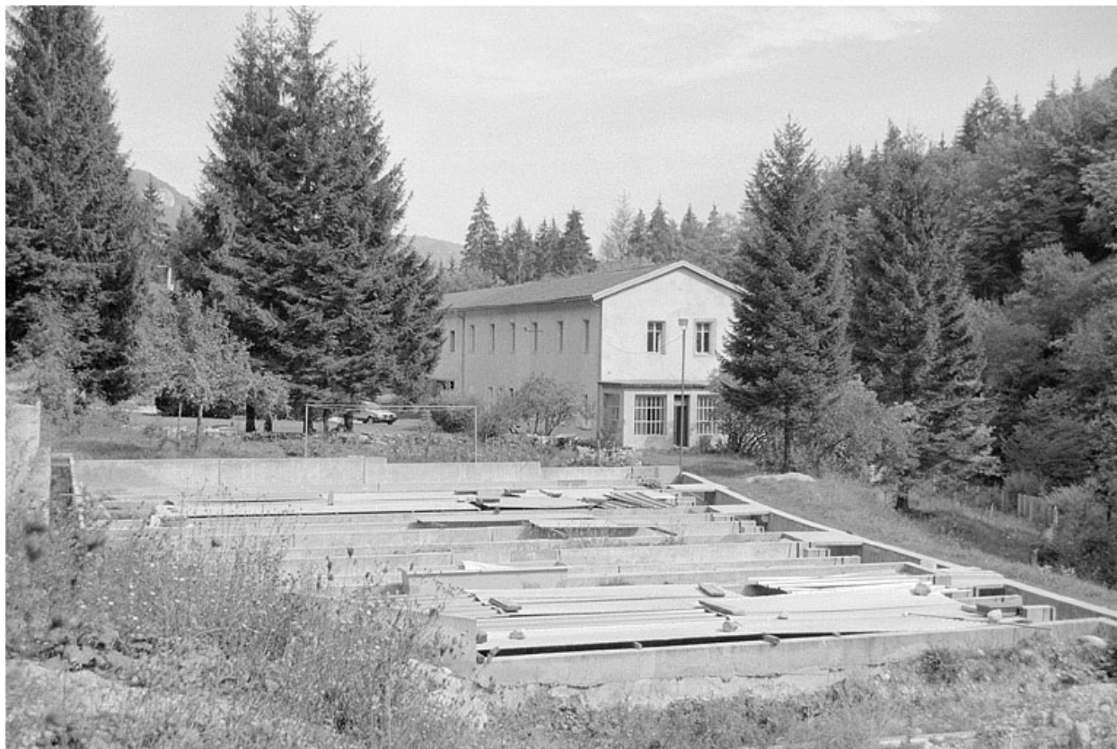
Bassins et bâtiment, depuis le sud-ouest.
