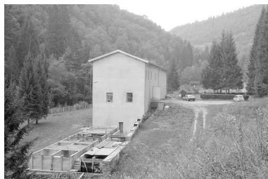
Bâtiment depuis le nord. Phot. Laurent Poupard IVR43_19903900522Z
