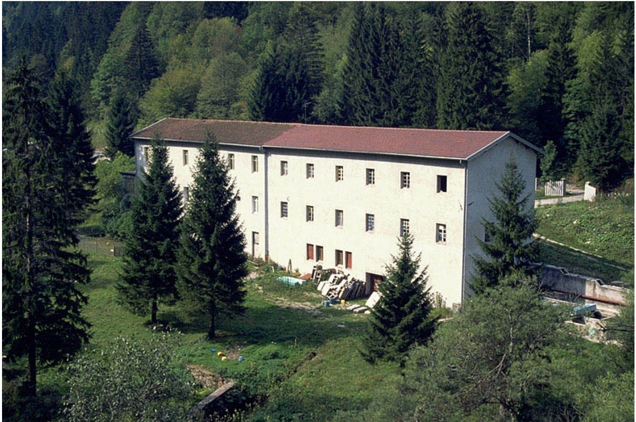
Vue d'ensemble depuis l'est (façade postérieure).
