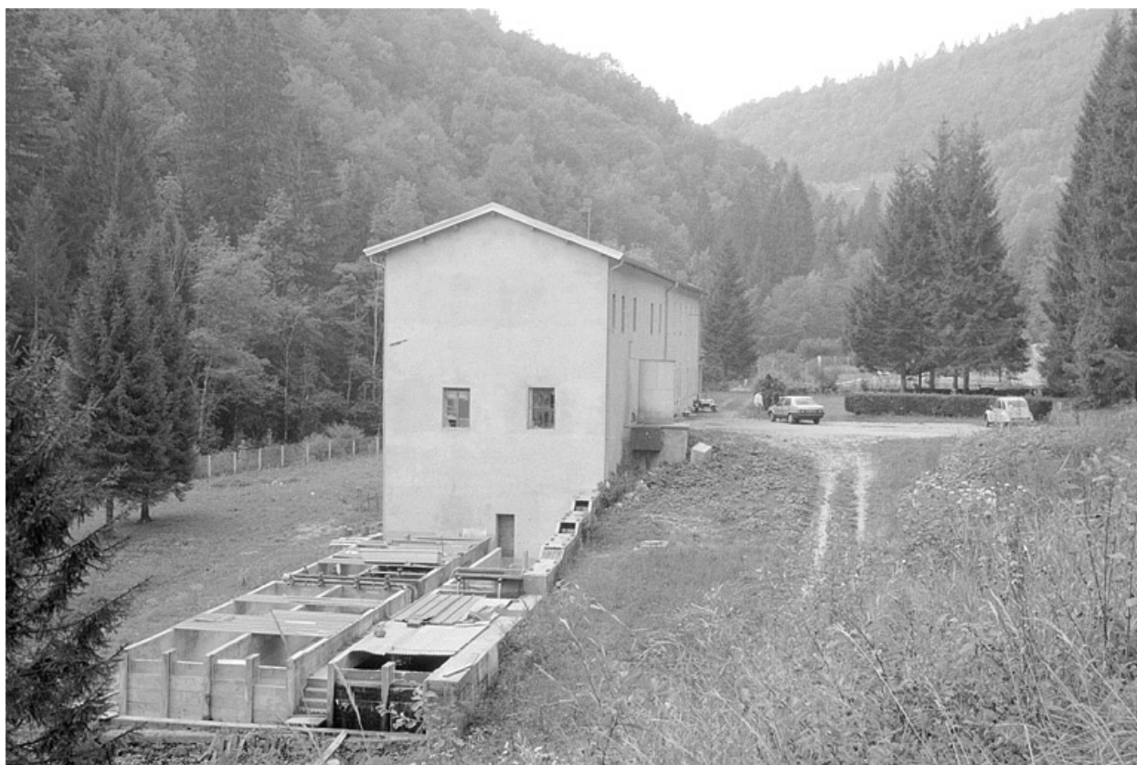
Bâtiment depuis le nord.
