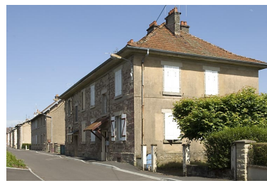
Enfilade de logements d'ouvriers (rue du Tissage). Phot. Jérôme Mongreville IVR43_20077000211NUCA
