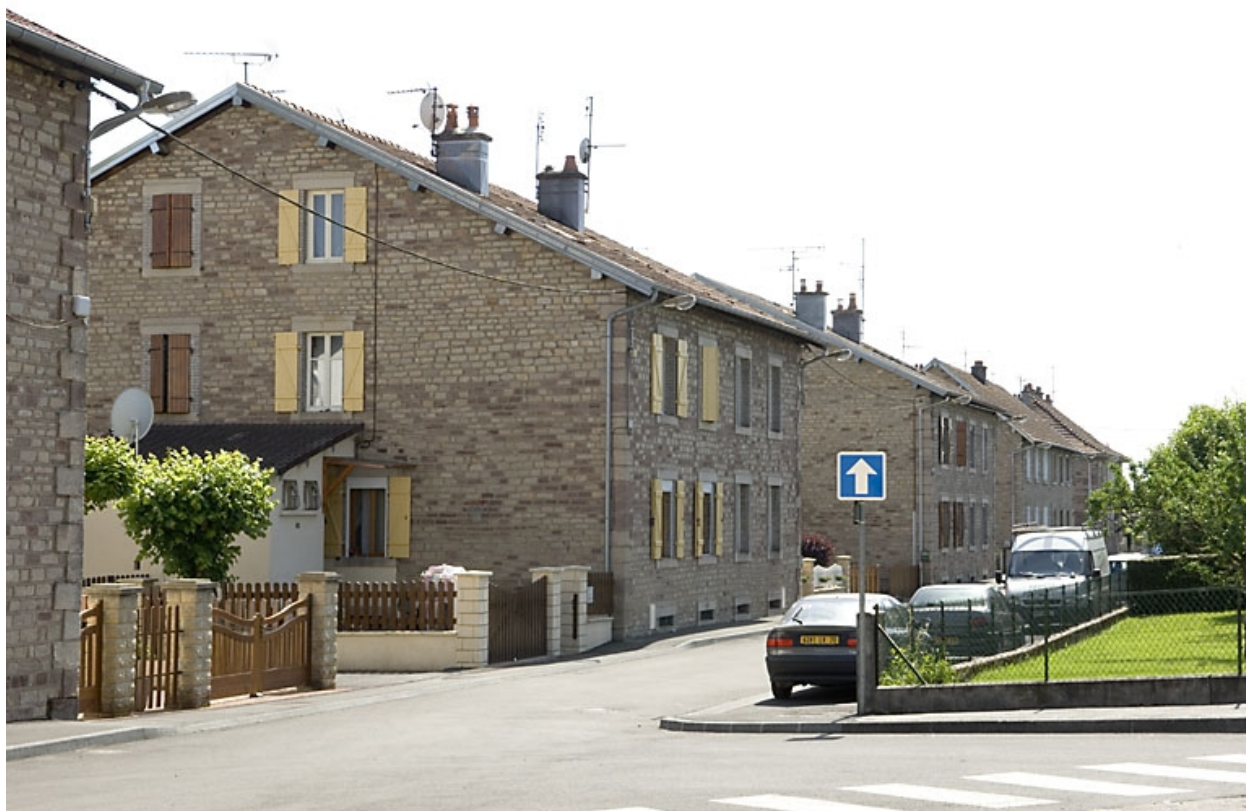
Logements d'ouvriers (rue du Tissage).
