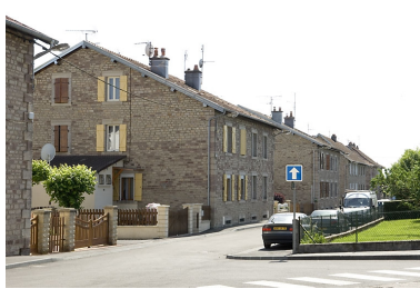
Logements d'ouvriers (rue du Tissage). Phot. Jérôme Mongreville IVR43_20077000210NUCA
