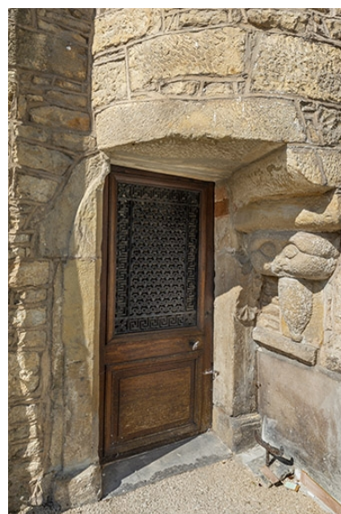
La porte de l'escalier. Phot. Jérôme Mongreville IVR43_20217000602NUC4A
