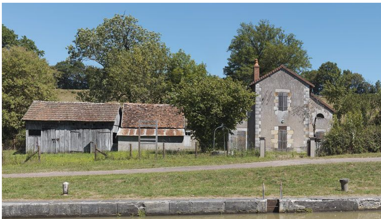
La maison éclésièr de face avec ses annexes.
