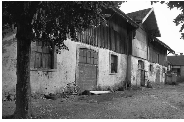
Cugney : ferme située rue de l'Eglise. Phot. Bernard Lardière IVR43_19797000231Z
