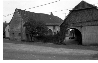
Tromarey : maison de vigneron située impasse de l'Eglise. Phot. Bernard Lardière IVR43_19797000036Z
