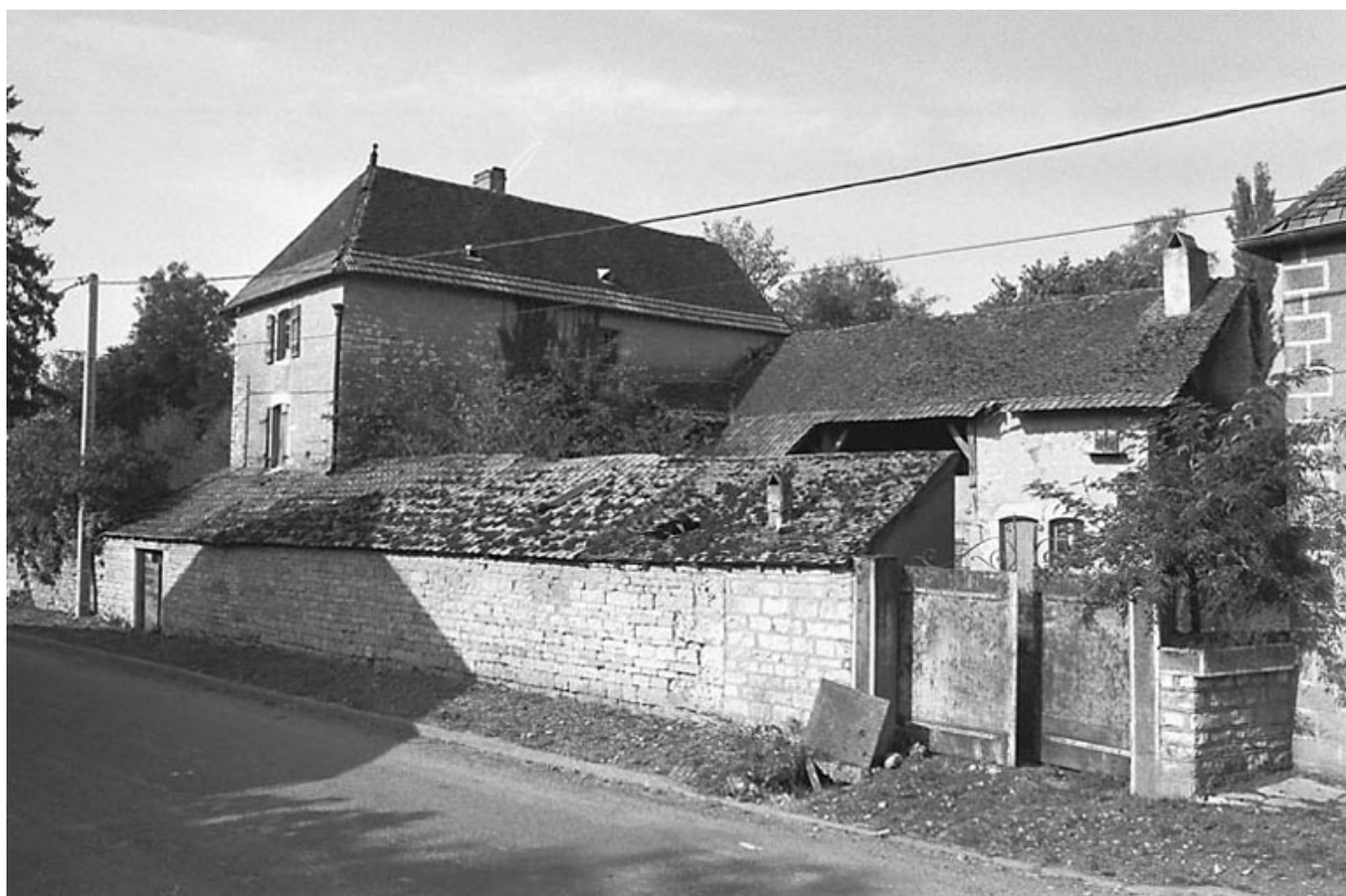
Chenevrey-et-Morogne : maison de vigneron située rue d'Aval.
