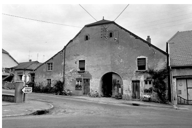
Pin : ferme située rue de Gezier. Phot. Bernard Lardière
