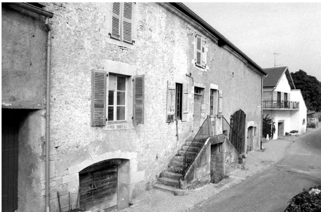
Hugier : ferme située rue de Pampouille.
