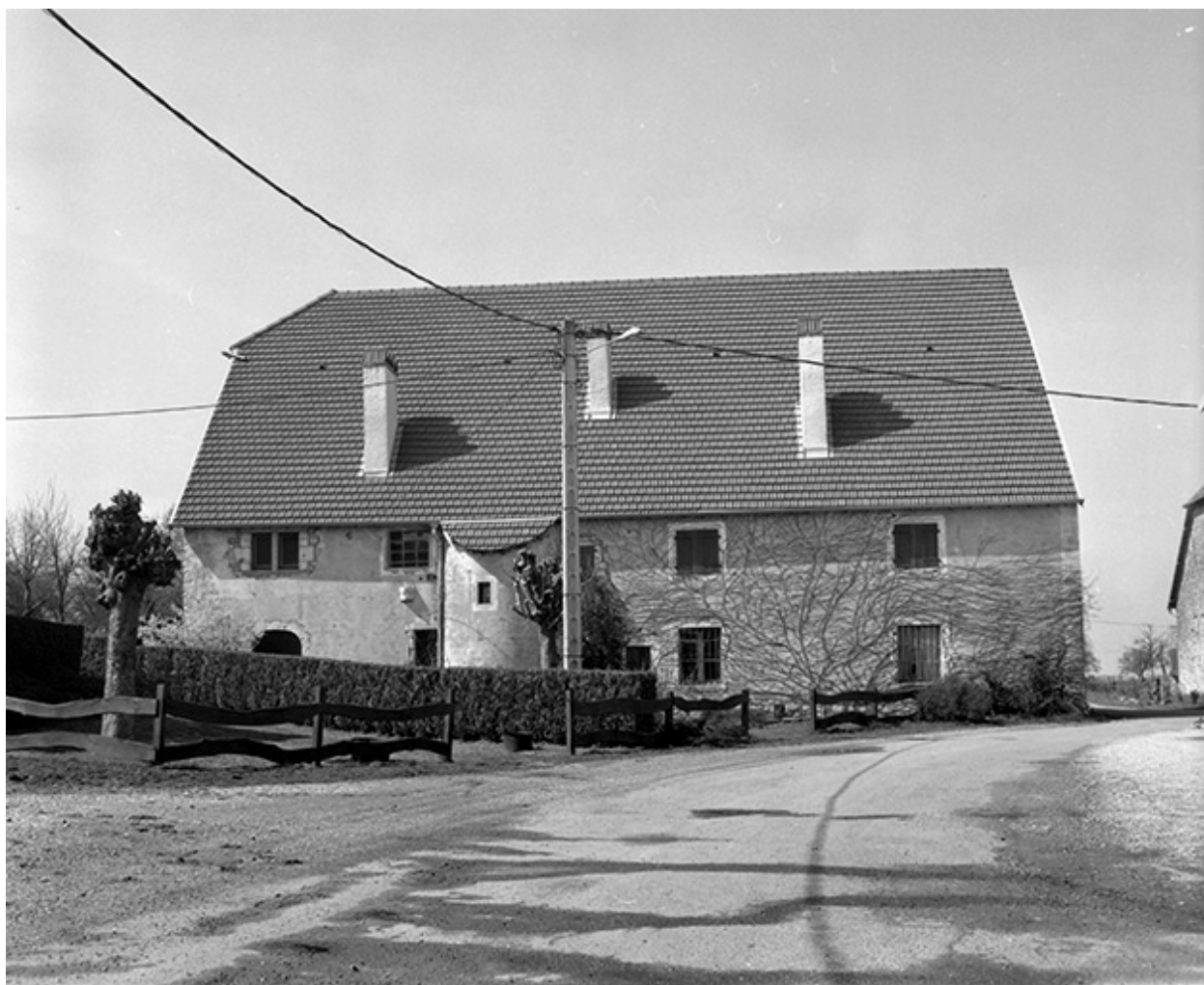
Bonboillon : ferme située place de la Mairie.
