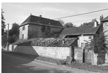
Chenevrey-et-Morogne : maison de vigneron située rue d'Aval. Phot. Bernard Lardière IVR43_19797000365Z
