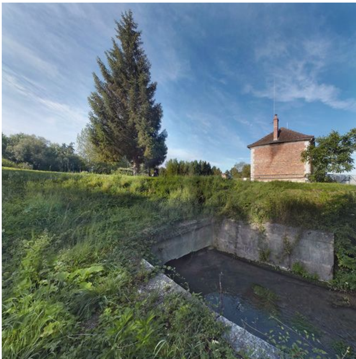
Entrée de l'aqueduc.
