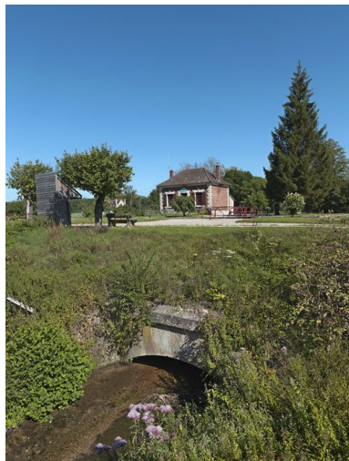
Sortie de l'aqueduc. Phot. Thierry Kuntz IVR26_20118900203NUC4A
