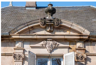
Façade est, détail : fronton. Phot. Jérôme Mongreville IVR43_20227000078NUC4A
