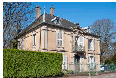
Façade est, vue de trois quarts. Phot. Jérôme Mongreville
