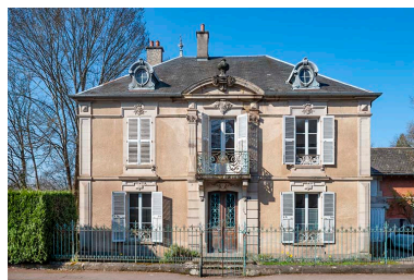
Façade est, vue de face. Phot. Jérôme Mongreville
