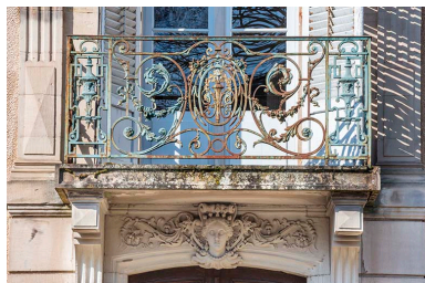
Façade est, détail : balcon. Phot. Jérôme Mongreville IVR43_20227000077NUC4A
