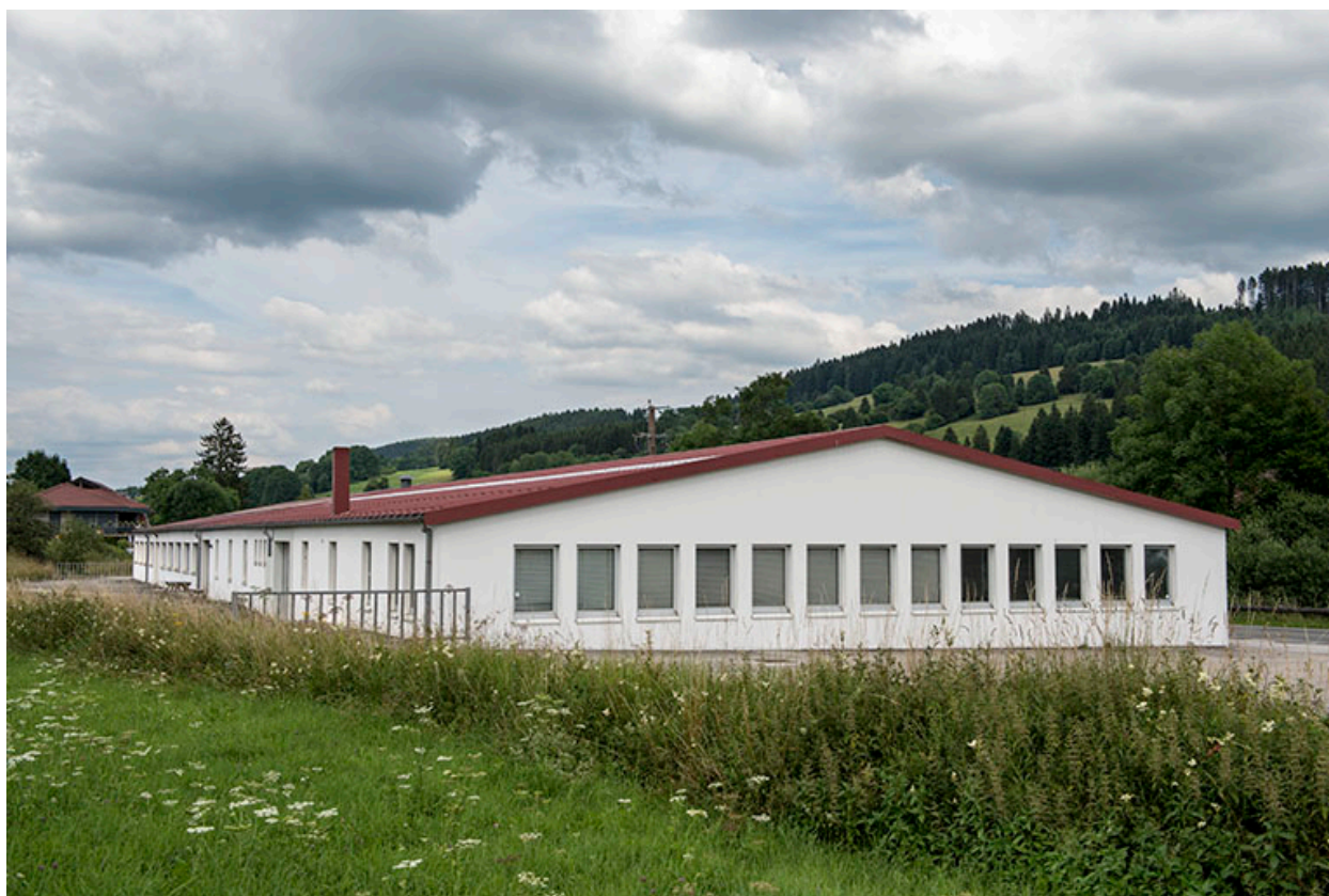
Façades postérieure et latérale gauche.
