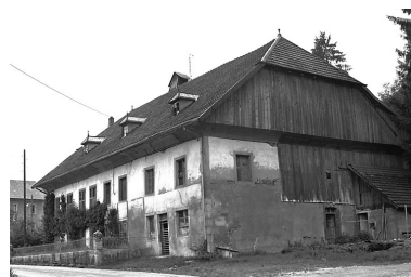
Ferme située en village. Phot. Yves Sancey IVR43_19762500721X
