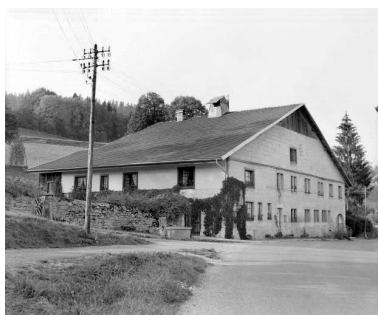
Ferme située en village. Phot. Yves Sancey IVR43_19762500675X
