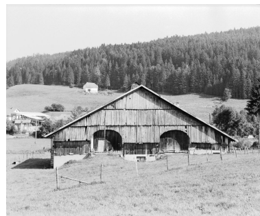
Ferme située au lieudit Cornabey : façade postérieure : deux " levées de grange " et " lambréchure ". Phot. Dominique Dominguez IVR43_19762500673X
