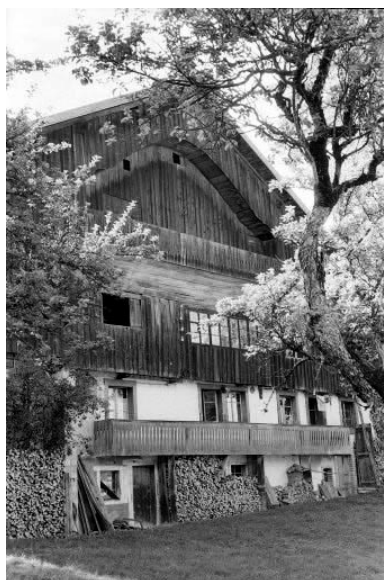
Ferme située au lieu-dit Cornabey. Phot. Yves Sancey IVR43_19742500797Z
