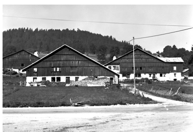
hameau des Cordiers : façades antérieures des fermes. Phot. Yves Sancey IVR43_19762500738V
