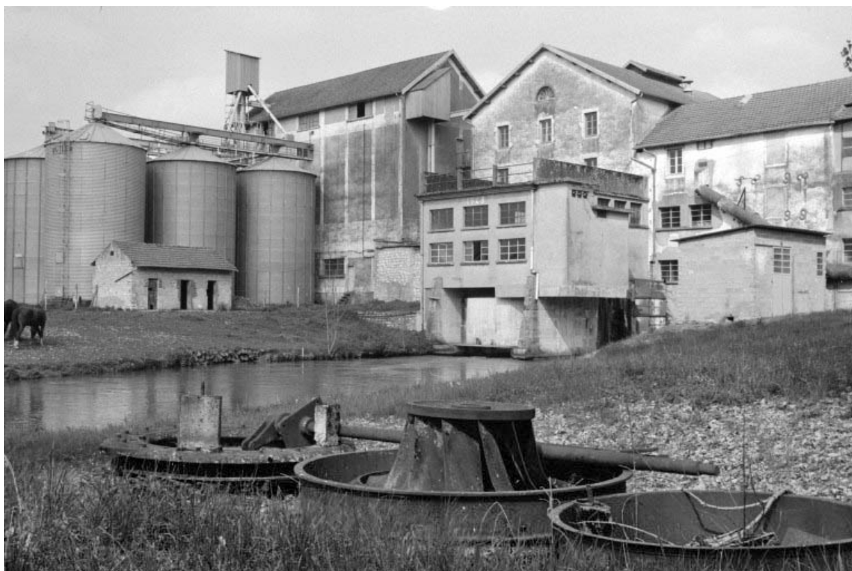
Bâtiment d'eau (J), ateliers de fabrication (L, M) et silos (C, D) vus du sud-ouest. Eléments d'une turbine Singrun au premier plan.
