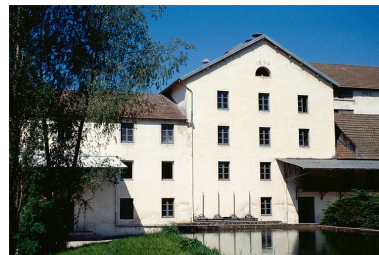
Façade antérieure de l'atelier de fabrication (L).
