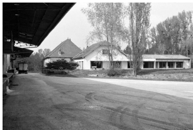
Façade postérieure du bureau.
