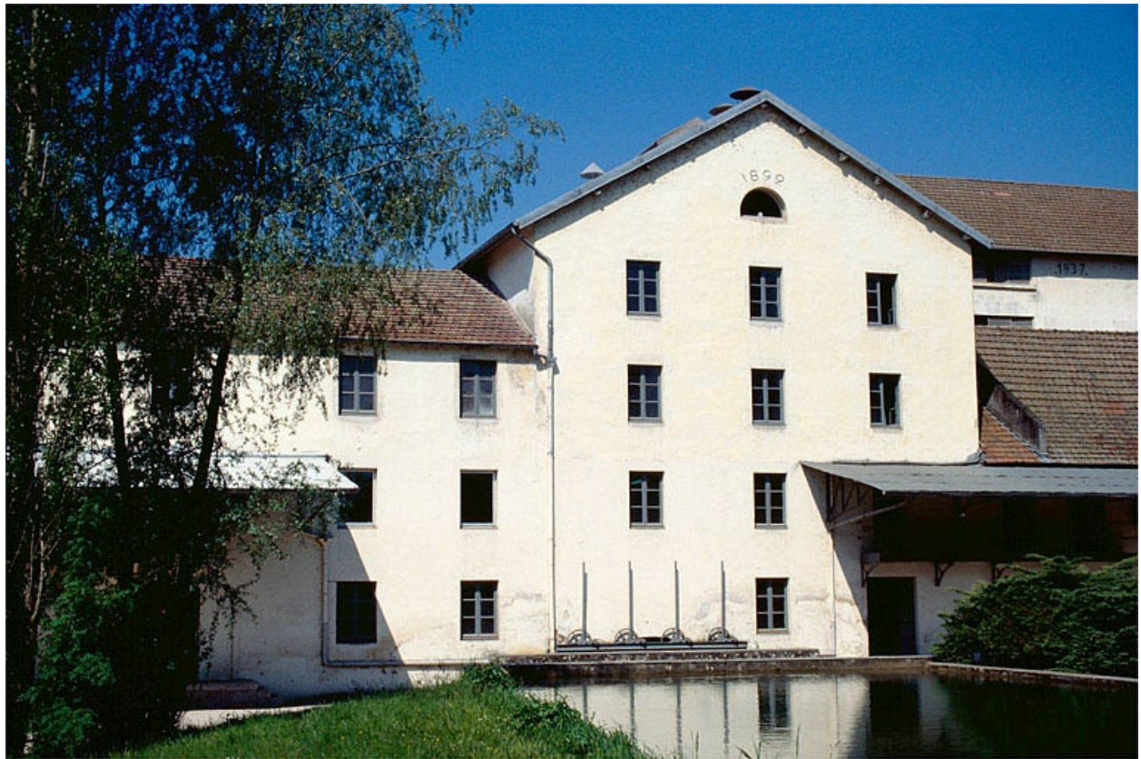
Façade antérieure de l'atelier de fabrication (L).
