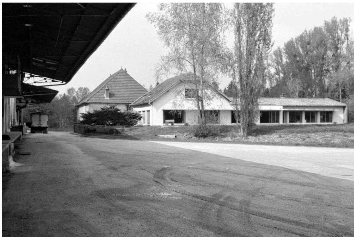
Façade postérieure du bureau.
