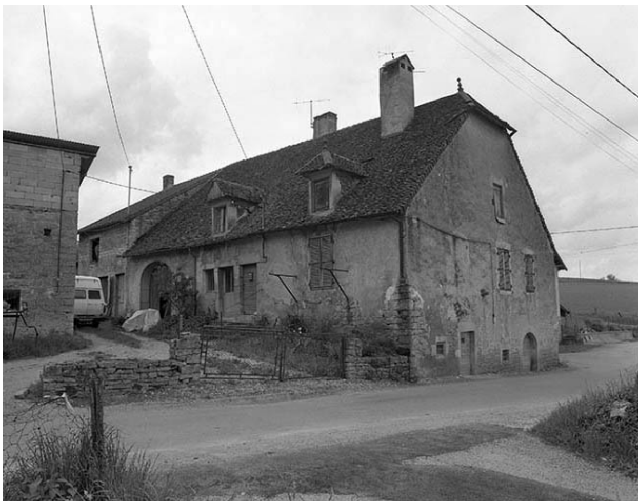
Ferme située rue des Louvarets : vue d'ensemble.
