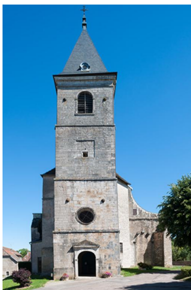
Façade ouest Phot. Jérôme Mongreville IVR43_20137000241NUCA
