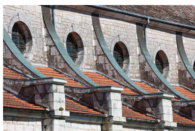
Détail des oculi de la façade sud Phot. Jérôme Mongreville IVR43_20137000223NUCA
