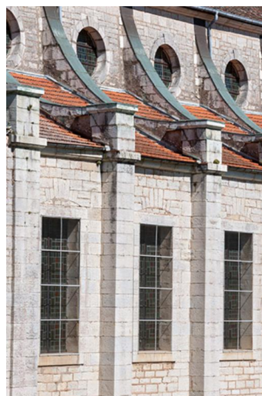
Détail de la façade sud Phot. Jérôme Mongreville IVR43_20137000224NUCA
