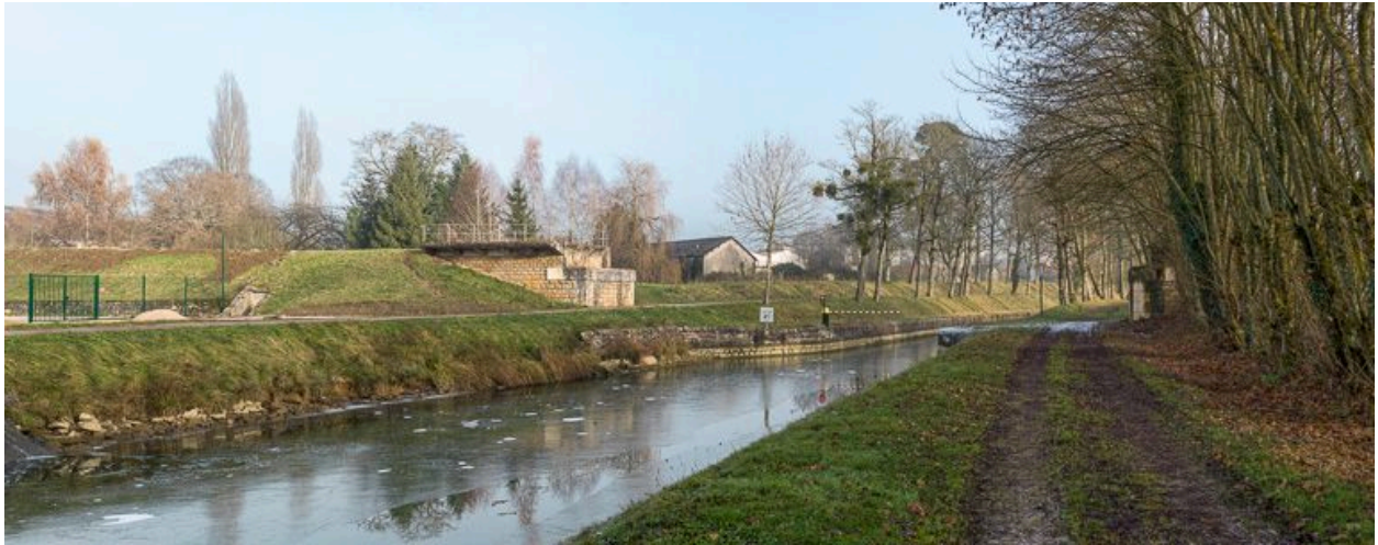
Vue d'aval des culées.
