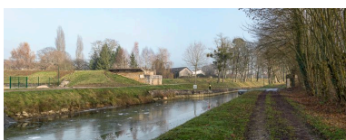
Vue d'aval des culées.
