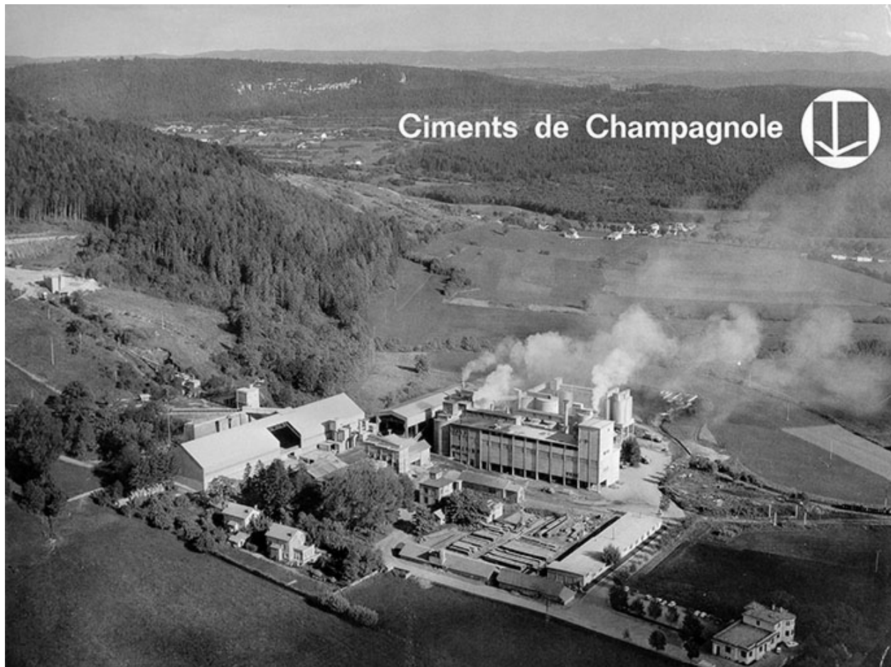
Vue aérienne de la cimenterie de Champagnole.
