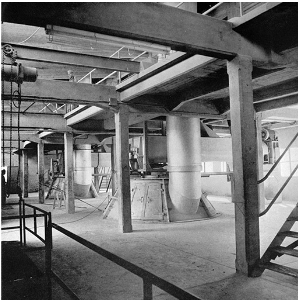
Etage supérieur des fours.
