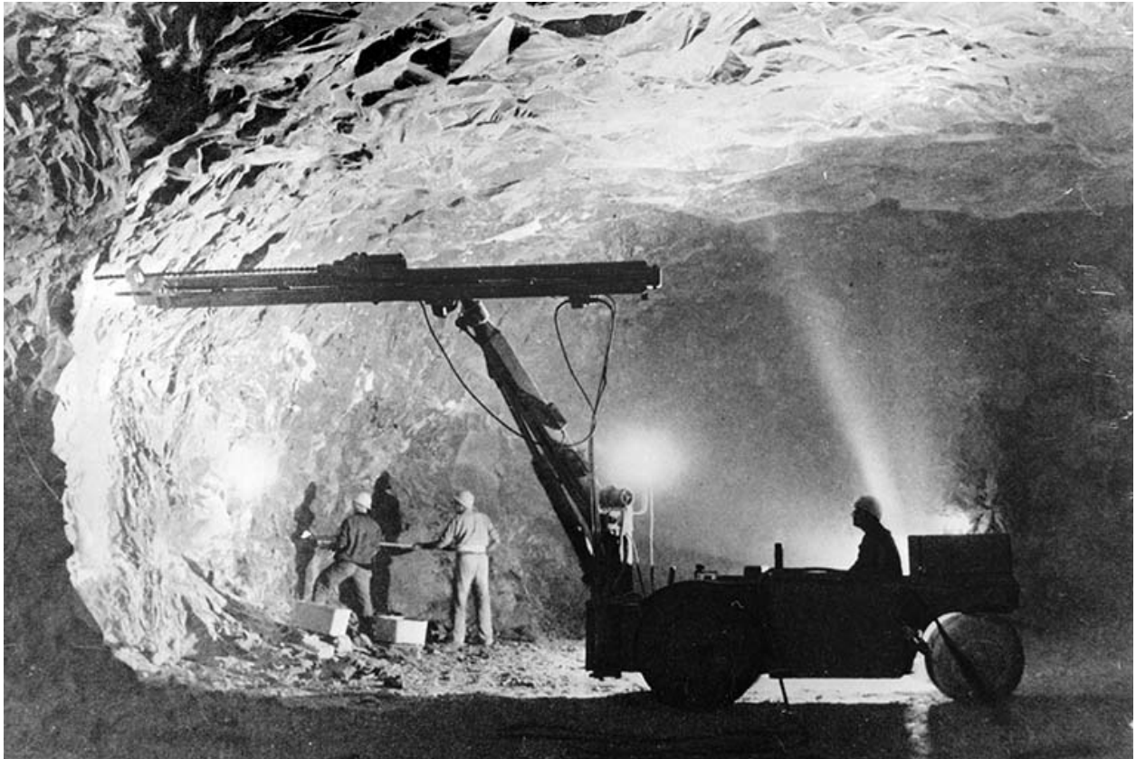
Carrière - Minage avec perforatrice sur jumbo.
