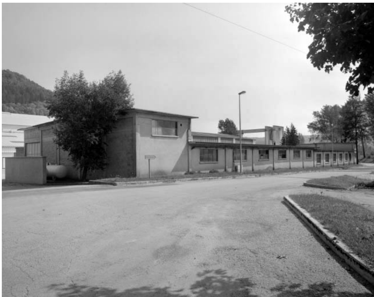
Façade ouest de l'atelier de réparation.
