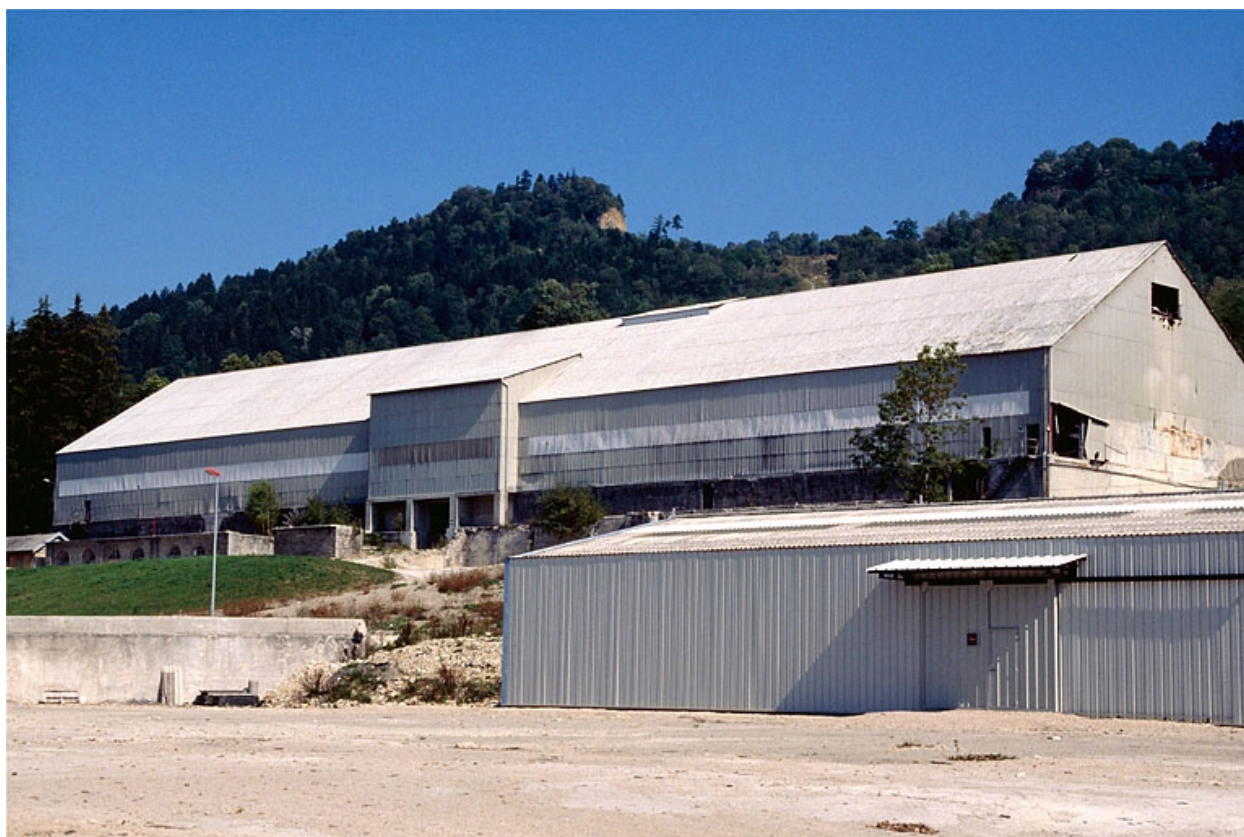
Hall de préhomogénéisation.
