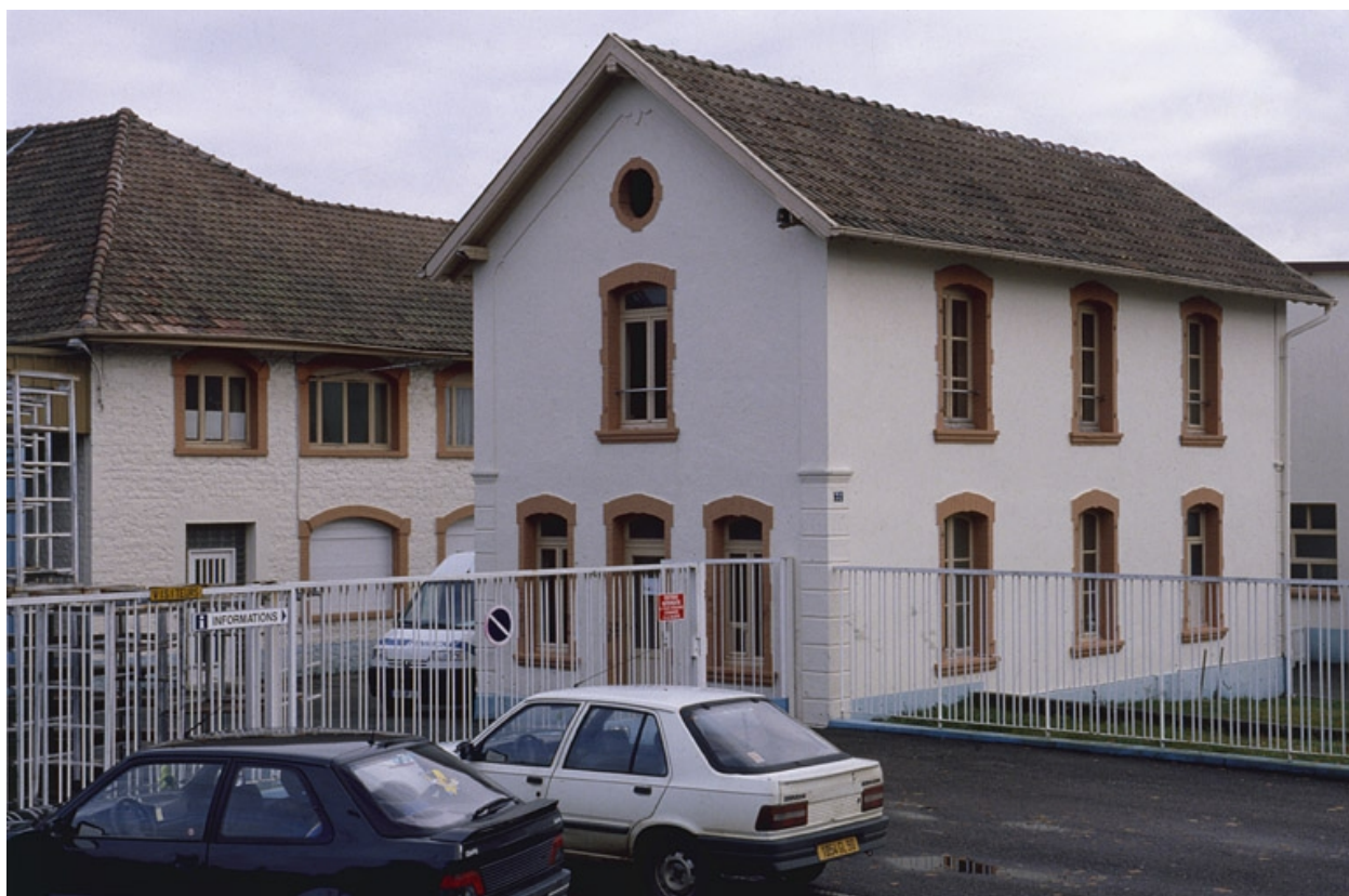
Anciens bureaux (?) de l'usine de teinturerie.
