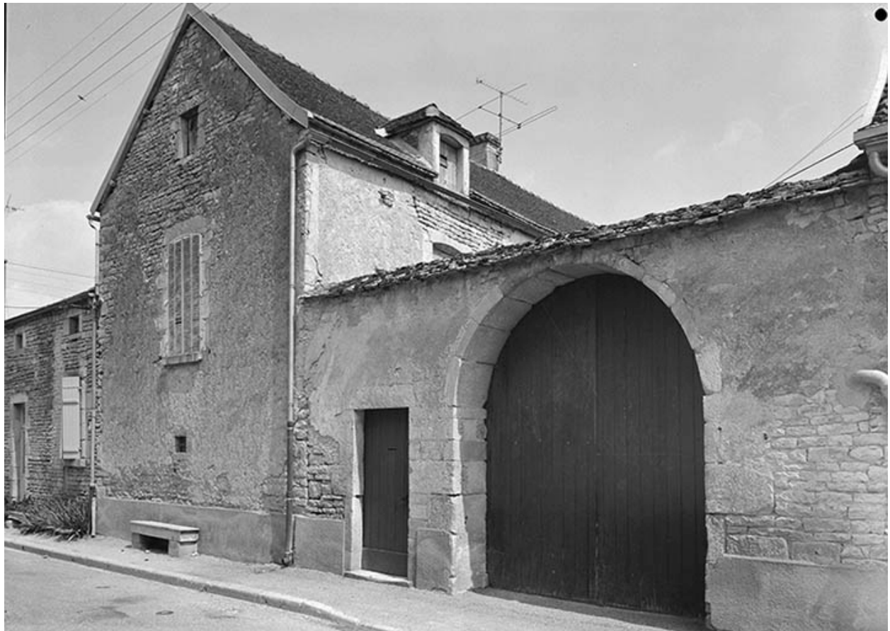
Mur-pignon et portail sur rue.
