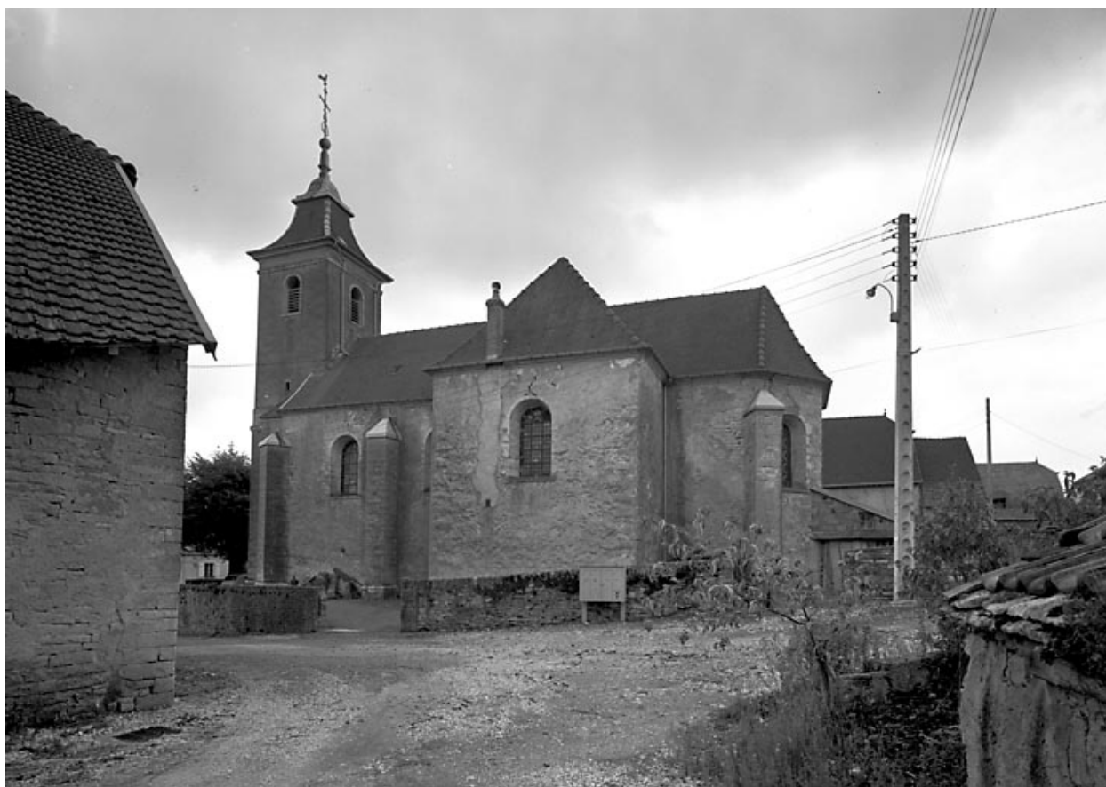
Façade latérale droite.
