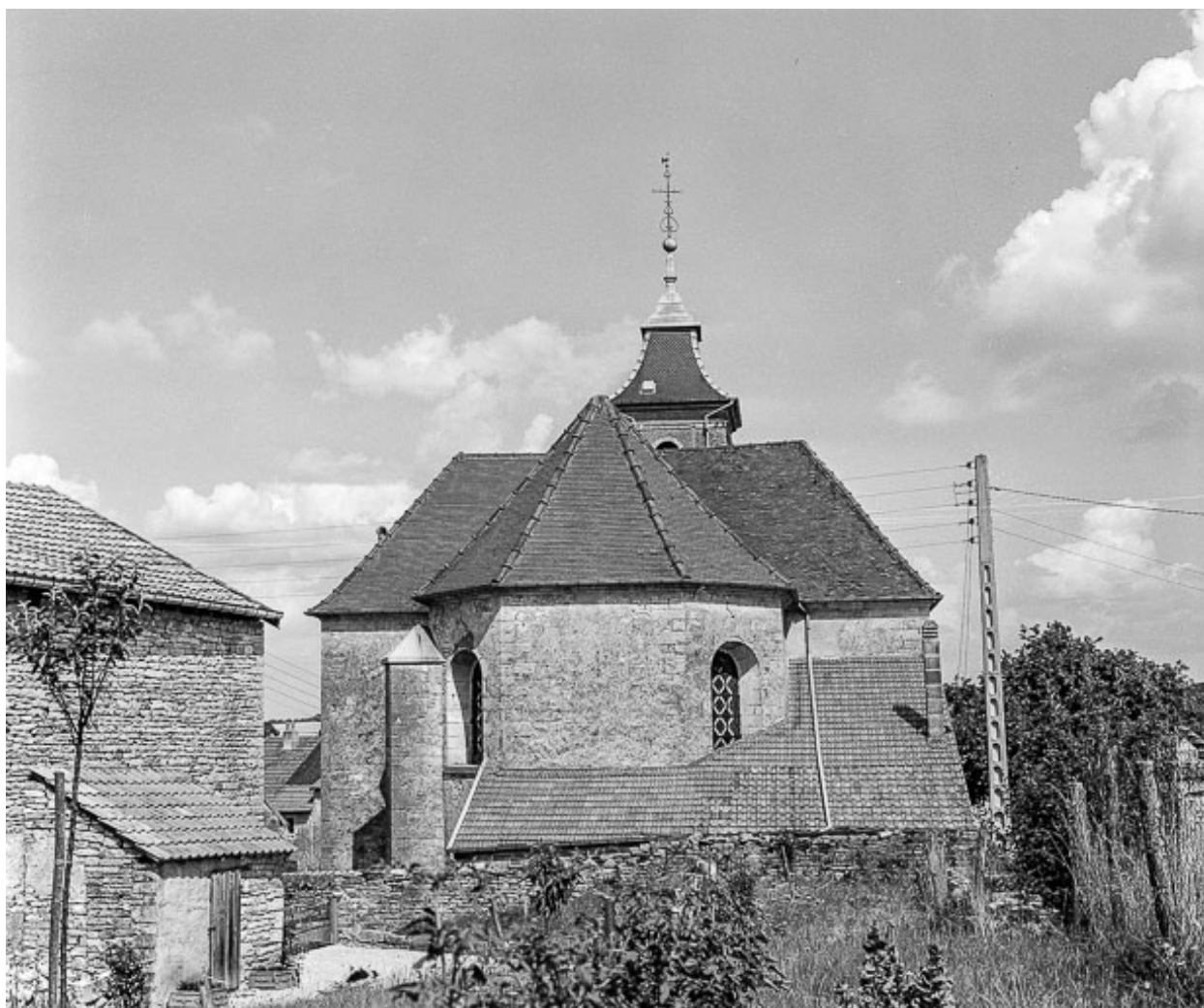
Choeur et toit de la sacristie.
