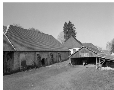
Vue de la halle à charbon. Phot. Yves Sancey IVR43_19857000048X
