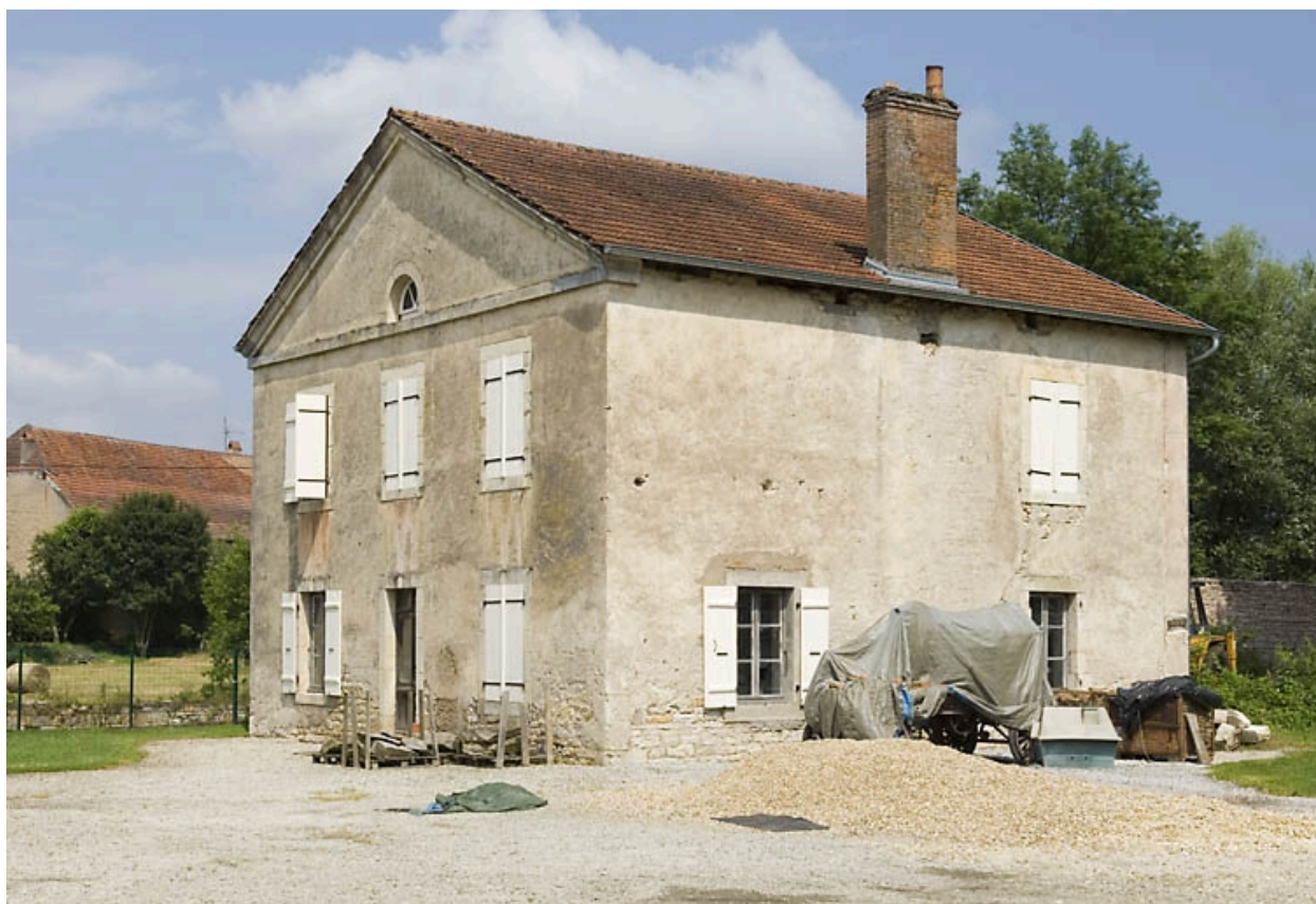
Logement patronal vu de trois quarts.
