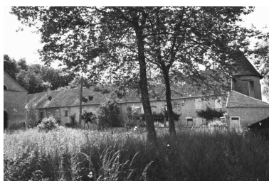
Vue d'ensemble du logement ouvrier en 1981. Phot. Bernard Lardière IVR43_19817000173Z
