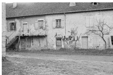
Logement ouvrier. Partie sud en 1979. Phot. Jack Dumont IVR43_19797000466Z
