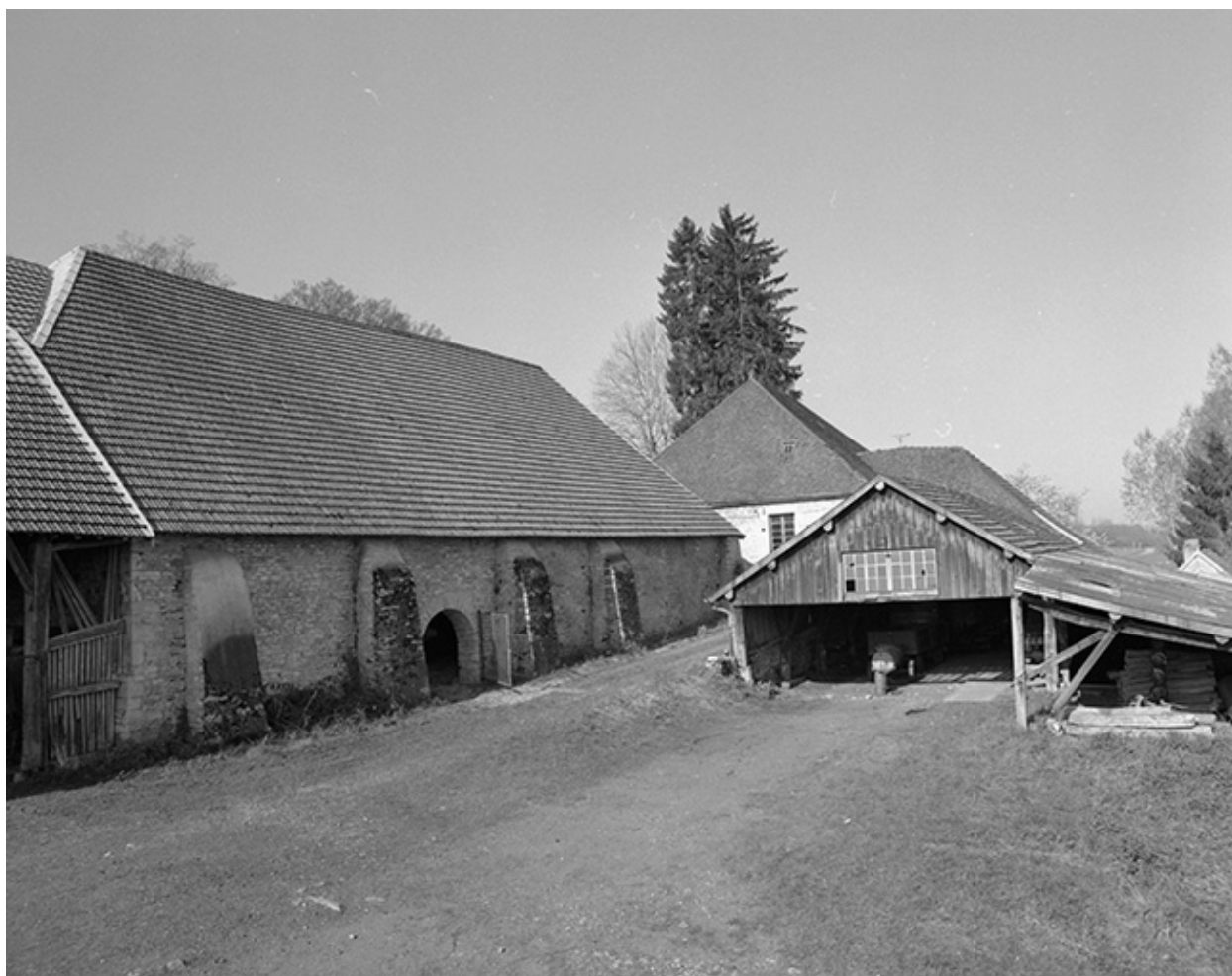
Vue de la halle à charbon.
