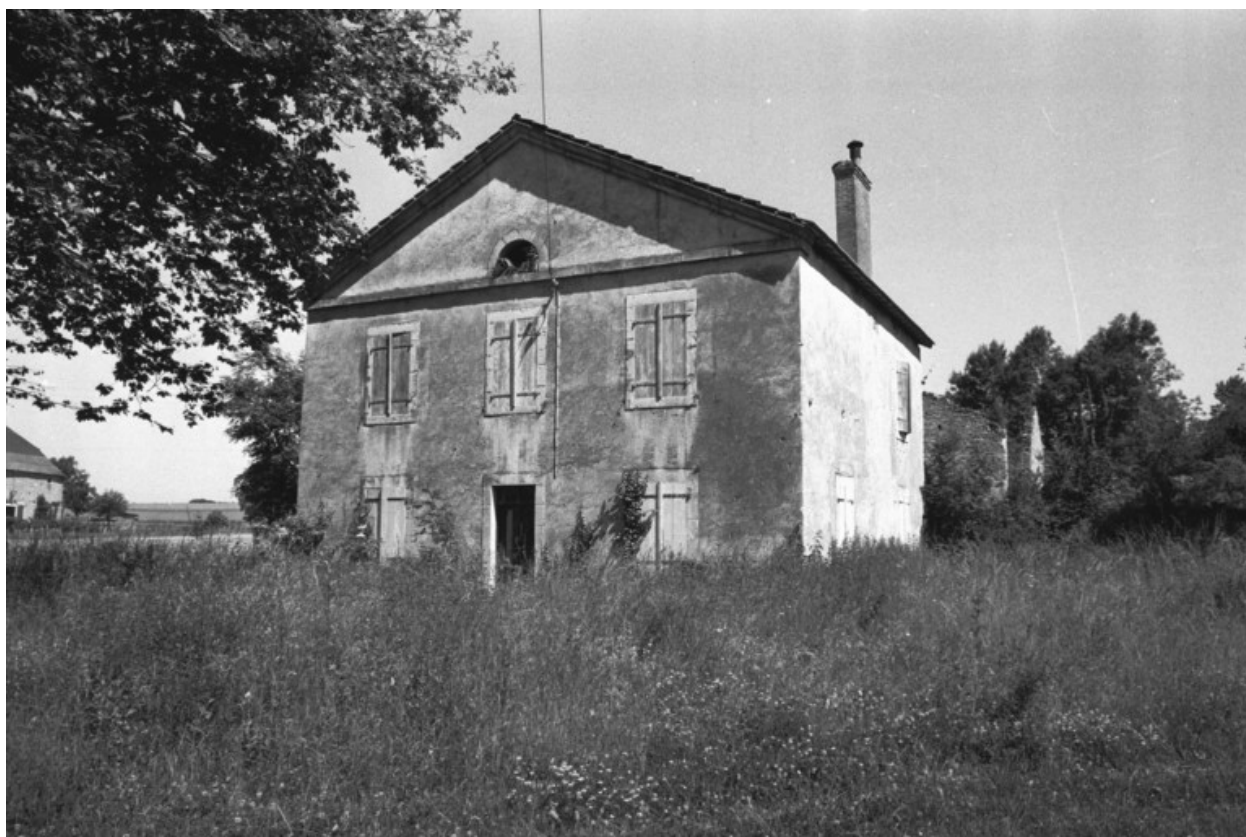
Logement patronal. Vue de trois quarts en 1981.
