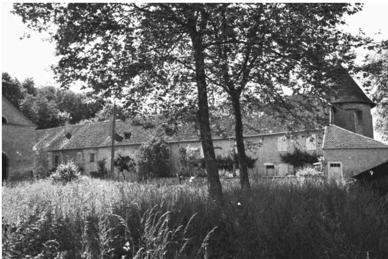
Vue d'ensemble du logement ouvrier en 1981.
