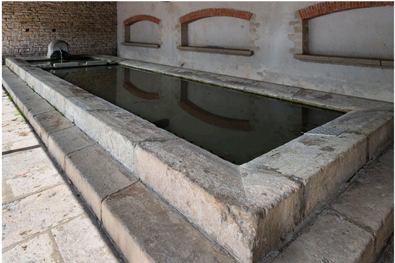
Bassin du lavoir.
