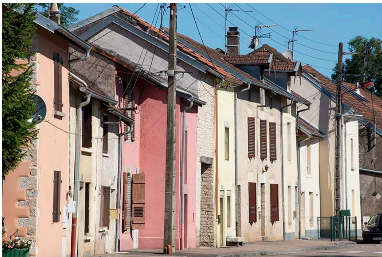
Alignement de maisons, rue du Magny.
