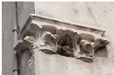
Vestiges de l'ancienne chapelle. Phot. Jérôme Mongreville IVR43_20177001071NUC4A
