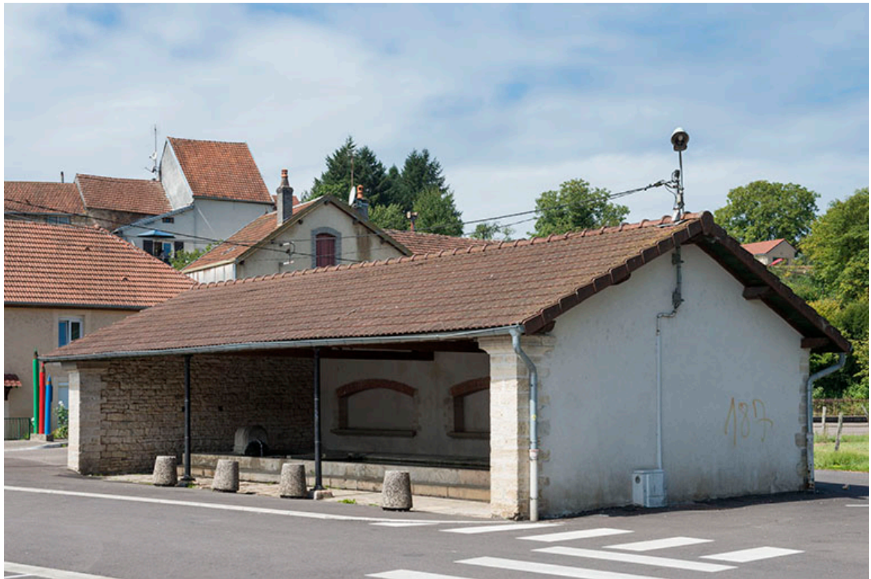
Le lavoir couvert, rue de Remaucourt.
