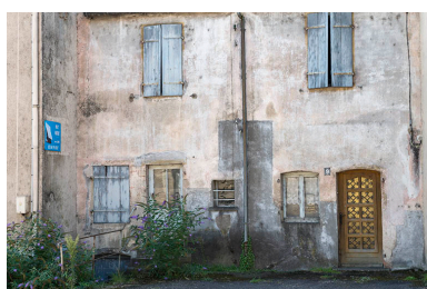
Logements ouvriers. Phot. Jérôme Mongreville IVR43_20177001080NUC4A
