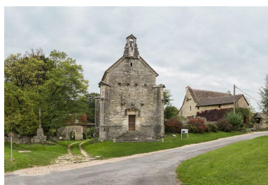
Vue d'ensemble. Phot. Pierre-Marie Barbe-Richaud IVR26_20137100007NUC4AQ
