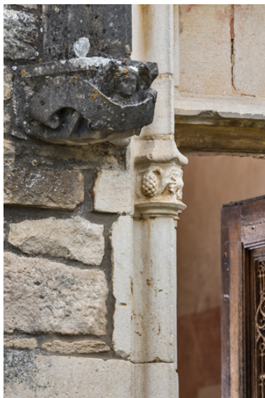
Piédroit, détail de la partie supérieure, gauche. Phot. Pierre-Marie Barbe-Richaud IVR26_20237100218NUC4A
