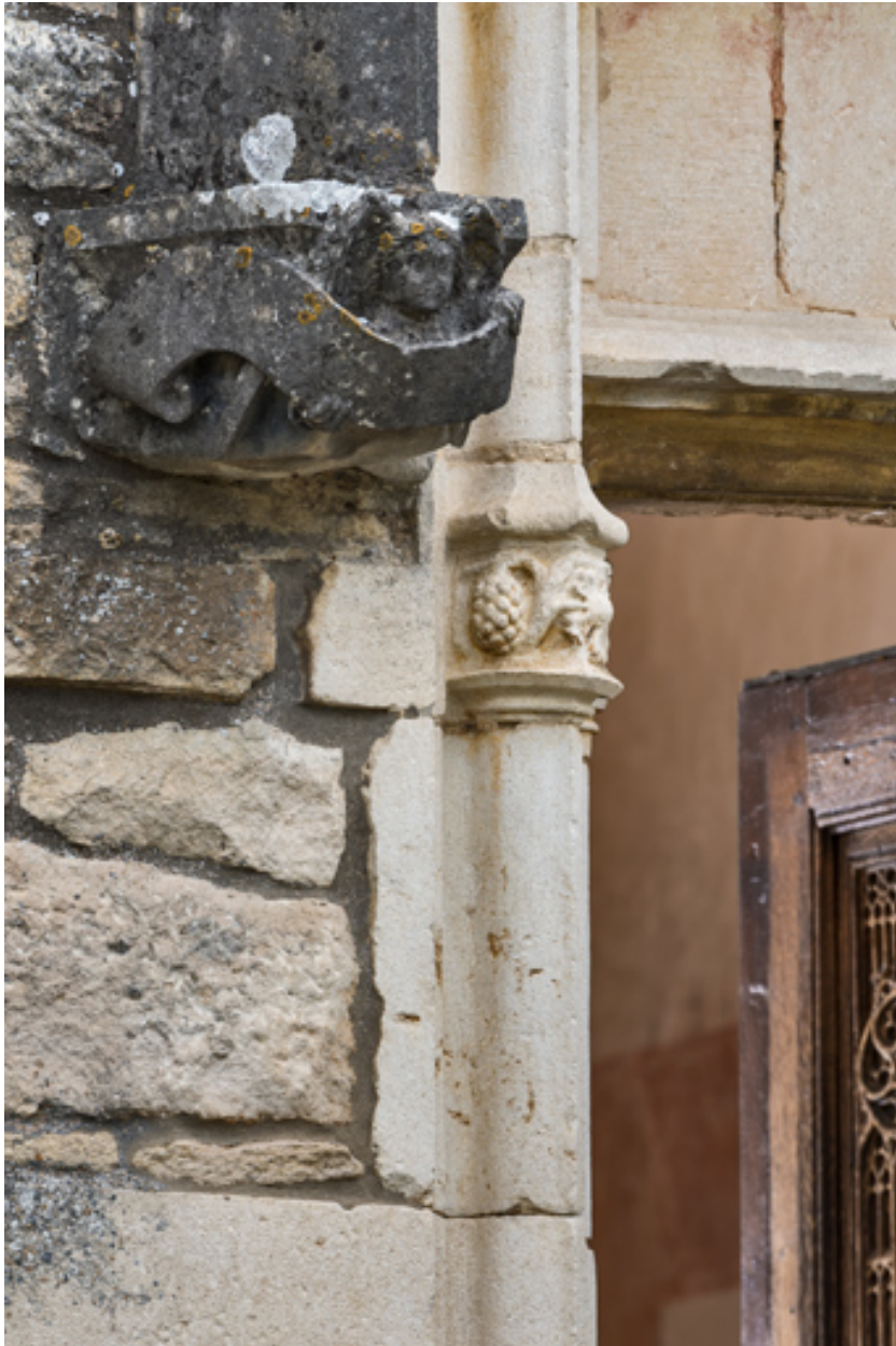
Piédroit, détail de la partie supérieure, gauche.
