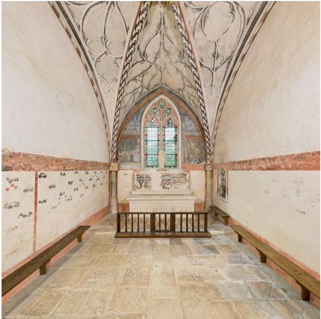
Vue d'ensemble de l'intérieur, depuis l'entrée.
