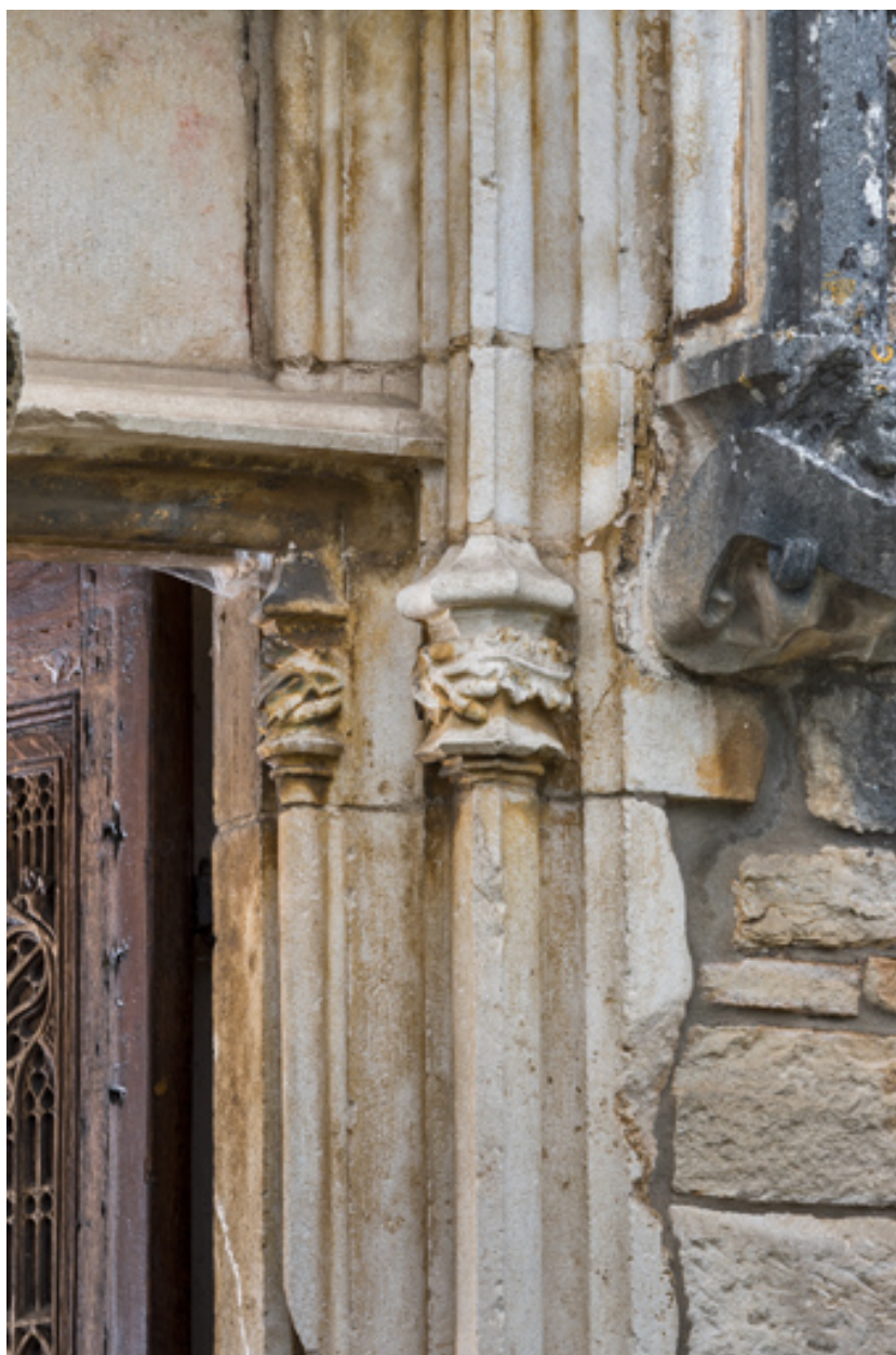
Piédroit, détail de la partie supérieure, droite.
