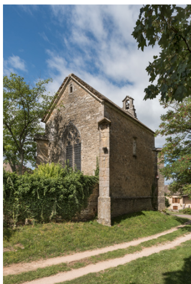
Vue d'ensemble depuis l'est. Phot. Pierre-Marie Barbe-Richaud IVR26_20237100241NUC4A
