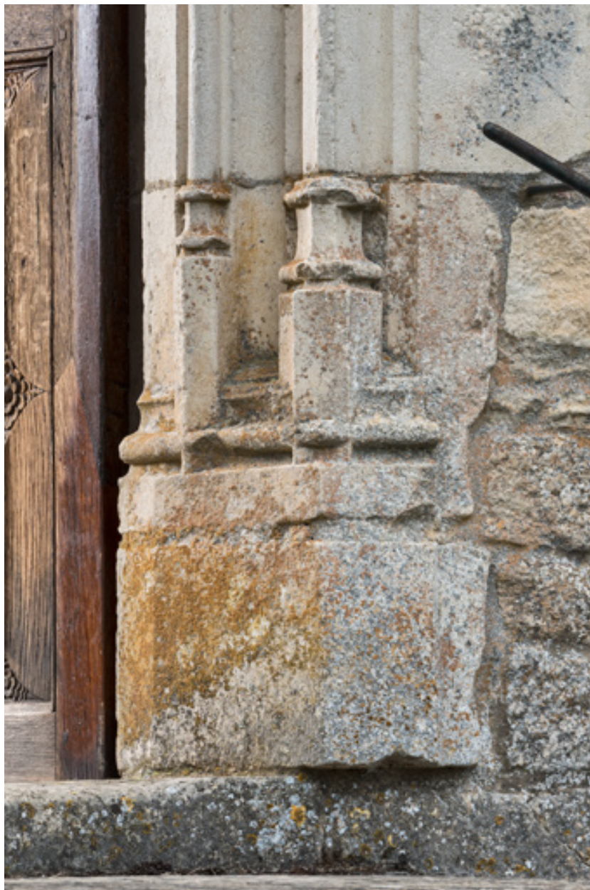
Piédroit, détail de la partie inférieure, droite.
