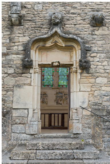
Porte en façade occidentale (vantaïl ouvert). Phot. Pierre-Marie Barbe-Richaud IVR26_20237100225NUC4A
