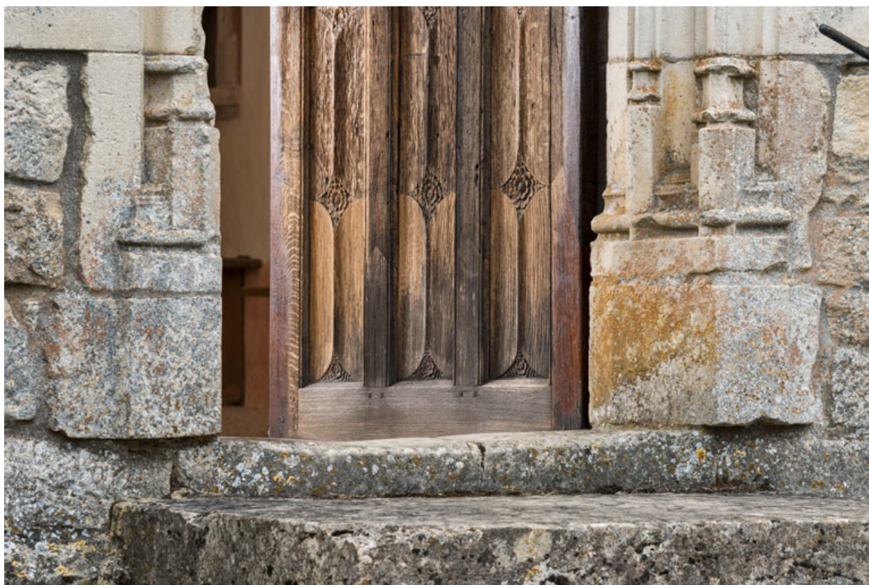
Piédroit, détail de la partie inférieure.
