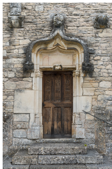
Porte en façade occidentale (vantail fermé). Phot. Pierre-Marie Barbe-Richaud IVR26_20237100226NUC4A
