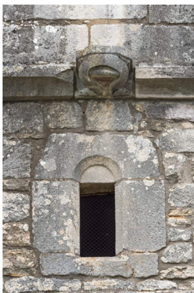
Baie sur comble. Phot. Pierre-Marie Barbe-Richaud IVR26_20237100240NUC4A
