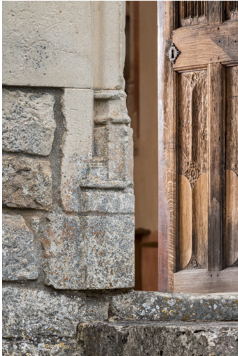
Piédroit, détail de la partie inférieure, gauche.
