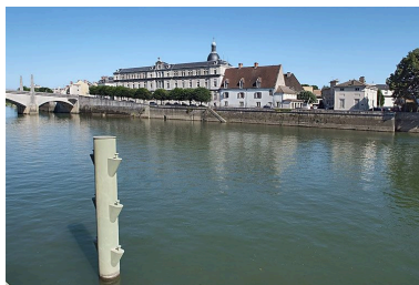
Le quai vu d'aval et depuis la rive droite en 2008. Phot. Thierry Kuntz IVR26_20087100346NUC2A
