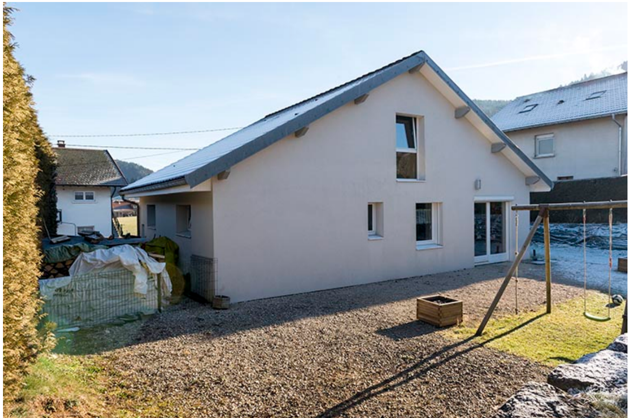
Façades postérieure et latérale droite.
