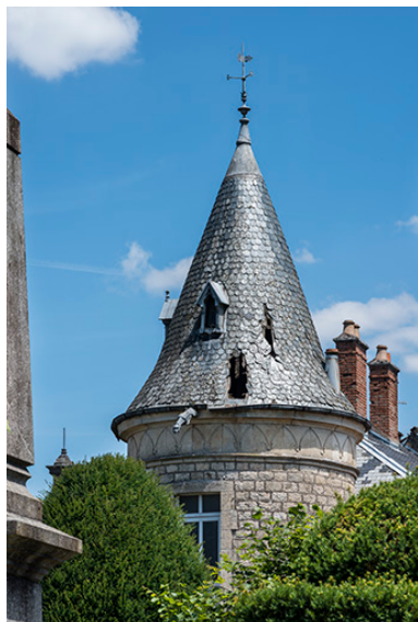
Toiture de la tour.
