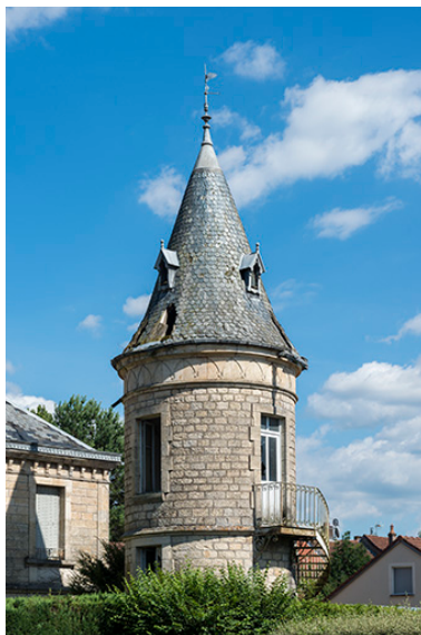
Tour, vue depuis le nord.
